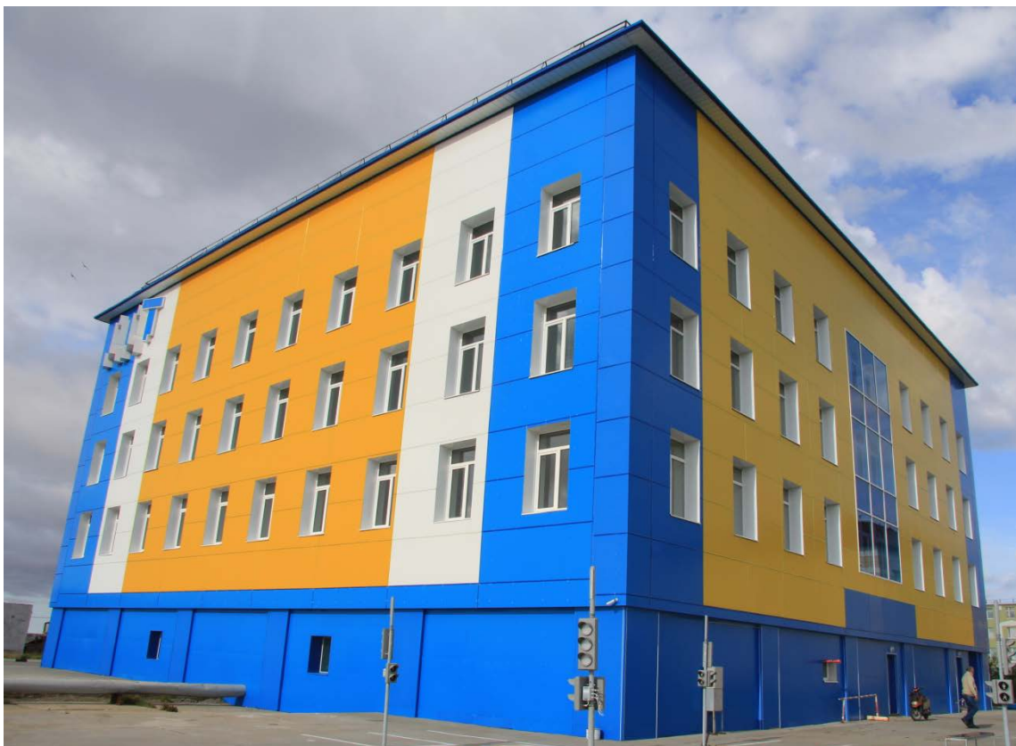
Вид на дворový фасад. Август 2017 года.
