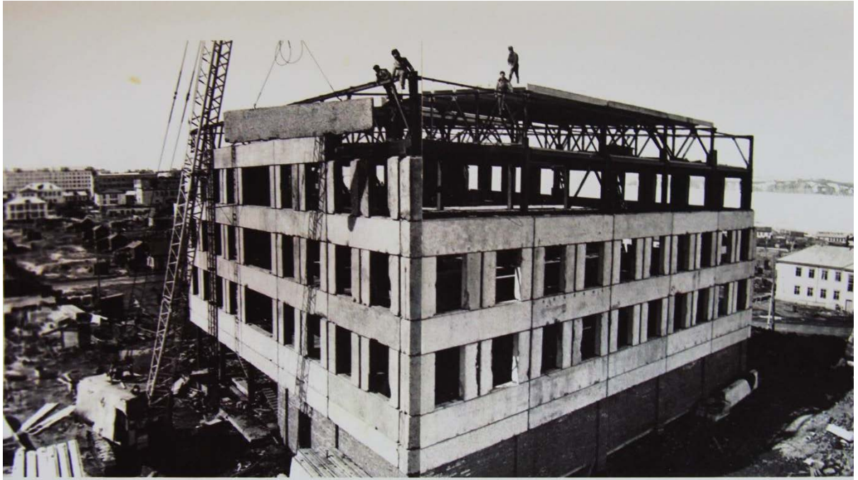
Завершается монтаж Дворца Пионеров. Май 1973 года.
