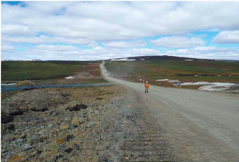
Рис. 79. Общий вид с востока, с участка Морошка, на восточную часть автодороги Купол-Морошка и место перехода через руч. Морошка.
