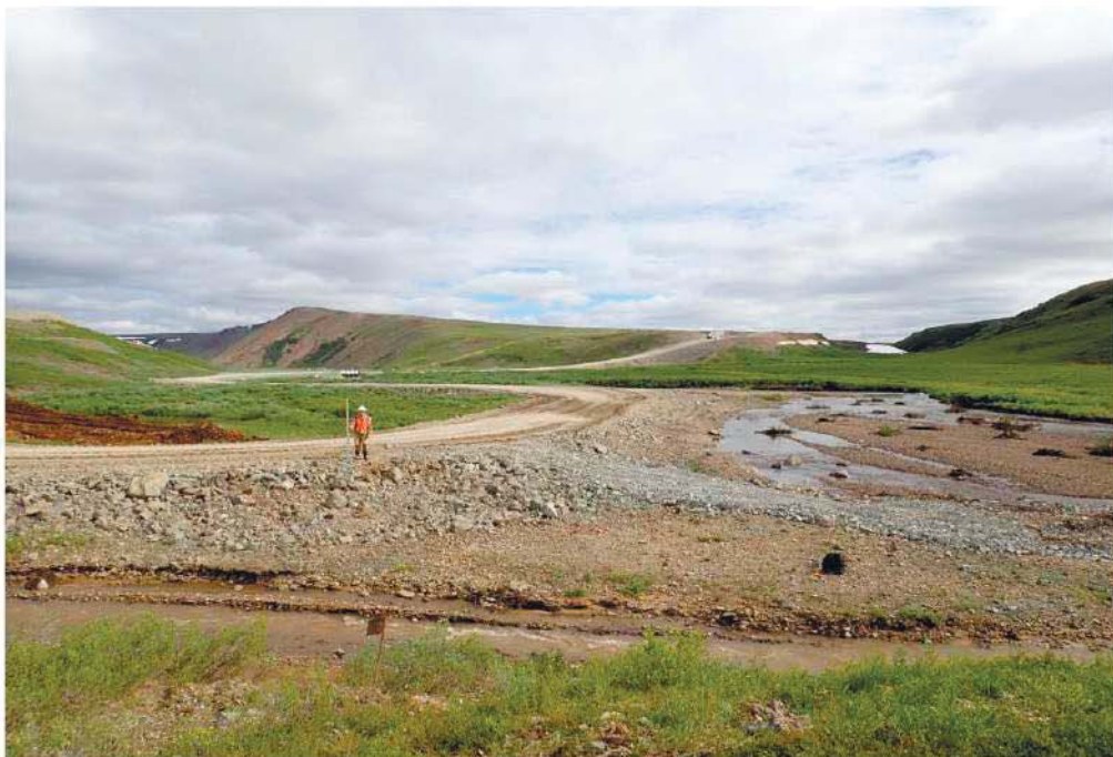
Рис. 11. Общий вид с юга на долину р. Средний Кайемравеем на начальном участке автодороги Купол-Морошка.
