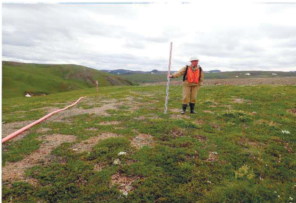
Рис. 103. Осмотр раздернованных участков в поисках подъемного материала. Центральная часть автодороги Купол-Морошка. Вид с запада.
