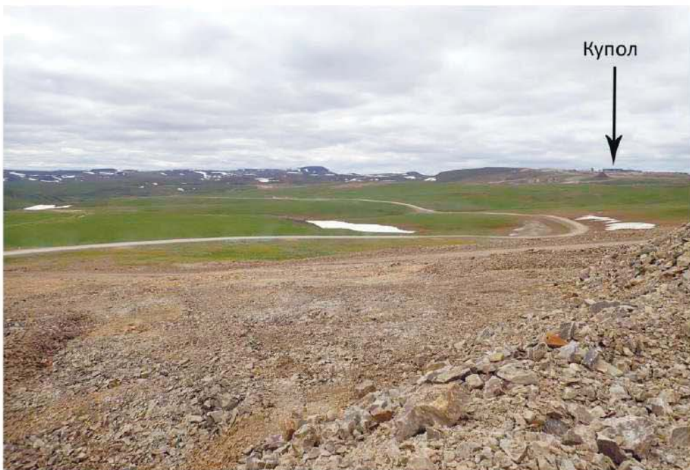
Рис. 74. Карьер №2. Общий вид с востока на площадку карьера и автодорогу Купол-Морошка, участок Купол (на заднем плане справа).
