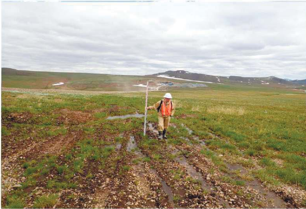
Рис. 89. Технологический проезд, осмотр раздернованных участков. Восточный участок автодороги Купол-Морошка. Вид с запада.
