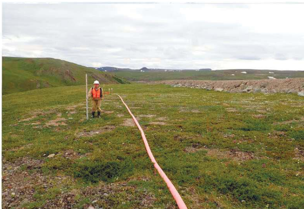
Рис. 123. Осмотр раздернованных участков в поисках подъемного материала. Западная часть автодороги Купол-Морошка. Вид с востока.
