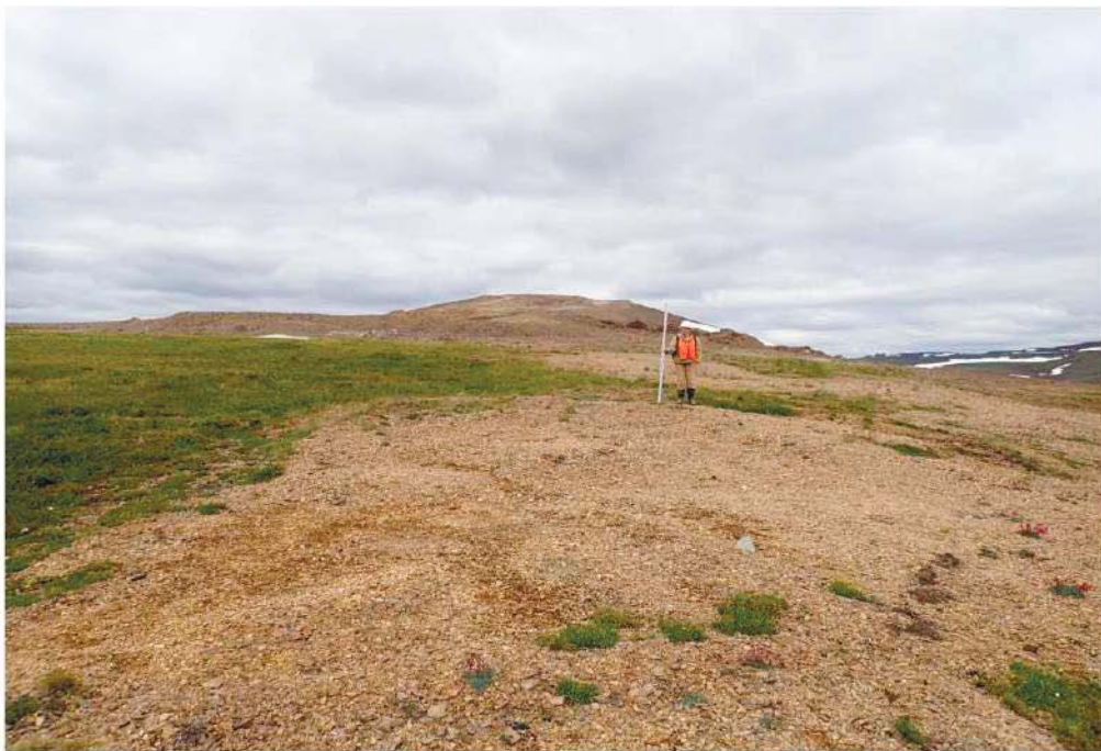
Рис. 90. Осмотр техногенно раздернованных участков, на заднем плане - Карьер №2. Восточный участок автодороги Купол-Морошка. Вид с юга.
