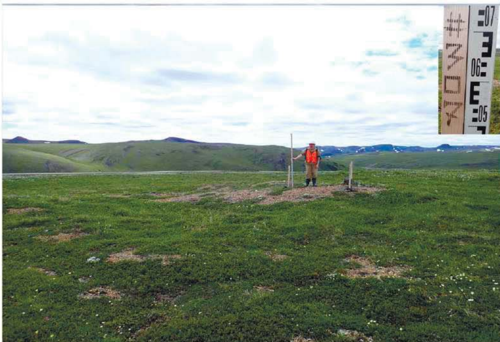
Рис. 40. Репер 307. Осмотренные раздернованные участки поверхности. Западный участок автодороги Купол-Морошка. Вид с востока.
