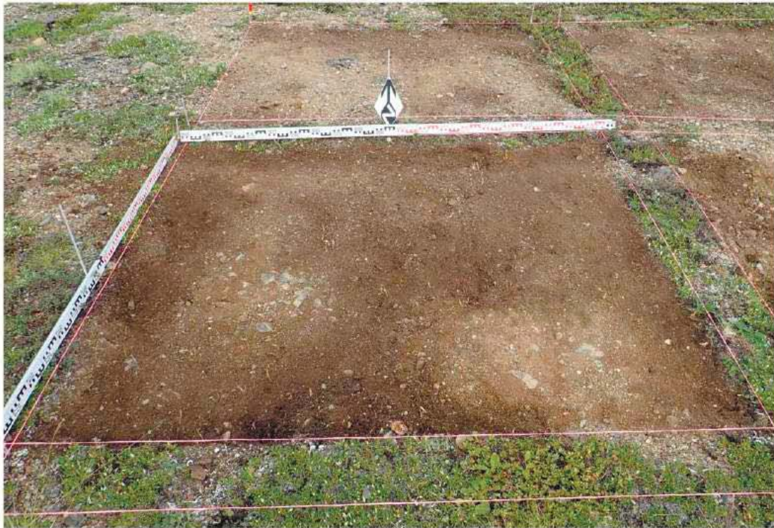
Рис. 32. Квадрат 402/501 после зачистки дерново-растительного слоя.
