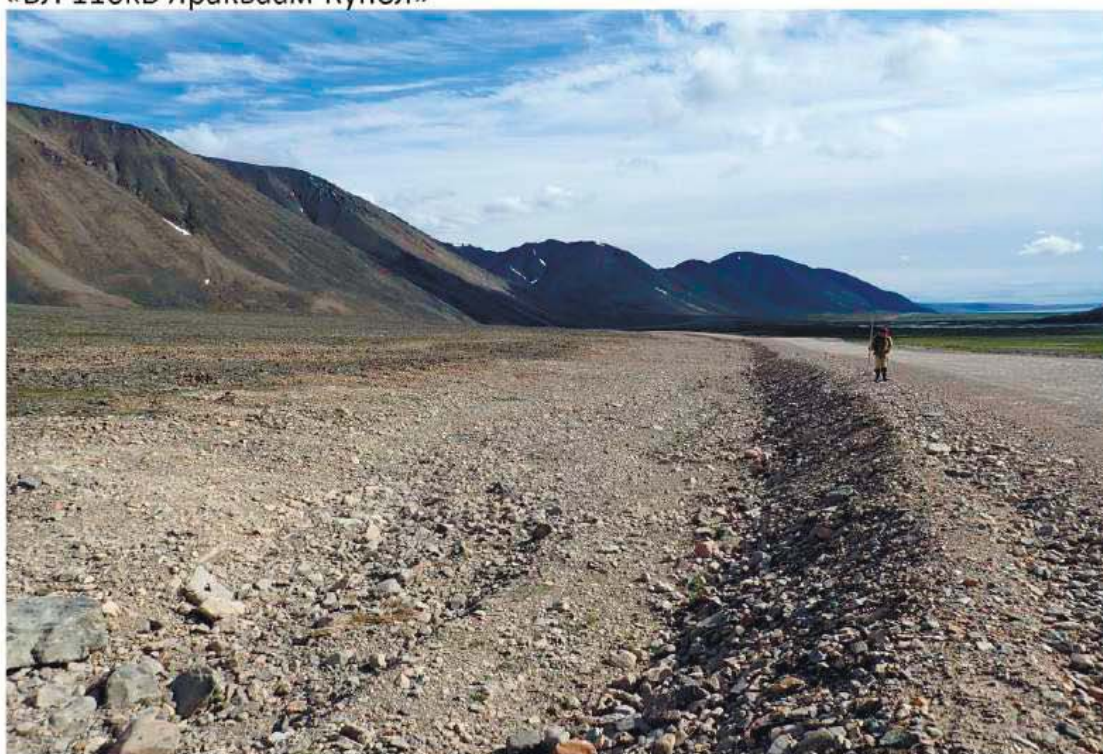
Рис. 200. Переход трассы объекта «ВЛ 110кВ Яракваам-Купол» на левый борт долины р. Тытлютин в верхнем течении. Лишенные растительности курумниковые осыпи у подножия горных склонов. Характер местности центральной части Участка 4 трассы обследованного объекта «ВЛ 110кВ Яракваам-Купол». Вид с севера.
