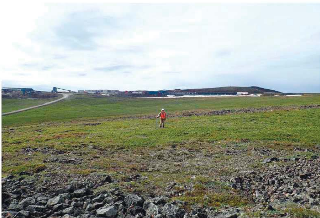
Рис. 481. Склон правого борта долины р. Средний Кайемравеем в верховьях. Ландшафт южной части Участка 7 трассы обследованного объекта «ВЛ 110кВ Яракваам-Купол». Вид с севера. На заднем плане - рудник Купол.
