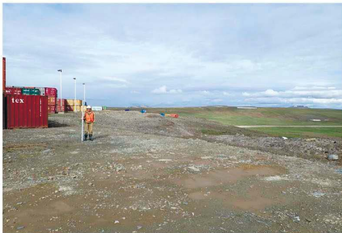
Рис. 485. Проектируемая площадка подстанции - конечная точка трассы обследованного объекта «ВЛ 110кВ Яракваам-Купол». Вид с востока.
