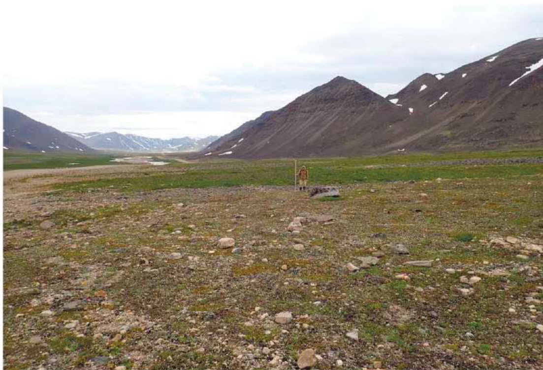
Рис. 128. Осмотренные участки с разреженным растительным покровом по левому борту долины р. Прав. Яракваам. Северная часть Участка 3 трассы обследованного объекта «ВЛ 110кВ Яракваам-Купол». Вид с севера.
