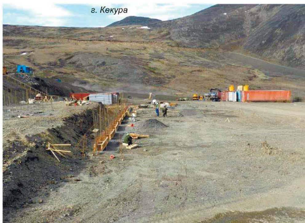
Рис. 19 . Промплощадка месторождения "Кекура". Вид с юго-востока.
