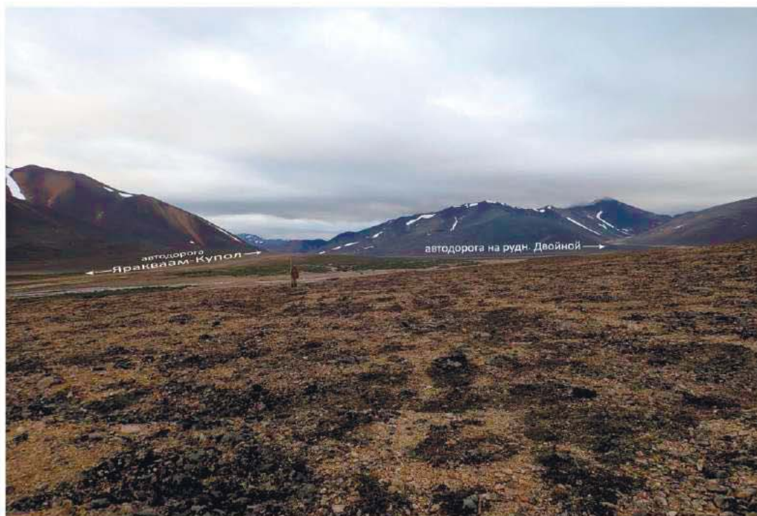
Рис. 174. Общий вид с севера на водораздел рек Прав. Яракваам и Тытлютин и участок перехода трассы обследованного объекта «ВЛ 110кВ Яракваам-Купол» через р. Прав. Яракваам (на среднем плане) в верховьях. На переднем плане - обследованный террасовидный уступ. Южная часть Участка 3 . Вид с севера.
