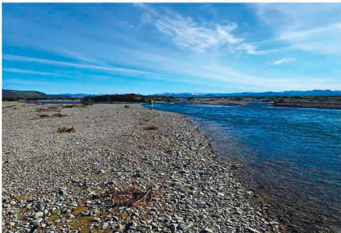
Рис. 51. Протоки р. Лелювеем в месте перехода трассы объекта «ВЛ 110кВ Яракваам-Купол». Вид с юга.
