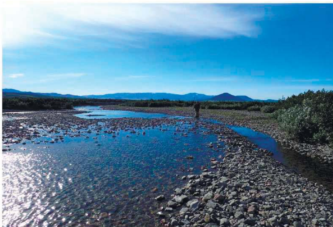
Рис. 49. Правый берег р. Лелювеем в месте перехода трассы объекта «ВЛ 110кВ Яракваам-Купол». Вид с юга.
