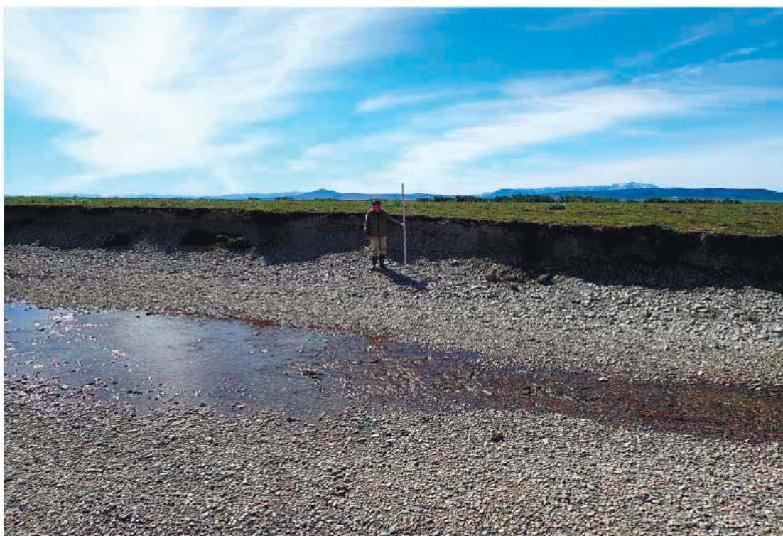
Рис. 32. Река Лелювеем на Участке 1 обследованного объекта «ВЛ 110кВ Яракваам-Купол». Осмотренные естественные обнажения берега. Вид с востока.
