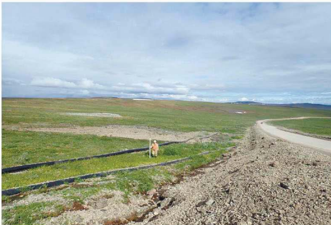
Рис. 482. Склон правого борта долины р. Средний Кайемравеем в верховьях. Ландшафт южной части Участка 7 трассы обследованного объекта «ВЛ 110кВ Яракваам-Купол». Вид с севера.
