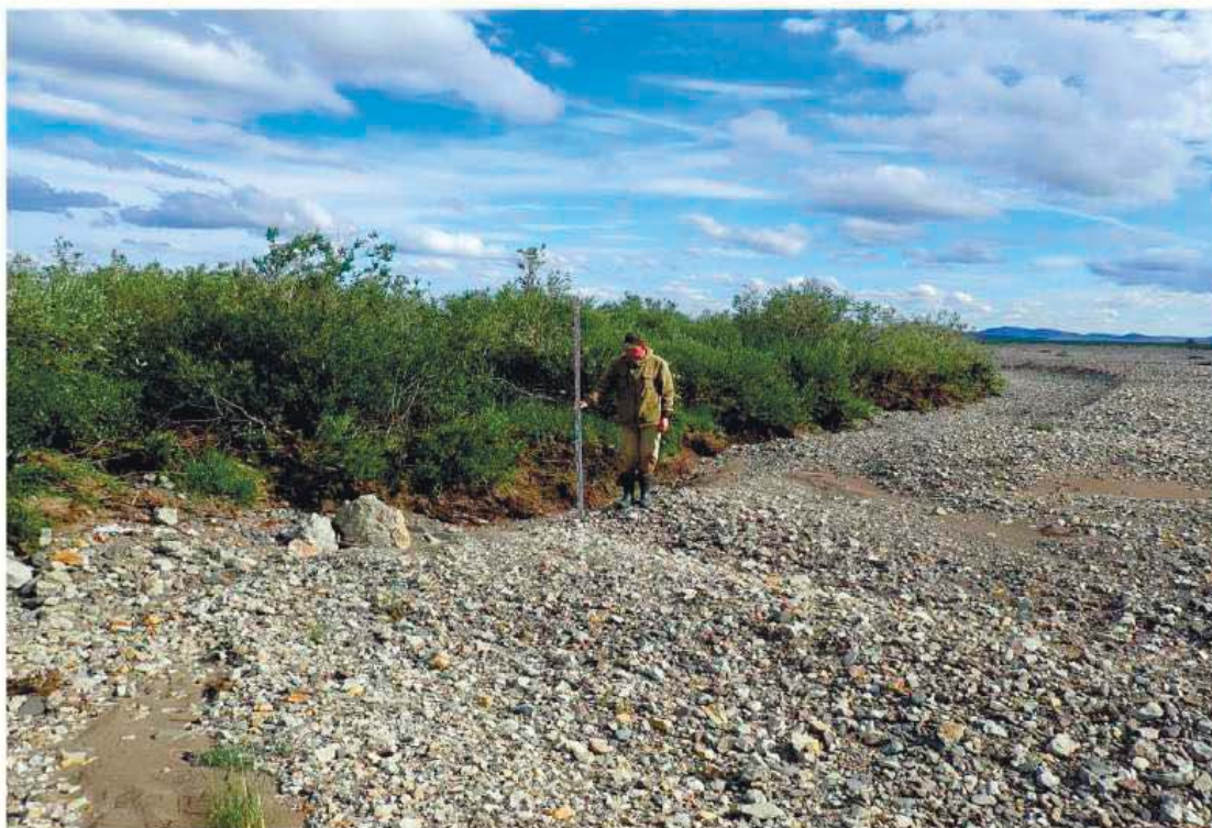
Рис. 435. Правый берег р. Мал. Анюй в месте перехода трассы обследованного объекта «ВЛ 110кВ Яракваам-Купол». Вид с запада.
