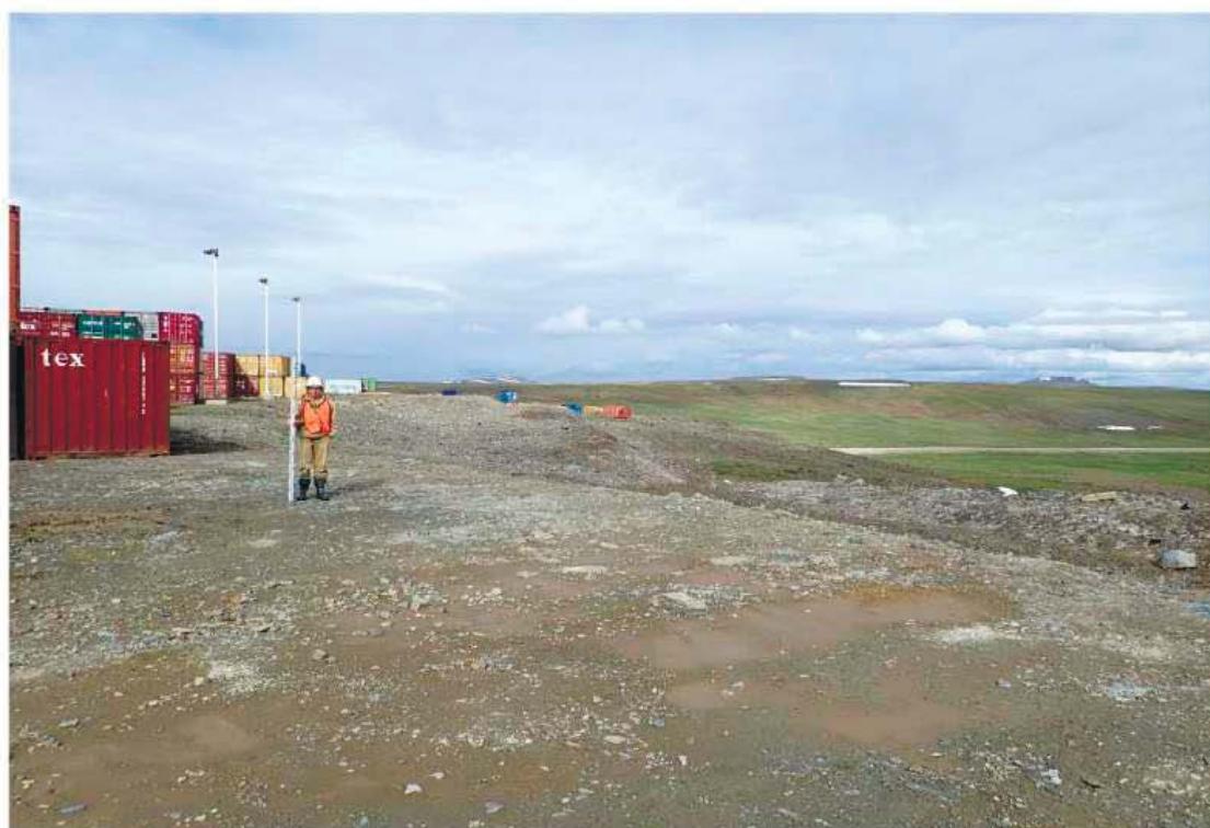
Рис. 485. Проектируемая площадка подстанции - конечная точка трассы обследованного объекта «ВЛ 110кВ Яракваам-Купол». Вид с востока.
