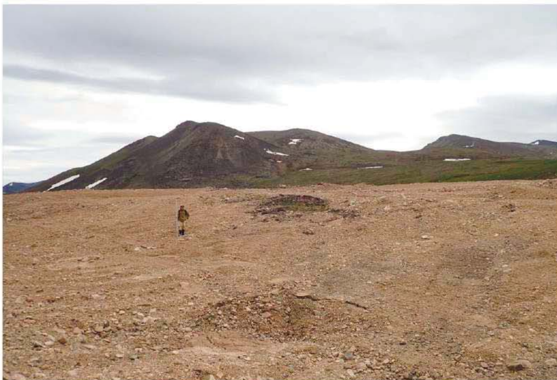
Рис. 154. Осмотренные участки с техногенно нарушенной естественной поверхностью по левому борту долины р. Прав. Яракваам. Южная часть Участка 3 трассы обследованного объекта «ВЛ 110кВ Яракваам-Купол». Вид с севера.
