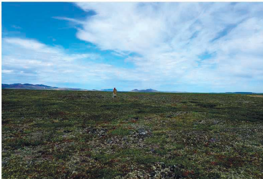
Рис. 103. Осмотренные участки с разреженным растительным покровом. Южная часть Участка 2 трассы обследованного объекта «ВЛ 110кВ Яракваам-Купол». Вид с юга.
