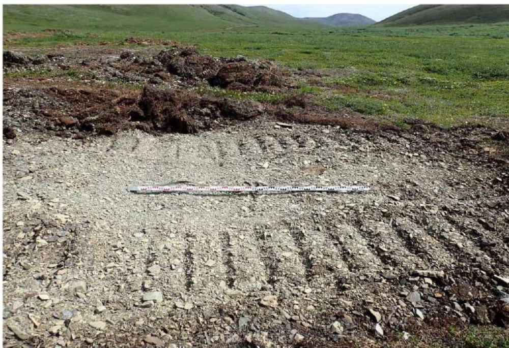
Рис. 190. Участок 5, северная площадь. Обследованная площадка террасы по правому борту р. Хребтовой в верхнем течении. Осмотренные участки с техногено раздернованной поверхностью. Вид с севера.
