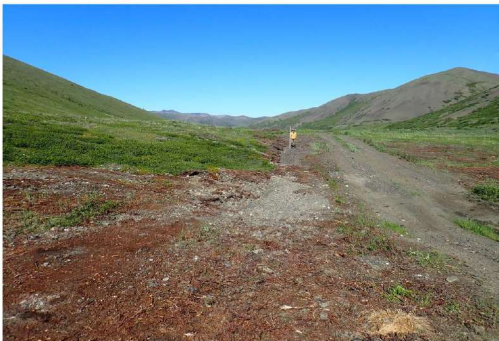
Рис. 119. Участок 5, северная площадь. Обследованная терраса по левому борту р. Хребтовая в среднем течении, осмотренные участки площадки террасы со снятым землеройной техникой дерново-почвенным слоем. Вид с юга.
