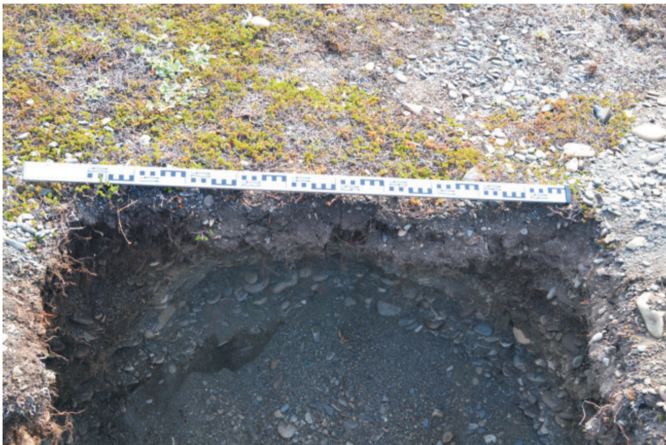
Рис. 56. Анадырский район, лагуна Орианда. Земельный участок №2. Шурф №5. Южный борт, вид с С. Стенка осыпается из-за скоплений крупнозернистого непереувлажненного песка.
