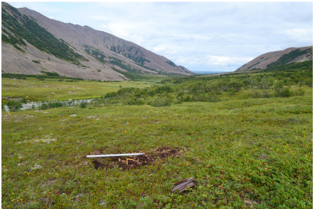
Рис. 38. Фото. Анадырский район ЧАО. Кэнкэрэнская перспективная площадь, участок «Сквозной». Западный сектор землеотвода. 1-я надпойменная правобережная терраса речки Нитеескыгинвеем. Рекультивация шурфа № 6. Вид с Ю.
