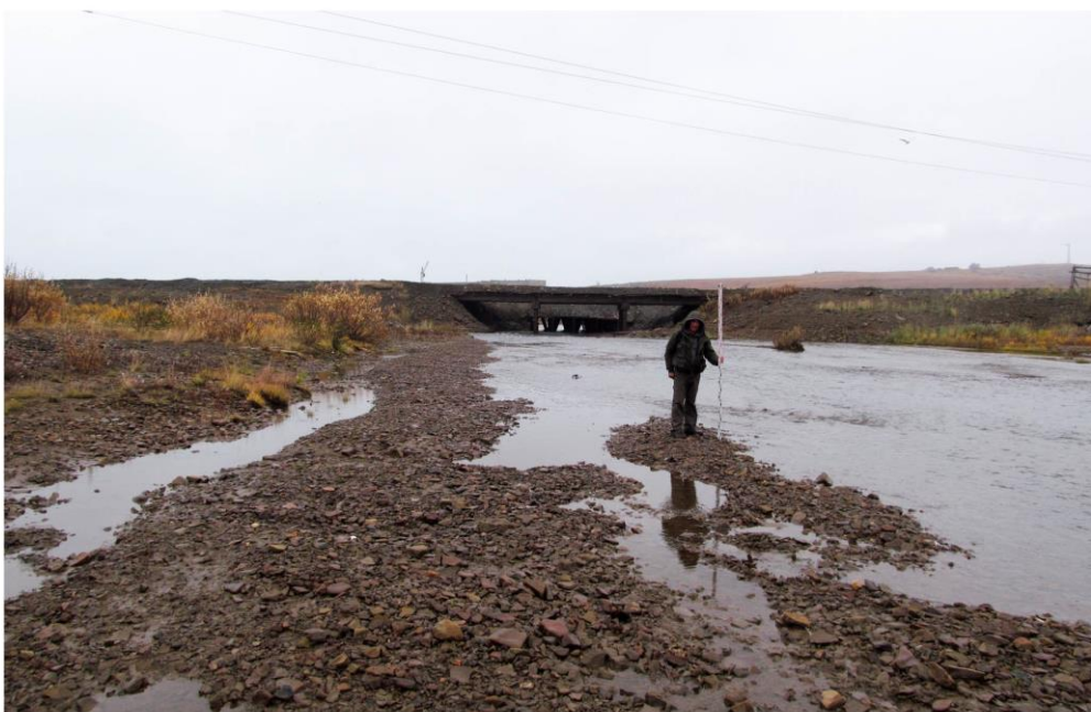
Рис. 16. Вид с юга на автодорожный мост через руч. Угольный.
