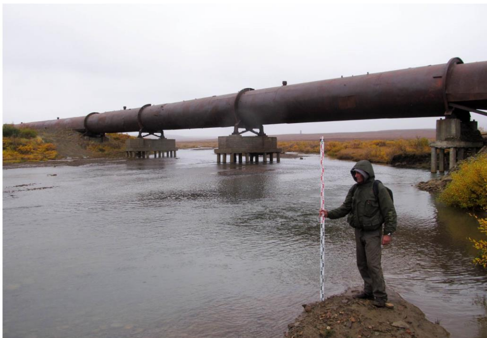
Рис. 17. Вид с юга на переход угольного транспортера через руч. Угольный.
