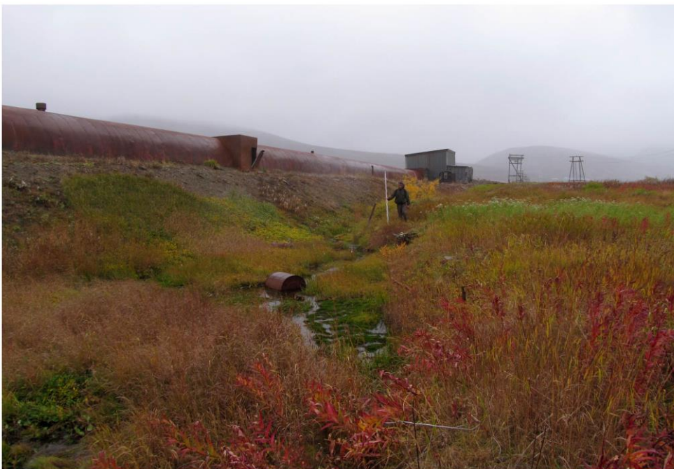
Рис. 20. Вид с юго-запада на ось угольного транспортера, отсыпку, водоотводную канаву и объекты очистки сточных вод.
