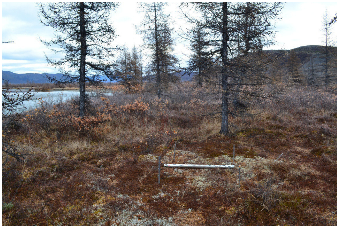
Рис. 76. Фото. Билибинский район ЧАО. Участок проектируемой трассы автодороги Колыма – Омсукчан - Омолон – Анадырь, км. 398+000 - км. 425+000. Правый берег р. Большой Анной. Закладка шурфа № 9. Вид с В.
