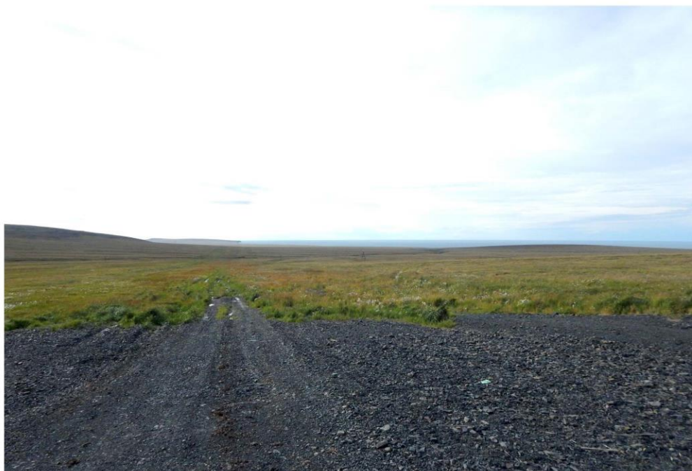
Рис. 61. Общий вид с севера на трассы автозимника и ВЛ 110 кВ к подстанции 110/10 кВ.
