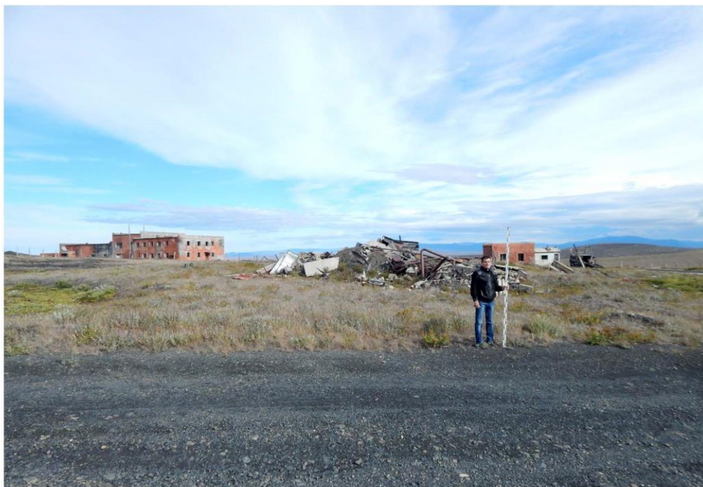
Рис. 13. Вид с востока на руинированные строения на территории проектируемого складского комплекса.
