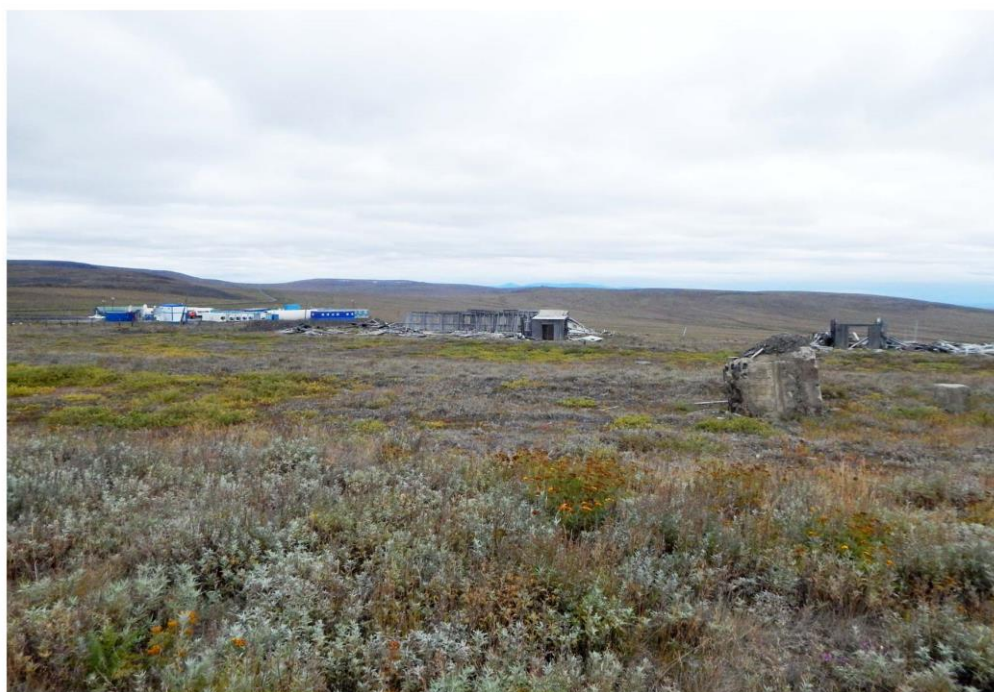
Рис. 107. Вид с запада, с территории складского комплекса на заключительный участок трассы ВЛ 110 кВ.
