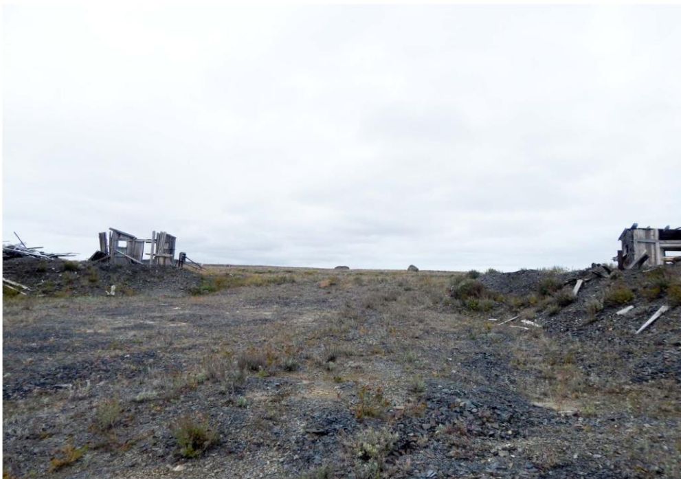
Рис. 134. Вид с юго-востока на ось трассы ВЛ 110 кВ на финишном участке по территории складского комплекса.
