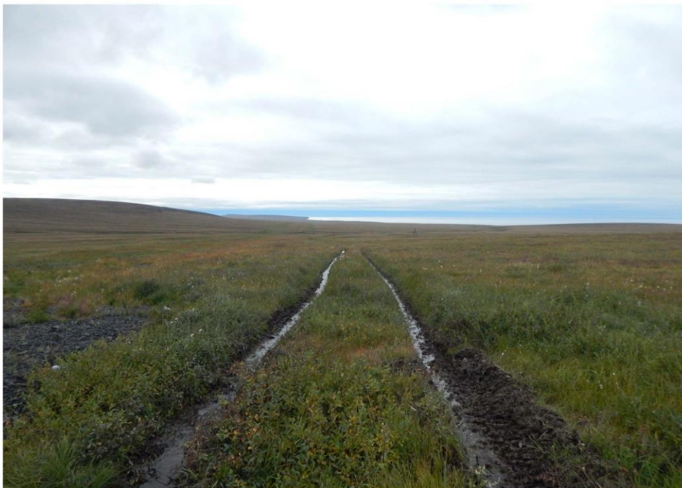
Рис. 56. Вид с севера на ось проектируемой трассы ВЛ 110 кВ к площадке подстанции 110/10 кВ и автозимник на Билибино и Купол.
