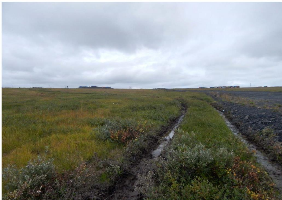
Рис. 57. Вид с юга на створ трассы ВЛ 110 кВ и отсыпку стартового участка зимника на Билибино и Купол.
