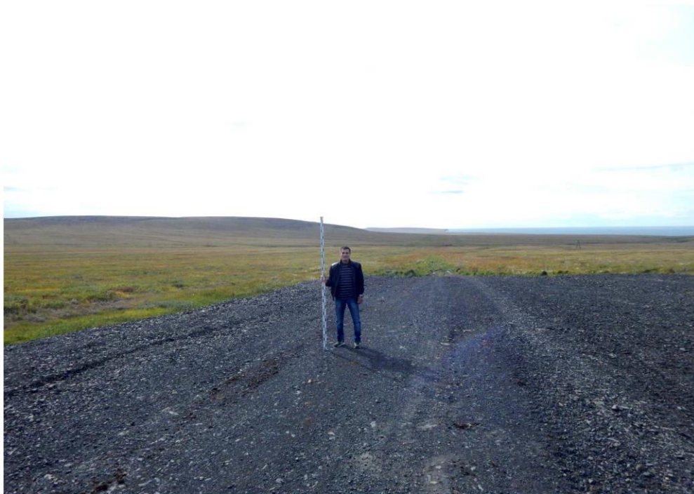
Рис. 60. Вид с севера на край грунтовой отсыпки автозимника и участок проектируемого строительства ВЛ 110 кВ.
