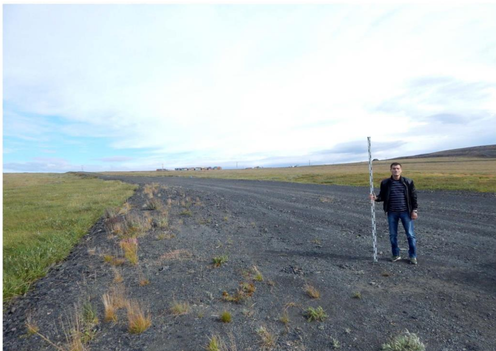
Рис. 64. Отсыпная грунтовая дорога автозимника на Билибино и Купол, на участке строительства ВЛ 110 кВ. Вид с юга.
