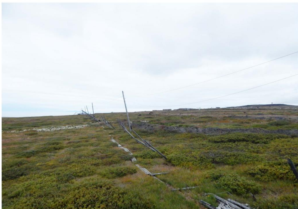
Рис. 115. Вид на техногенно террасированную площадку склада, на территории базы материального обеспечения и участок трассы ВЛ 110 кВ.
