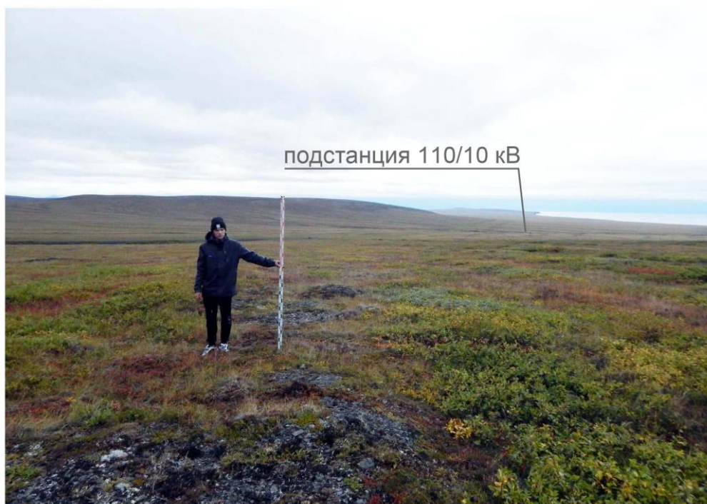
Рис. 35. Общий вид с севера на трассу проектируемой ВЛ 110 кВ.
