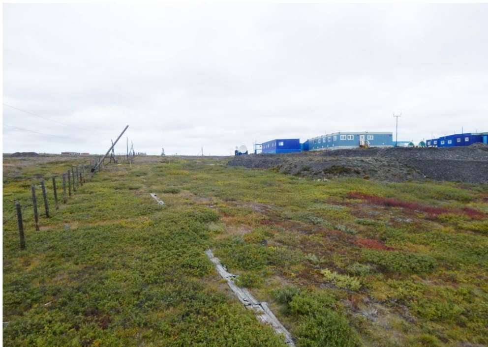
Рис. 108. Вид с юго-востока на створ трассы ВЛ 110 кВ на участке строительства складского комплекса.
