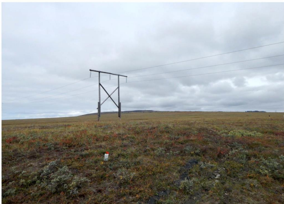
Рис. 18. Площадка проектируемой подстанции 110/10 кВ. Вид с севера.
