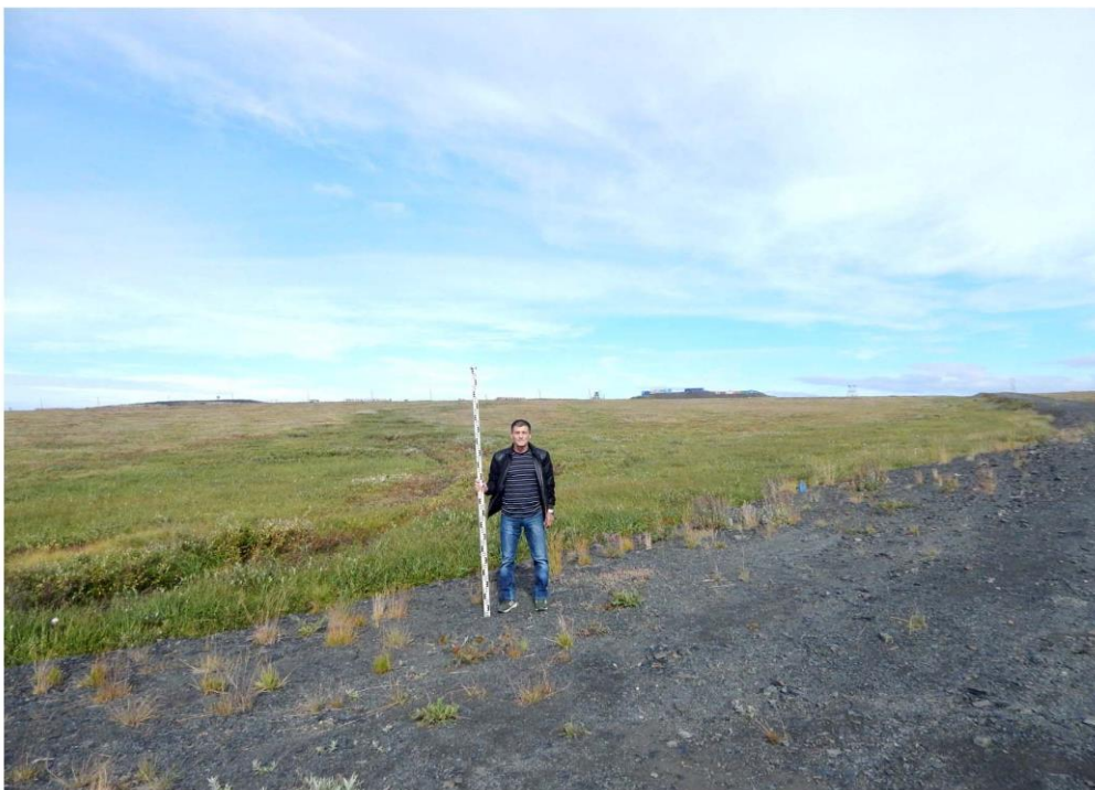
Рис. 62. Вид с юго-востока на коридор проектируемой трассы ВЛ 110 кВ на участке от автозимника до складского комплекса.
