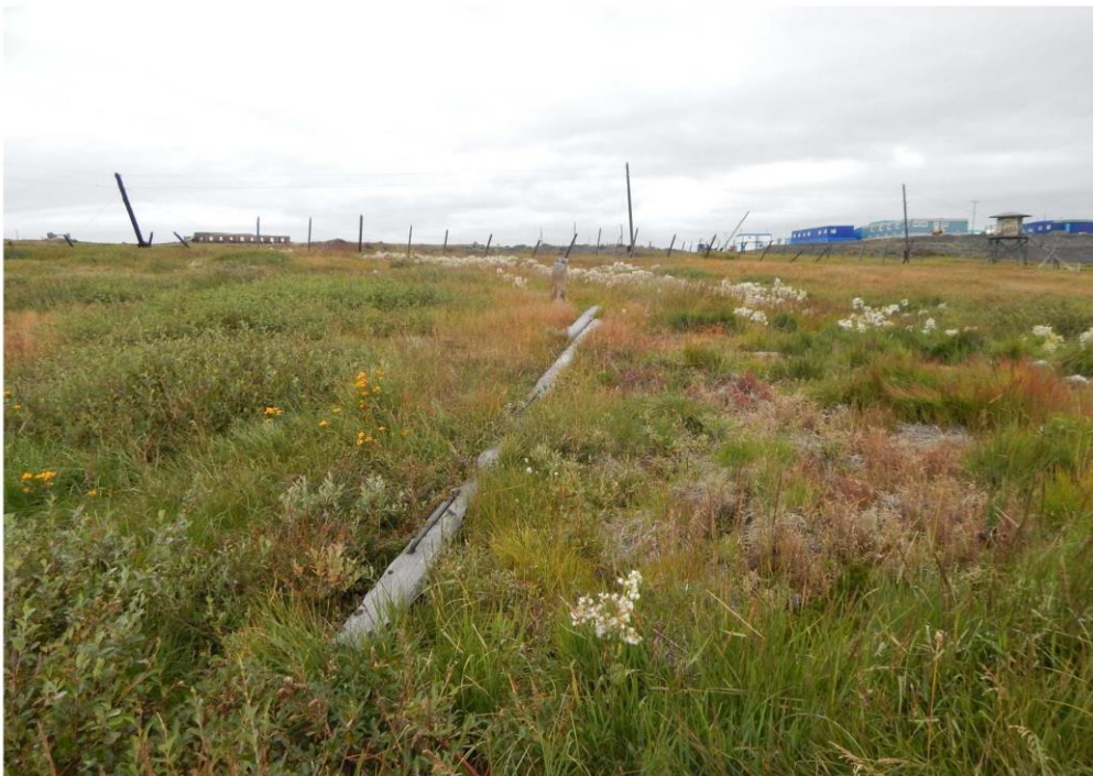
Рис. 104. Сырая кочковатая тундра на участке захода трассы ВЛ 110 кВ на территорию базы материального обеспечения и складского комплекса.
