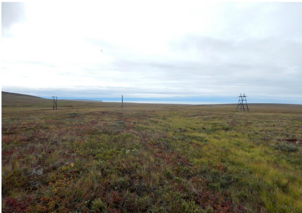
Рис. 30. Вид с севера на участок подключения подстанции 110/10 кВ к действующей линии электропередач.
