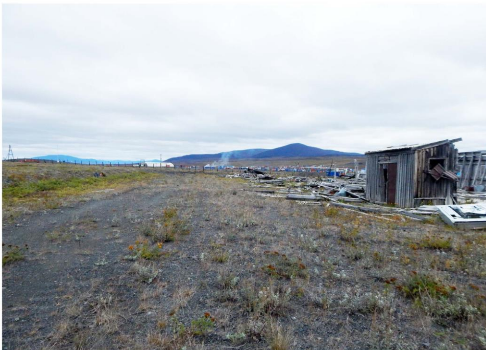
Рис. 136. Старое полотно внутрискладского проезда на участке трассы ВЛ 110 кВ. Вид с юго-запада.
