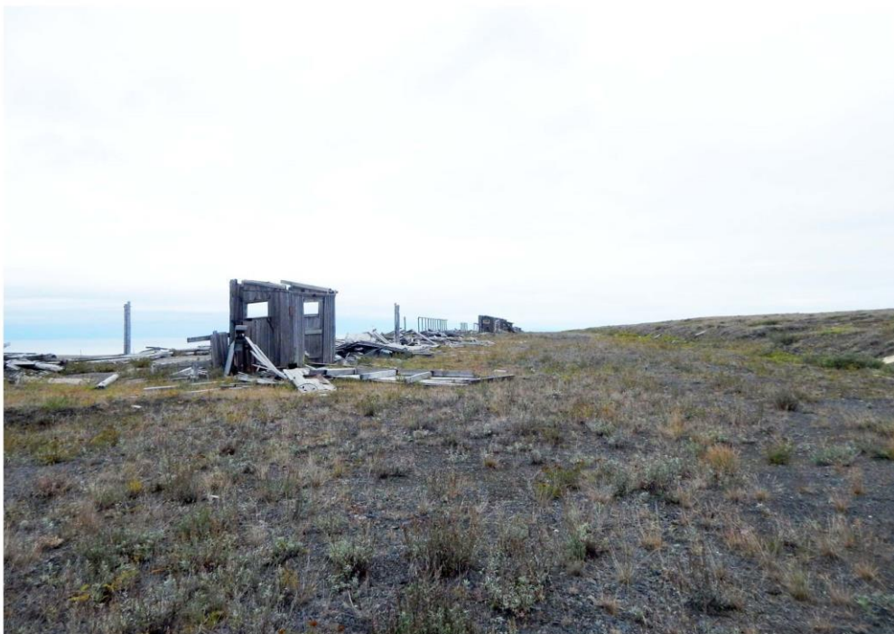
Рис. 135. Зарастающая сланцевая поверхность отсыпки на территории базы материального обеспечения и ВЛ 110 кВ.
