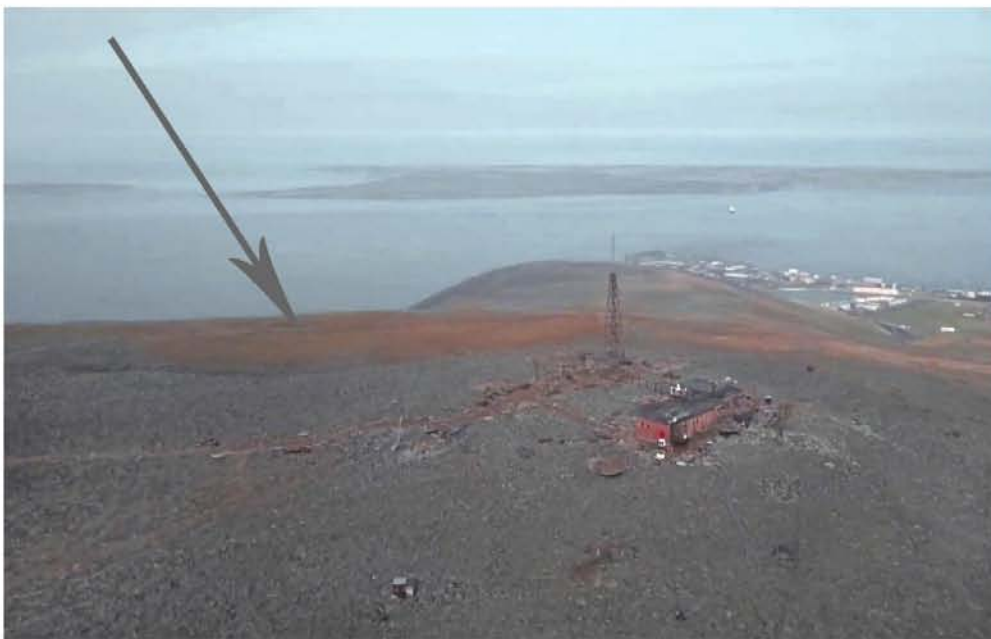
Рис. 50. Вид с высоты, с юга на вершину г. Пээкиней и участок «Строительства объектов Глобальной морской системы связи при бедствии на трассах Северного морского пути».
