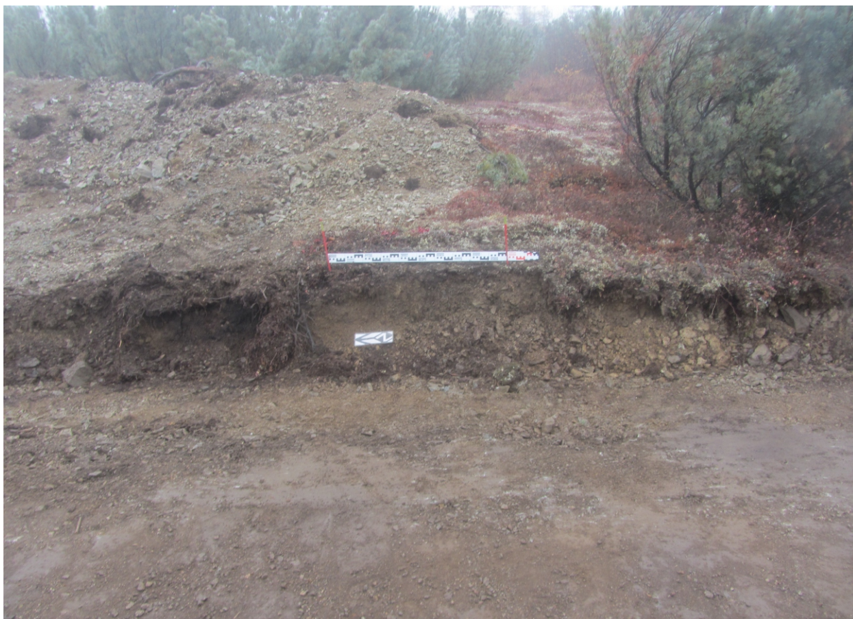
Рис. 73. Баймский ГОК. Проект медного месторождения «Песчанка». Подъездная дорога к посадочной площадке «Баймская». Общий вид с запада на место закладки зачистки № 15.
