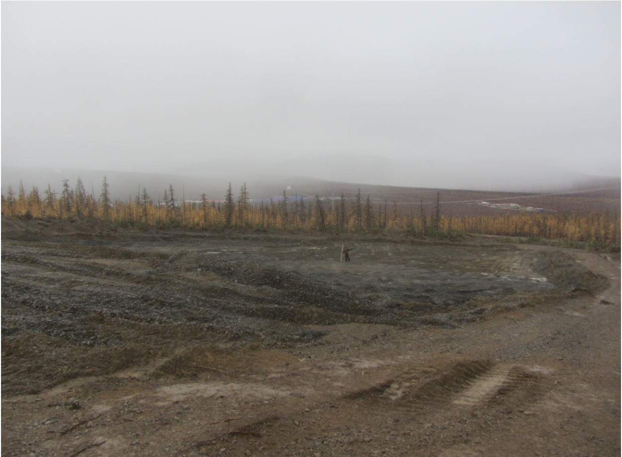
Рис. 19. Баймский ГОК. Проект медного месторождения «Песчанка». Подъездная дорога к посадочной площадке «Баимская». Точка фотофиксации 11. Вид с северо-востока.
