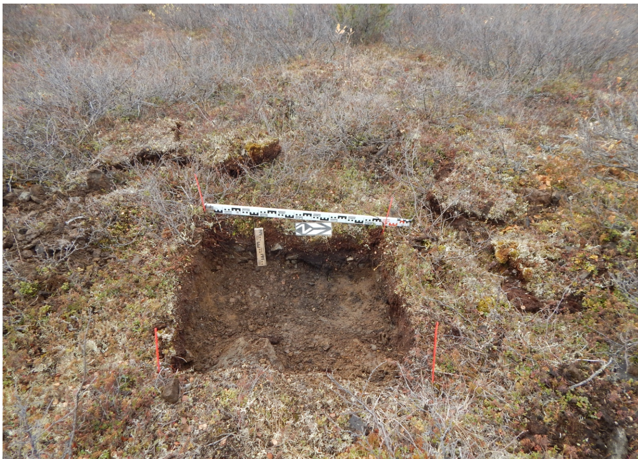
Рис. 51. Баимский ГОК. Проект медного месторождения «Песчанка». Подъездная дорога к посадочной площадке «Баимская». Шурф № 8 после вскрытия. Вид с востока.
