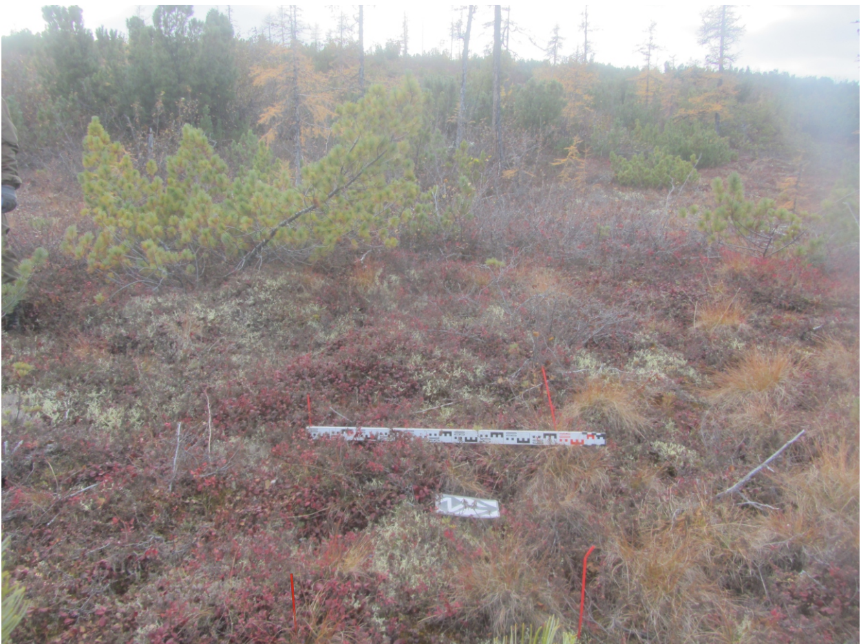
Рис. 28. Баимский ГОК. Проект медного месторождения «Песчанка». Подъездная дорога к посадочной площадке «Баимская». Шурф № 2 перед началом работ. Вид с востока.
