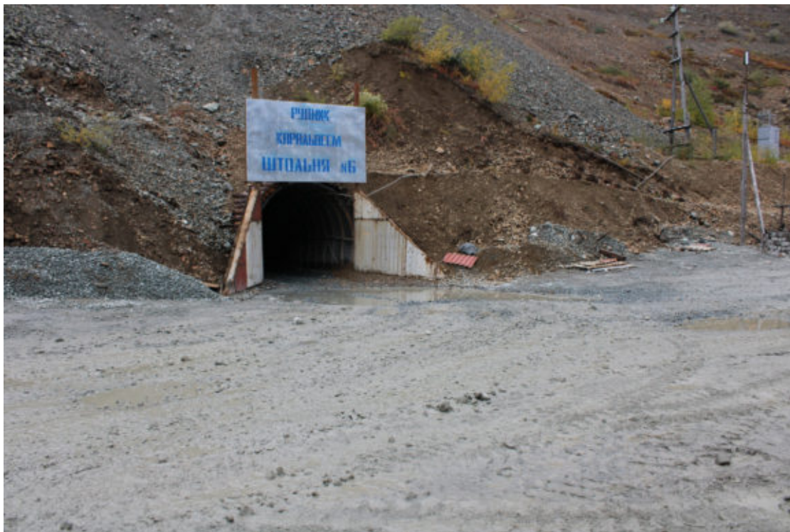
Рис. 44. Фото. ЧАО. Билибинский район. Золоторудное месторождение Каральвеем. Южный сектор земельного участка. Вход в штольню №6. Вид с ЮВ.
