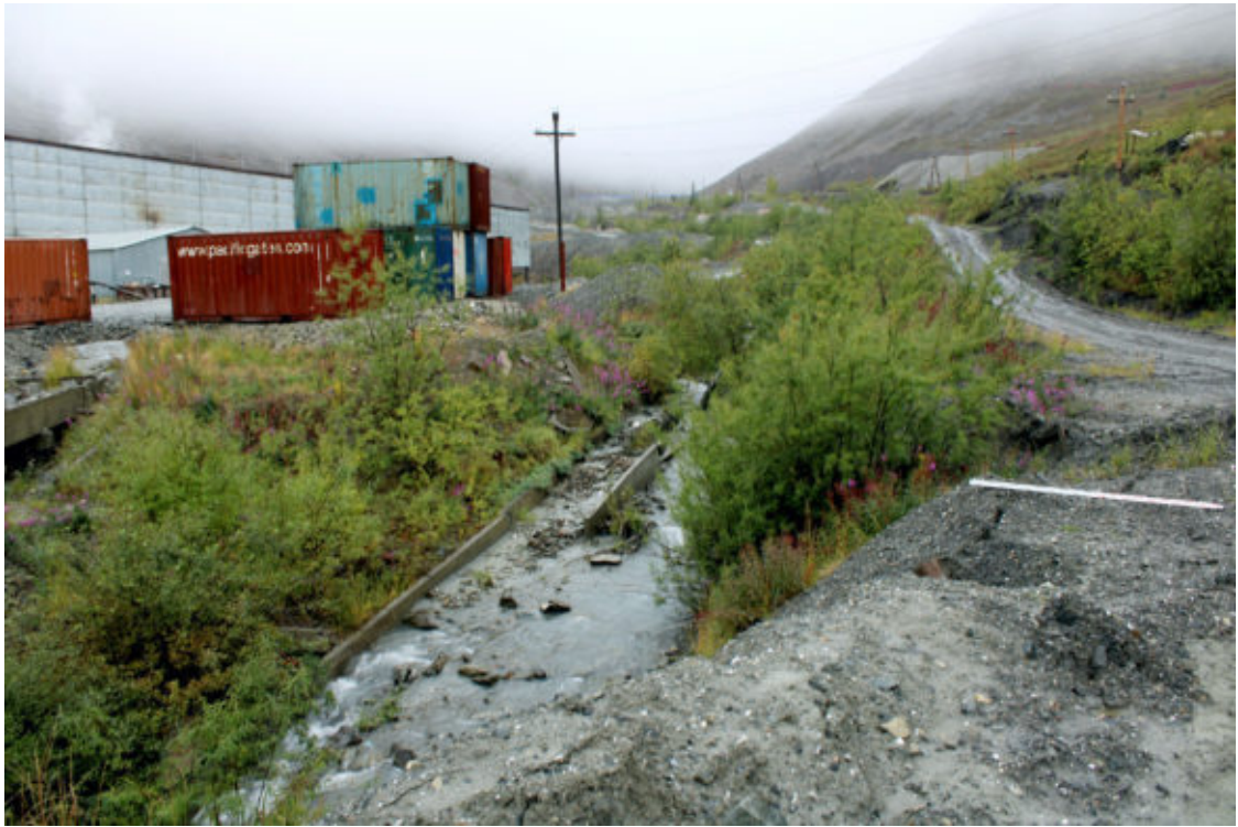
Рис. 27. Фото. ЧАО. Билибинский район. Золоторудное месторождение Каральвеем. Северный сектор земельного участка. Долина ручья Кривой. Водоток протекает по бетонному желобу. Вид с В.
