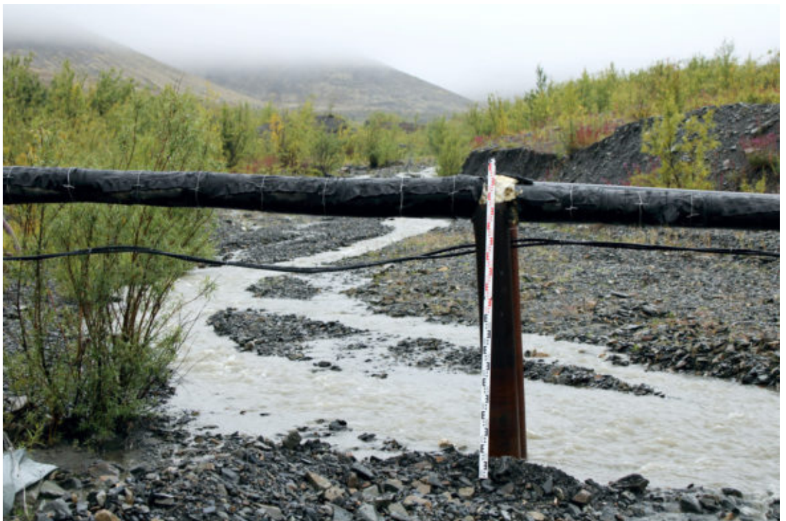
Рис. 24. Фото. ЧАО. Билибинский район. Золоторудное месторождение Каральвеем. Северный сектор земельного участка. Приустьевая часть ручья Безымянный. Вид с З.
