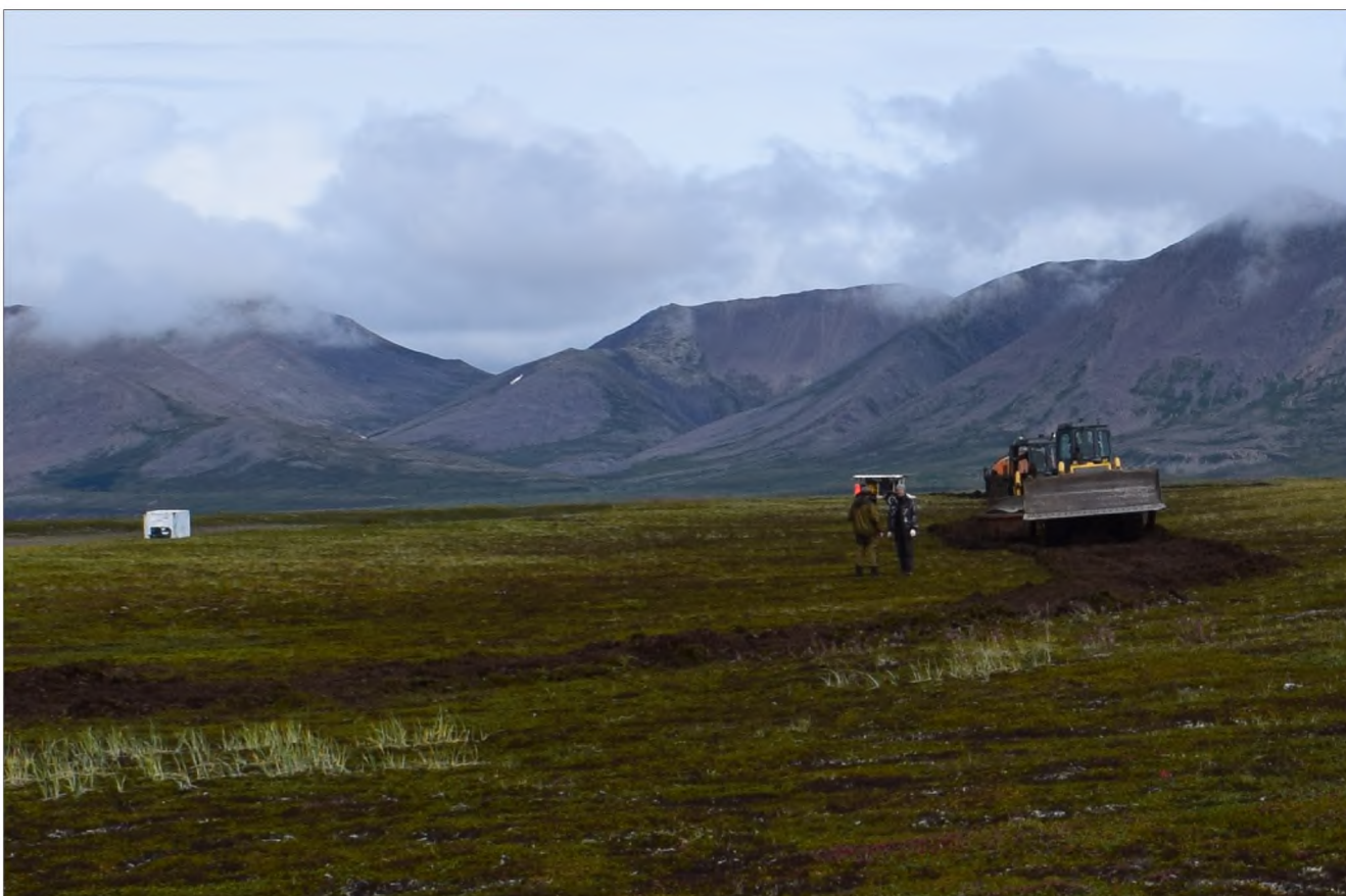
2018 год. Бухта Гавриила. Грунтовая дорога ООО “ЧТК”. Работа бульдозеров.
