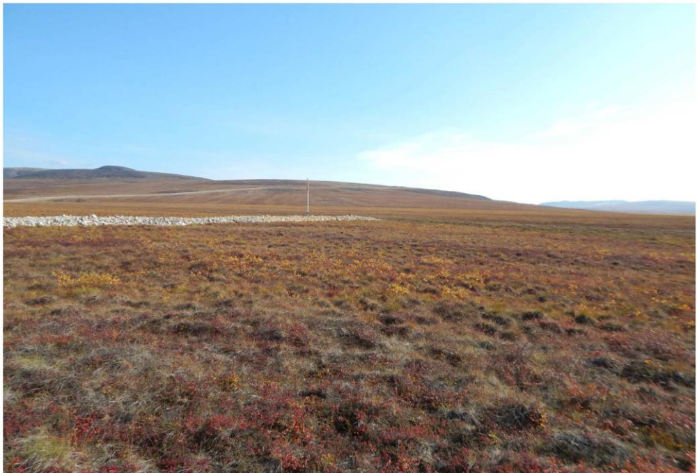
Рис. 87. Завершающий отрезок отсыпки проезда к мачтам освещения ВПП «Купол» в пойме р. Ыттыльывеем. Вид с северо-запада.
