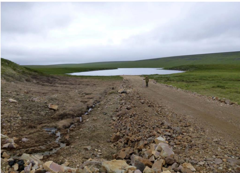
Рис. 29. Вид с северо-востока на подъездную технологическую дорогу к озеру на участке продления ВПП «Купол».
