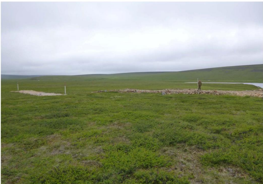
Рис. 85. Вид с северо-востока на отсыпку технологического проезда к мачтам освещения ВПП «Купол» в районе фиксации координат местонахождения Ыттыльывеем III.
