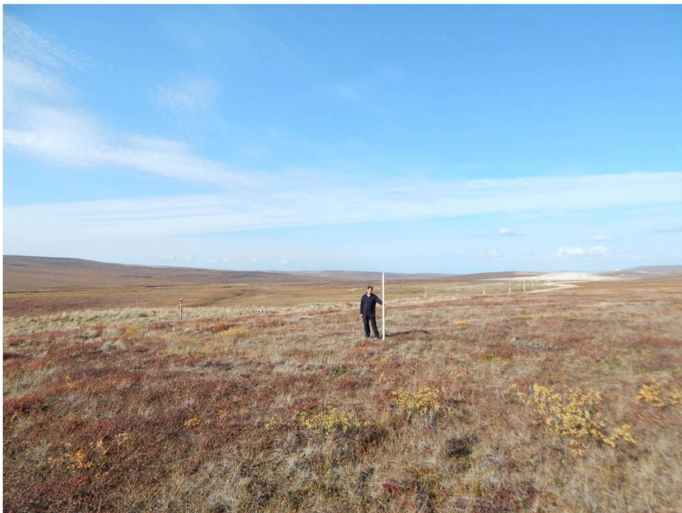
Рис. 49. Вид с юго-востока на ВПП и подъездную автодорогу к мачтам подсветки в районе зачистки № 1.
