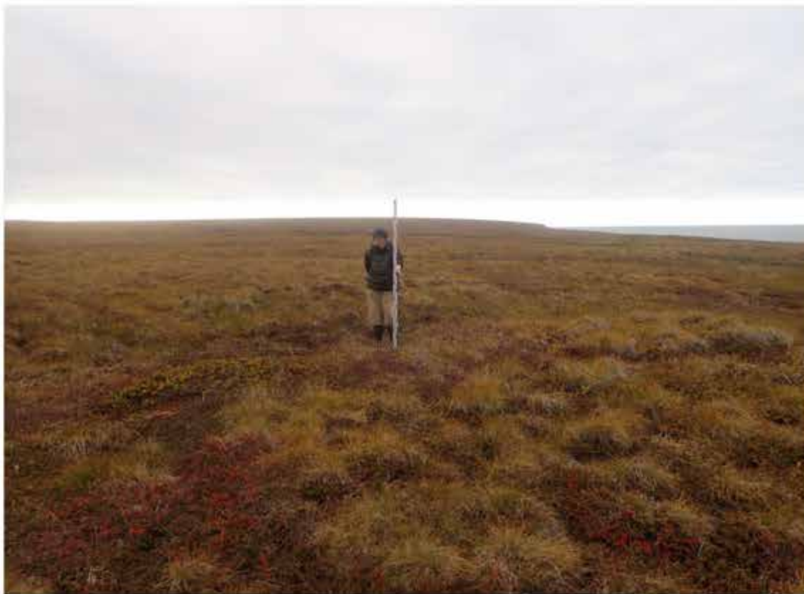
Рис. 20 .«Строительство универсального мор. терминала в р-не м. Наглёйнын». Общий вид с юга на место закладки шурфа № 1.
