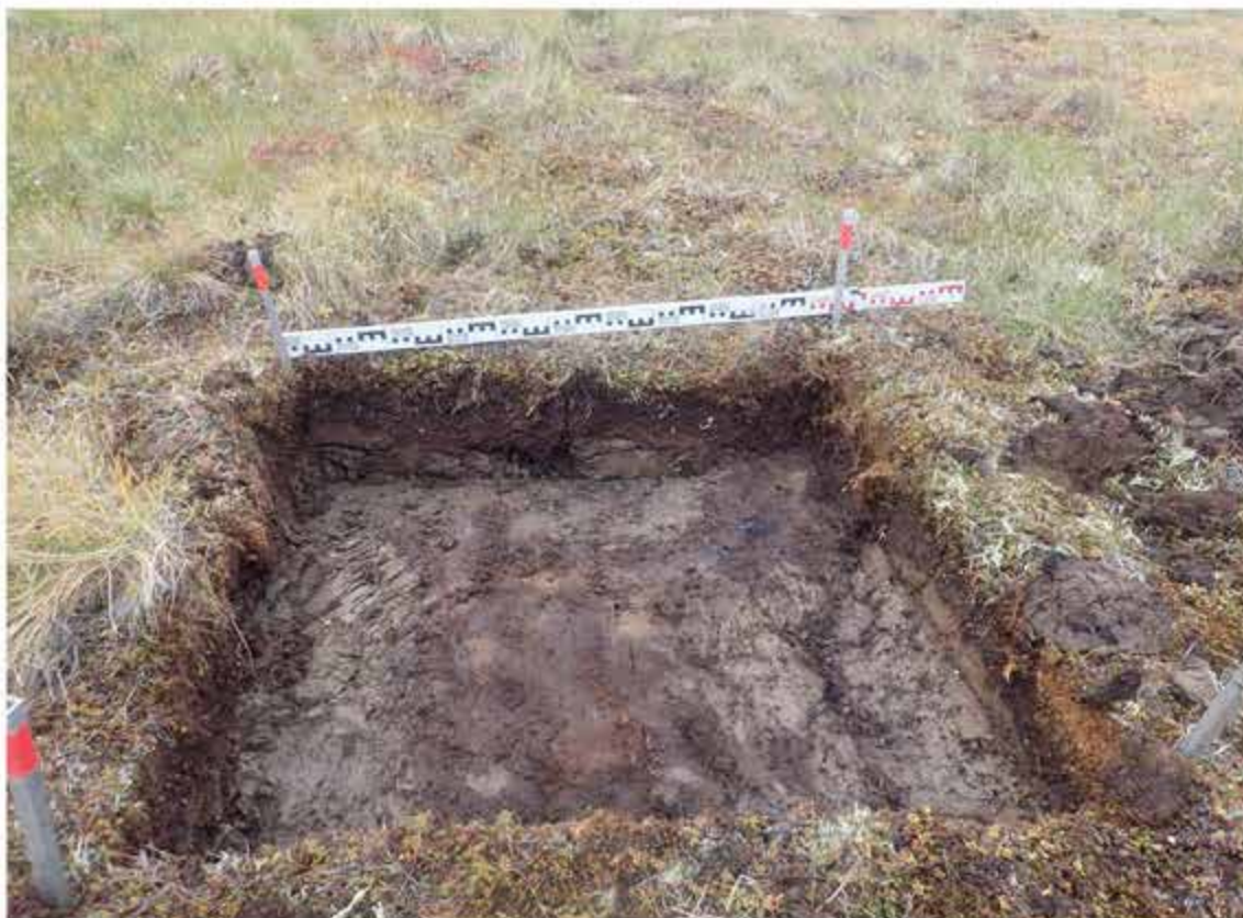
Рис. 78 . «Строительство универсального мор. терминала в р-не м. Наглёйнын». Характер рыхлых отложений шурфа № 6. Северная стенка.
