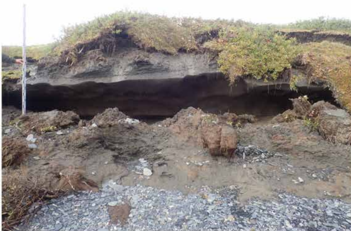
Рис. 47 . Объект «Строительство универсального морского терминала в районе мыса Наглёйнын».
