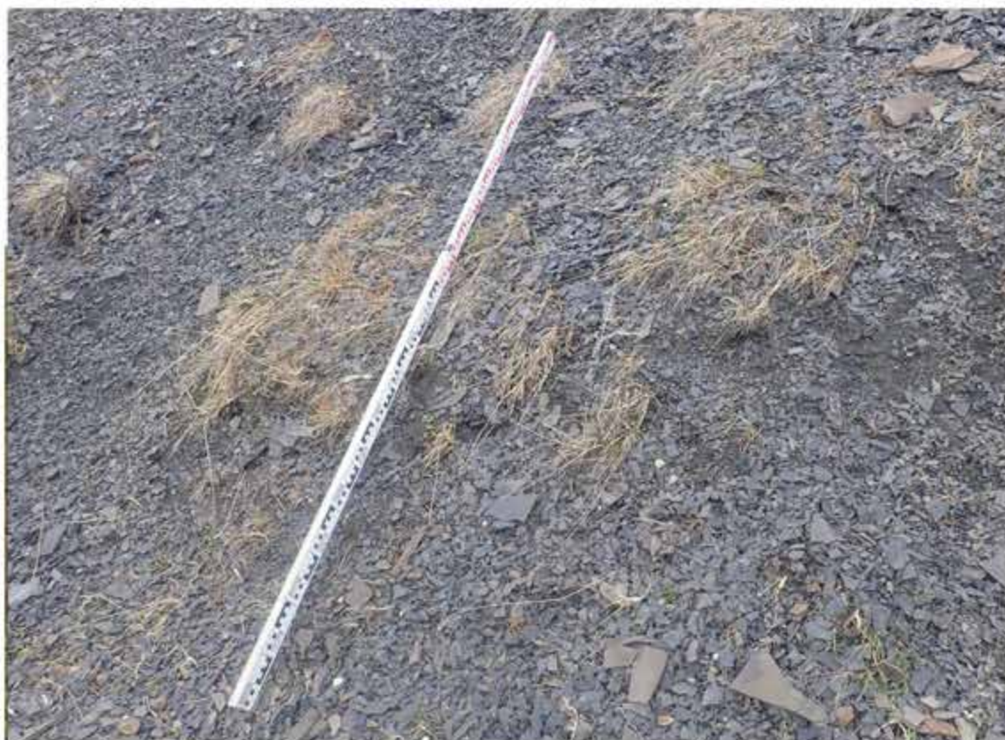
Рис. 53 . Объект «Строительство универсального морского терминала в районе мыса Наглёйнын». Прибрежный участок. Осмотренные береговые осыпи. Вид с востока.
