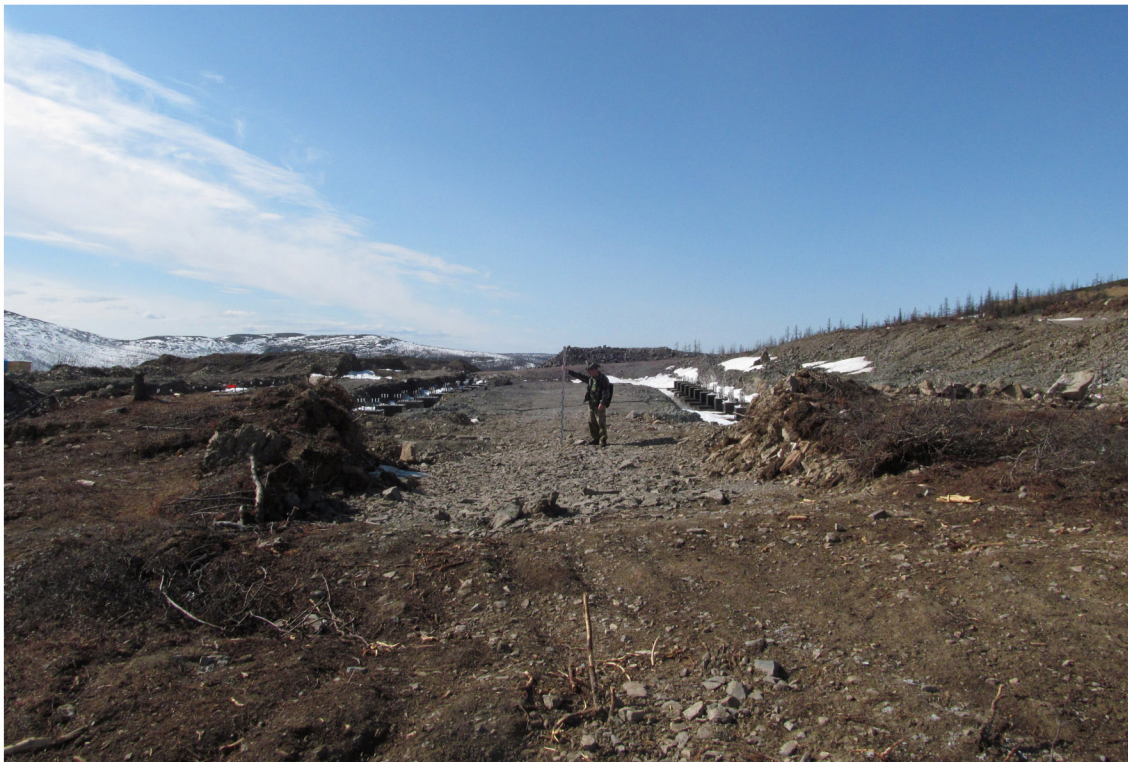
Рис. 23. Строительный объект на месторождении “Клен”. Вид с юго-востока.
