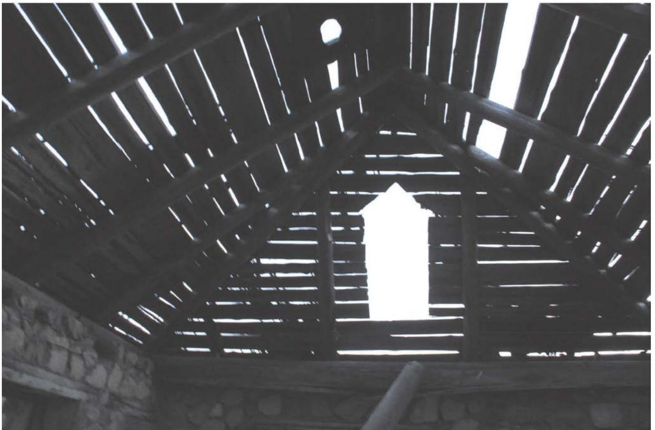
Стропильная система четырехскатной крыши.
