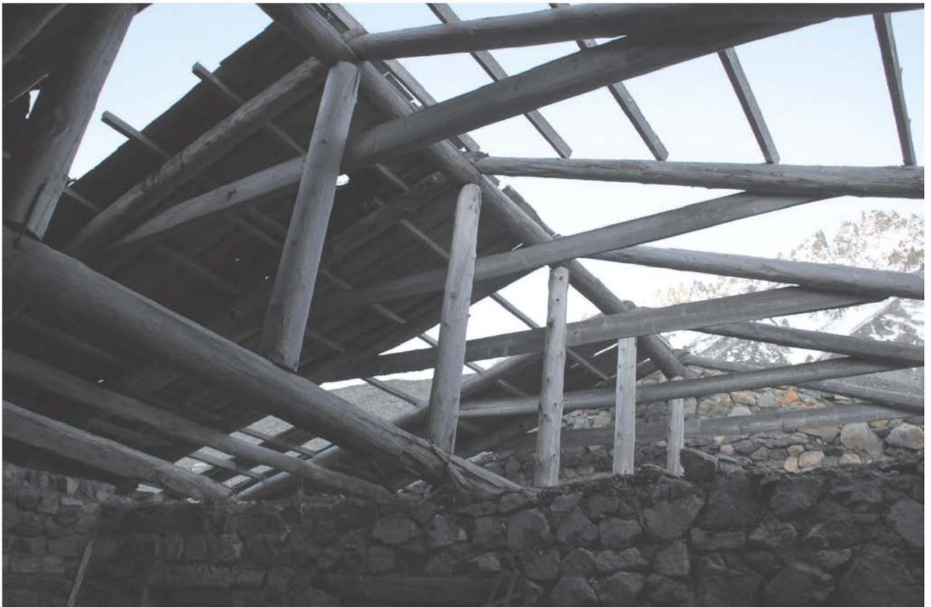
Стропильная система двускатной крыши.
