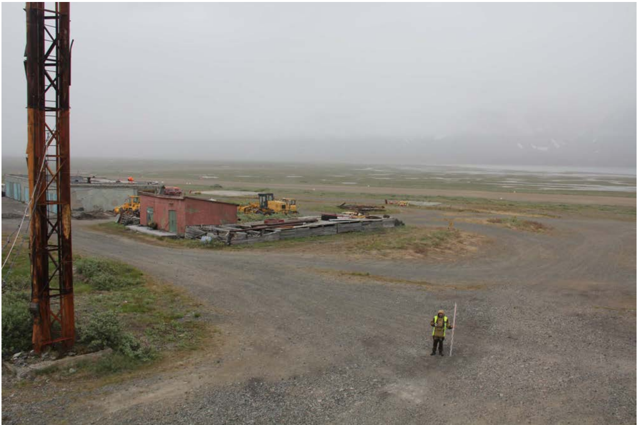
Рис.33. Чукотский АО, городской округ Эгвекинот, 2022 год. Проект реконструкции аэропорта "Залив Креста". Направление фотосъемки на В. Вид на впп от здания аэровокзала.
