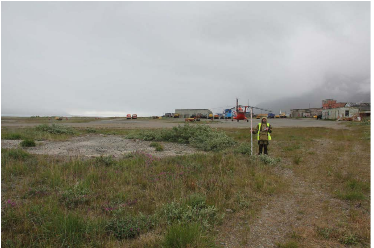
Рис.31. Чукотский АО, городской округ Эгвекинот, 2022 год. Проект реконструкции аэропорта “Залив Креста”. Направление фотосъемки на ЮЮЗ. Вид на центральный комплекс зданий аэропорта.
