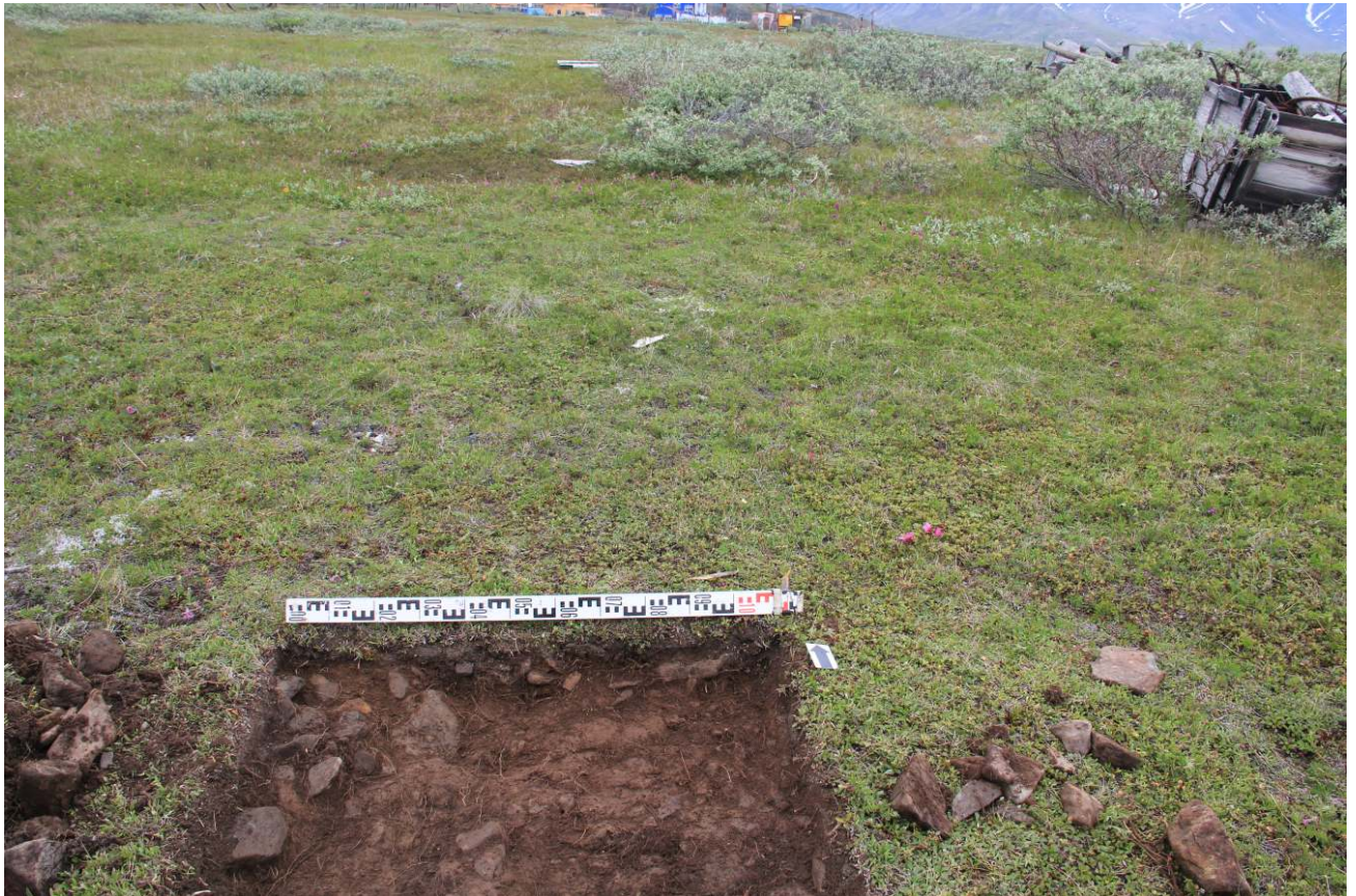
Рис. 61. Чукотский АО, городской округ Эгвекинот, 2022 год. Проект реконструкции аэропорта “Залив Креста”. Закладка шурфа на сохранившемся участке почв по борту ручья Дозорный. Северная стенка. Вид с Ю.
