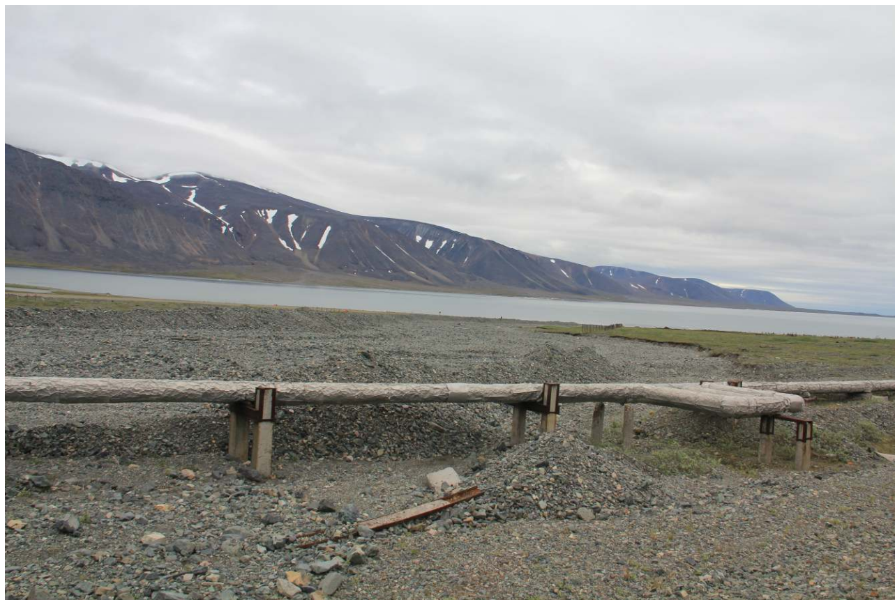
Рис.40. Чукотский АО, городской округ Эгвекинот, 2022 год. Проект реконструкции аэропорта “Залив Креста”. Русло руч. Дозорный. Направление съемки на ЮЮВ.
