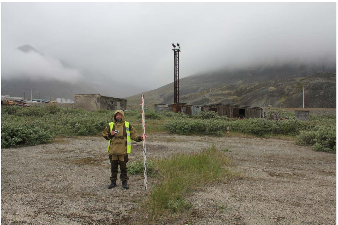
Рис.30. Чукотский АО, городской округ Эгвекинот, 2022 год. Проект реконструкции аэропорта “Залив Креста”. Направление фотосъемки на З. Вид на хоз. постройки у КПП.
