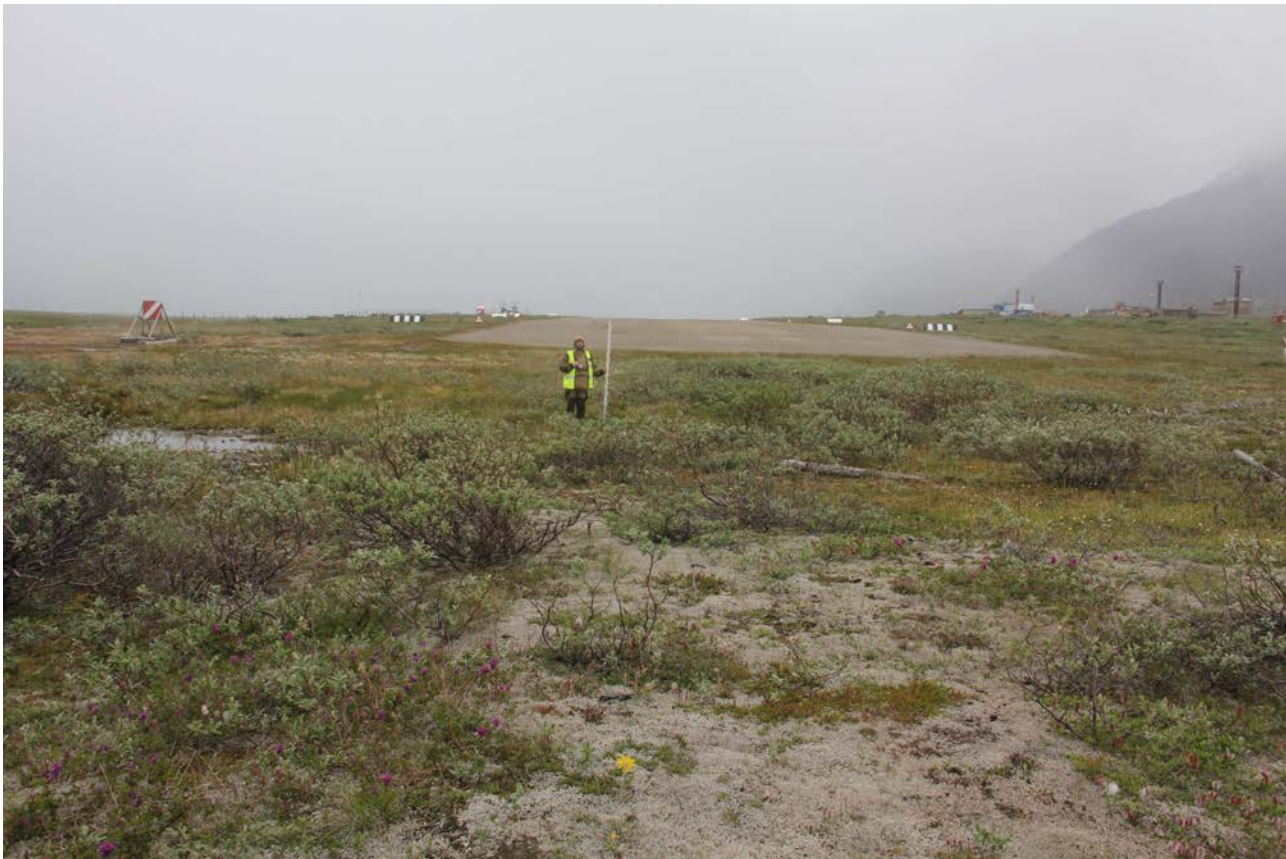
Рис.15. Чукотский АО, городской округ Эгвекинот, 2022 год. Проект реконструкции аэропорта “Залив Креста”. Направление фотосъемки на Ю. Вид на северную границу ВПП.
