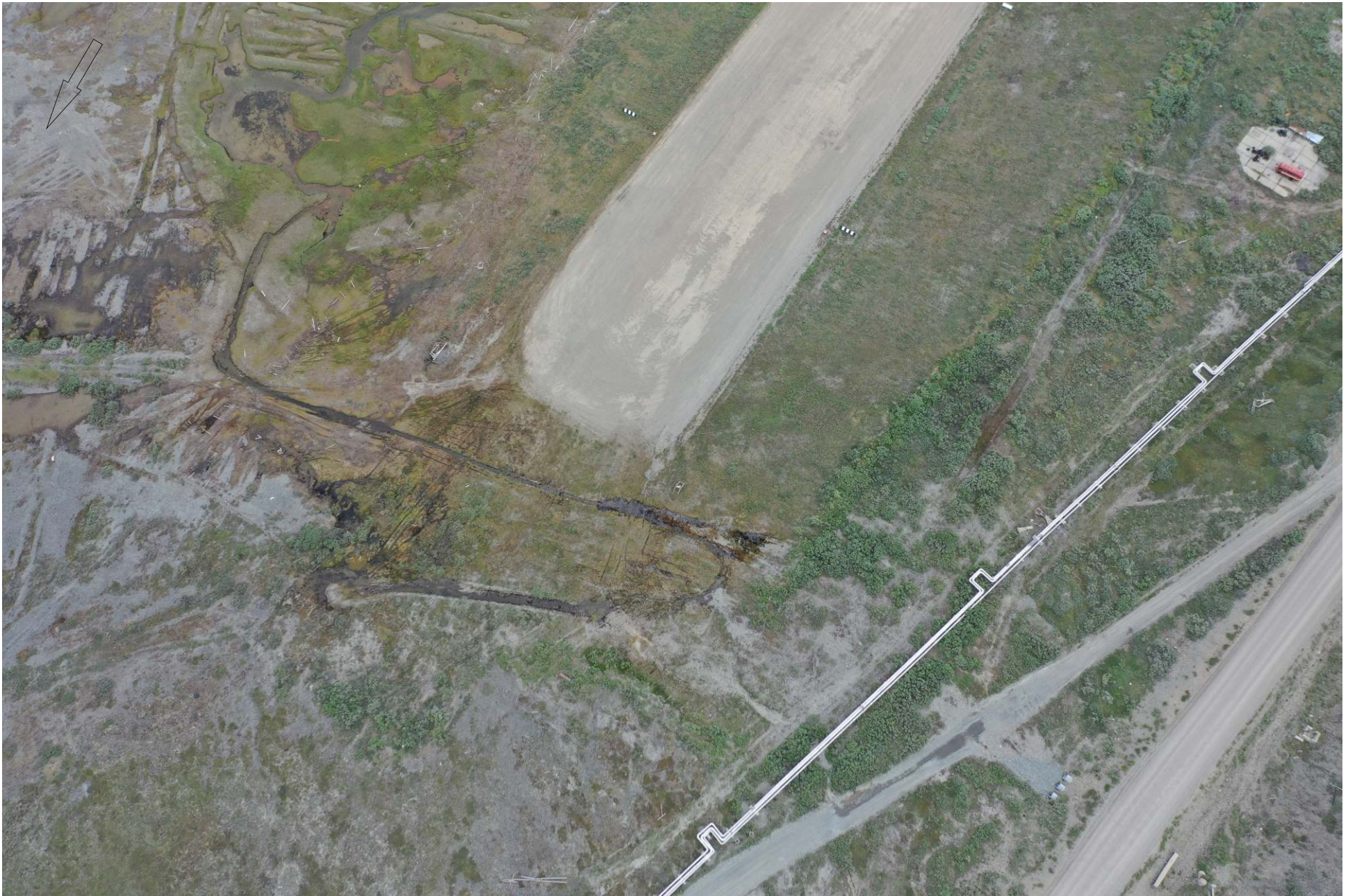
Рис. 9. Чукотский АО, городской округ Эгвекинот, 2022 год. Проект реконструкции аэропорта “Залив Креста”. Северная граница территории аэропорта (съемка квадрокоптером).
