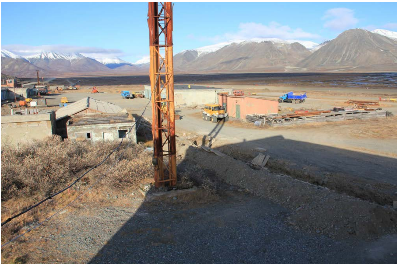
Рис.76 Чукотский АО, городской округ Эгвекинот, 2022 год. Проект реконструкции аэропорта “Залив Креста”. Канавка для труб водоснабжения у зданий аэровокзала, гаража, складов. Вид на СВ.
