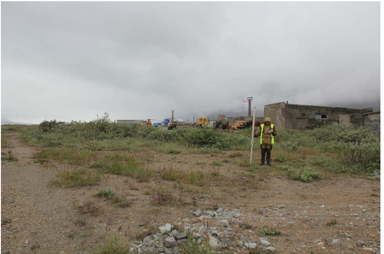
Рис.29. Чукотский АО, городской округ Эгвекинот, 2022 год. Проект реконструкции аэропорта “Залив Креста”. Направление фотосъемки на ЮЮЗ. Вид на хоз. постройки у КПП.
