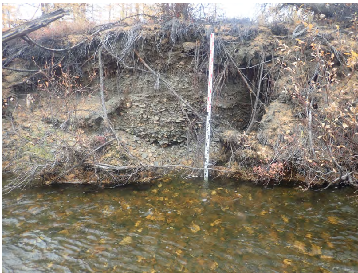
Рис. 229. СВАЭ-2022. Чукотский АО. Электроснабжение Баимского ГОК. ВЛ 330 кВ ПП Билибино-Баимский ГОК №2. ТФ 208 на участке 7. Характер рыхлых отложений правого берега безымянного ручья – сезонного притока р. Малый Анной в створе. Вид с запада.
