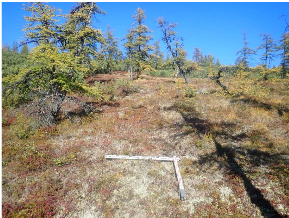
Рис. 366. СВАЭ-2022. Чукотский АО. Электроснабжение Баимского ГОК. ВЛ 330 кВ ПП Билибино-Баимский ГОК №2. Место расположения шурфа 28. Вид с востока.
