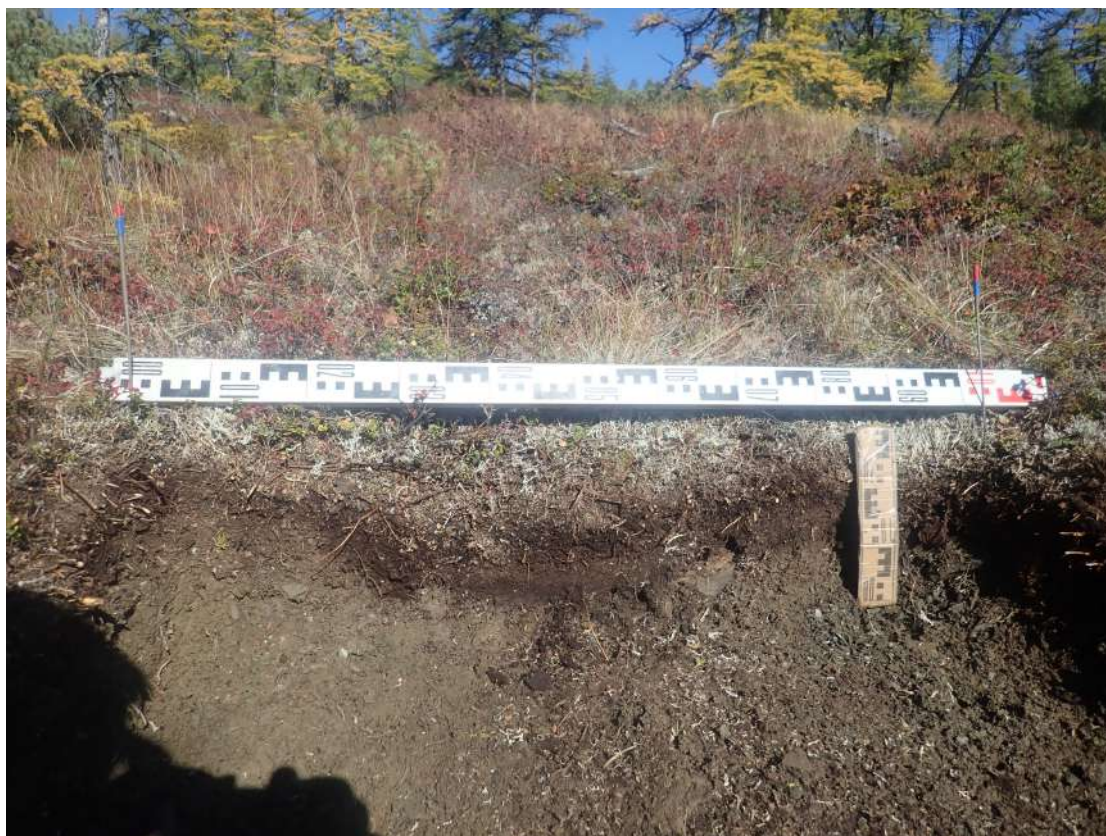
Рис. 318. СВАЭ-2022. Чукотский АО. Электроснабжение Баимского ГОК. ВЛ 330 кВ ПП Билибино-Баимский ГОК №2. Борт шурфа 14. Вид с востока.
