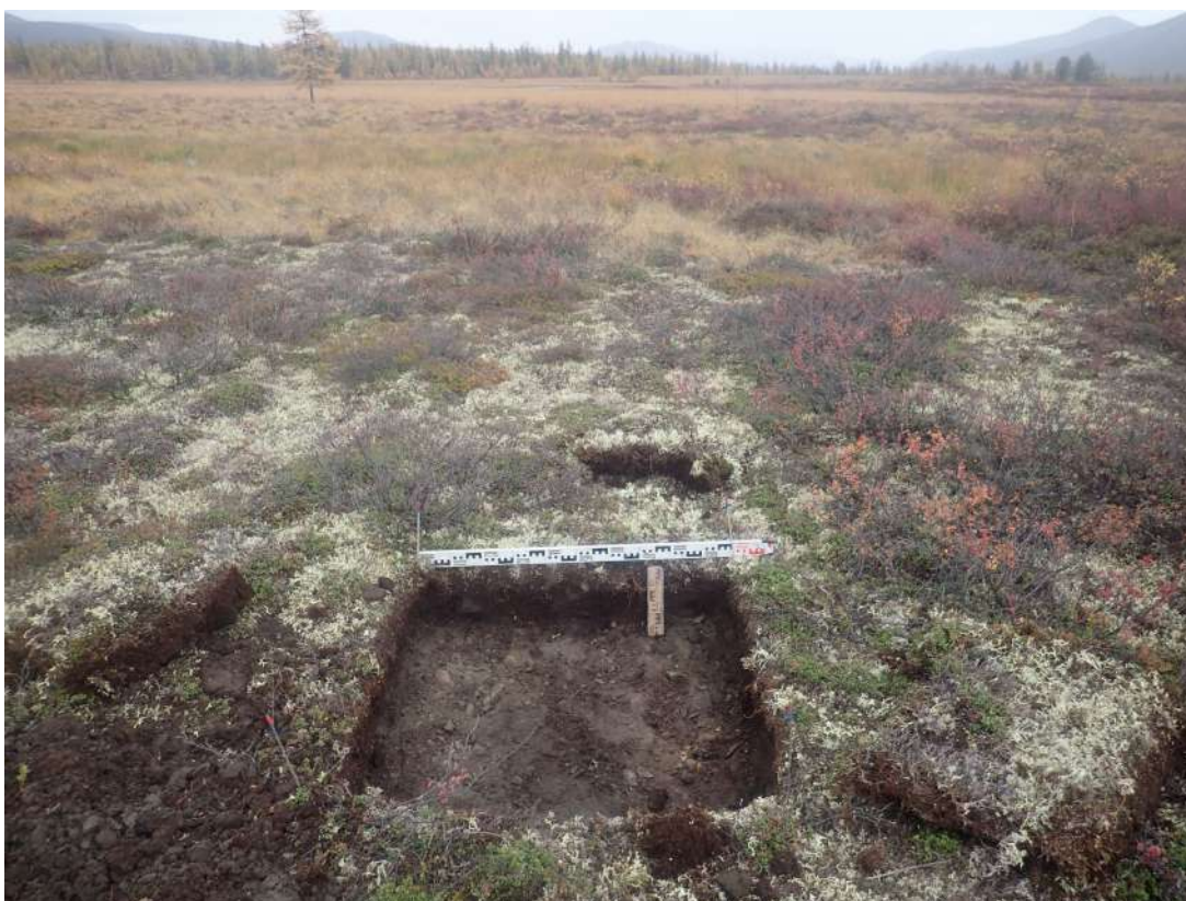
Рис. 357. СВАЭ-2022. Чукотский АО. Электроснабжение Баимского ГОК. ВЛ 330 кВ ПП Билибино-Баимский ГОК №2. Шурф 25 после вскрытия. Вид с юга.
