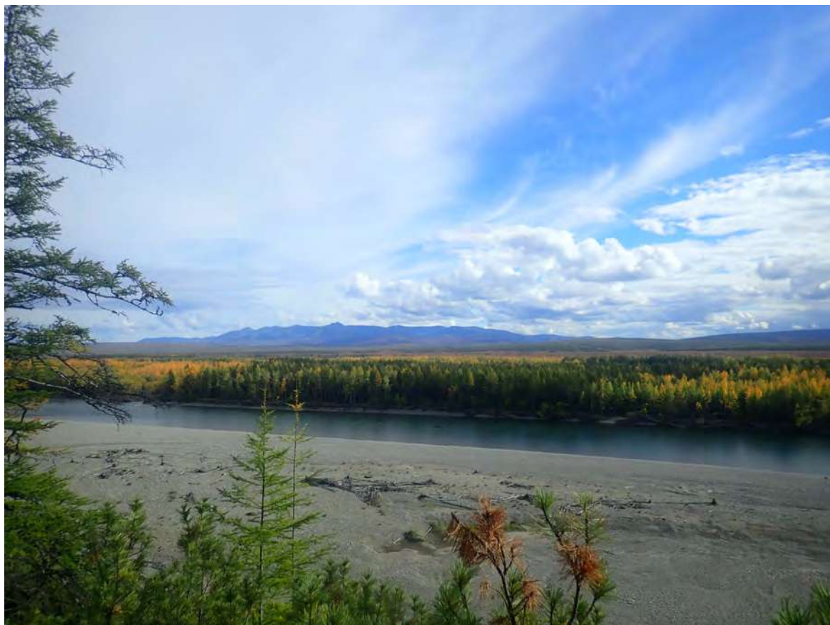
Рис. 260. СВАЭ-2022. Чукотский АО. Электроснабжение Баимского ГОК. ВЛ 330 кВ ПП Билибино-Баимский ГОК №2. ТФ 239 на участке 7. Вид с севера, с правого берега на левый берег Малого Анюя в месте перехода створа.
