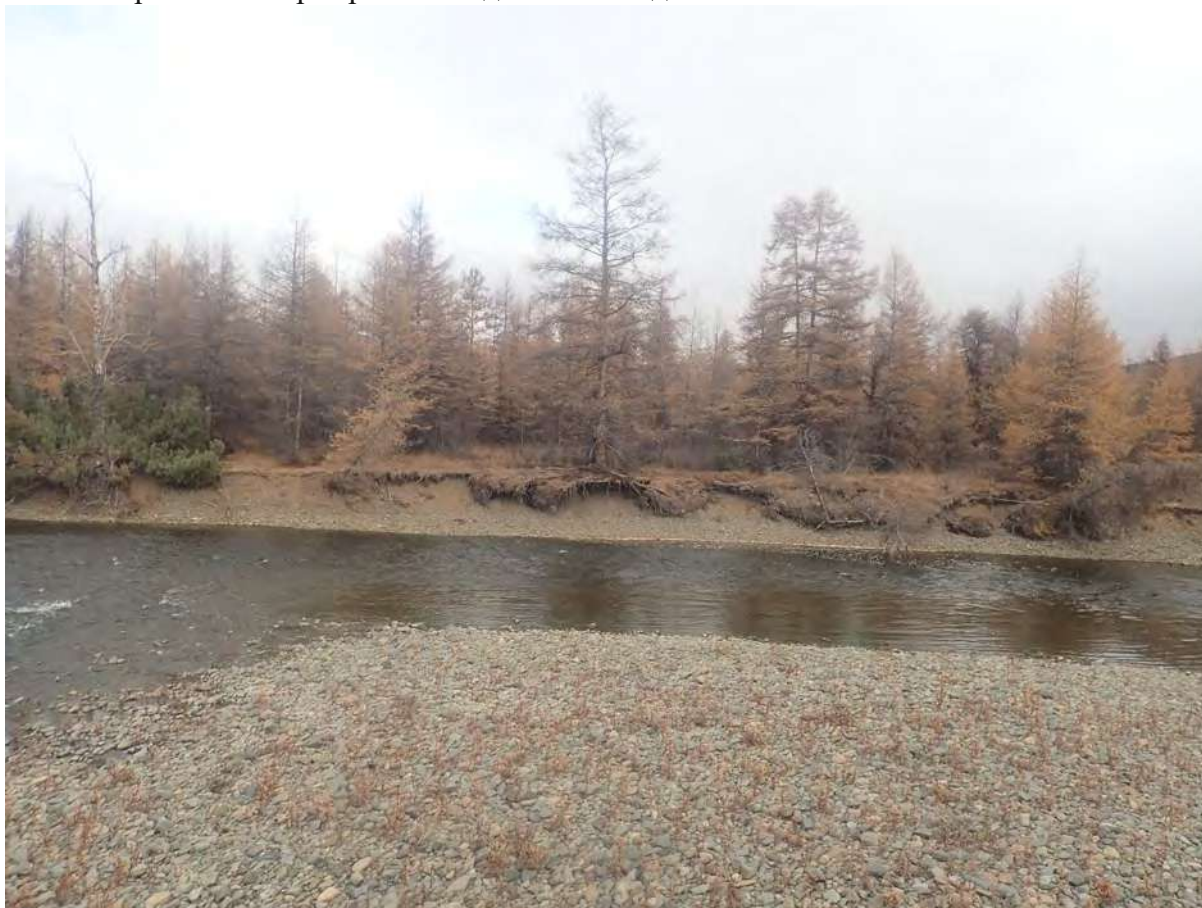
Рис. 91. СВАЭ-2022. Чукотский АО. Электроснабжение Баимского ГОК. ВЛ 330 кВ ПП Билибино-Баимский ГОК №2. ТФ 70 на участке 3. Правый берег р. Монни к востоку от створа Вид с юга.
