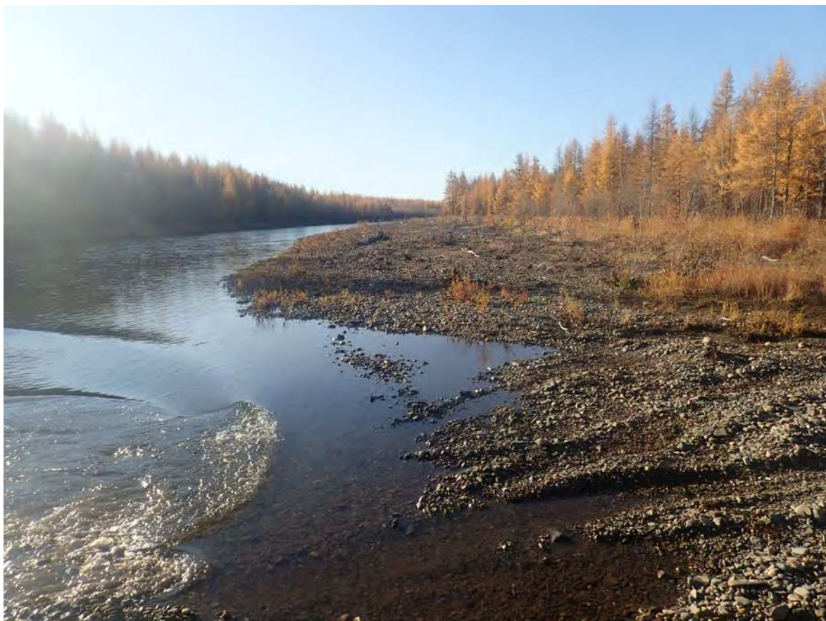
Рис. 206. СВАЭ-2022. Чукотский АО. Электроснабжение Баимского ГОК. ВЛ 330 кВ ПП Билибино-Баимский ГОК №2. ТФ 185 на участке 6. Переезд р. Тетемвеем в районе перехода створа. Вид с юга.
