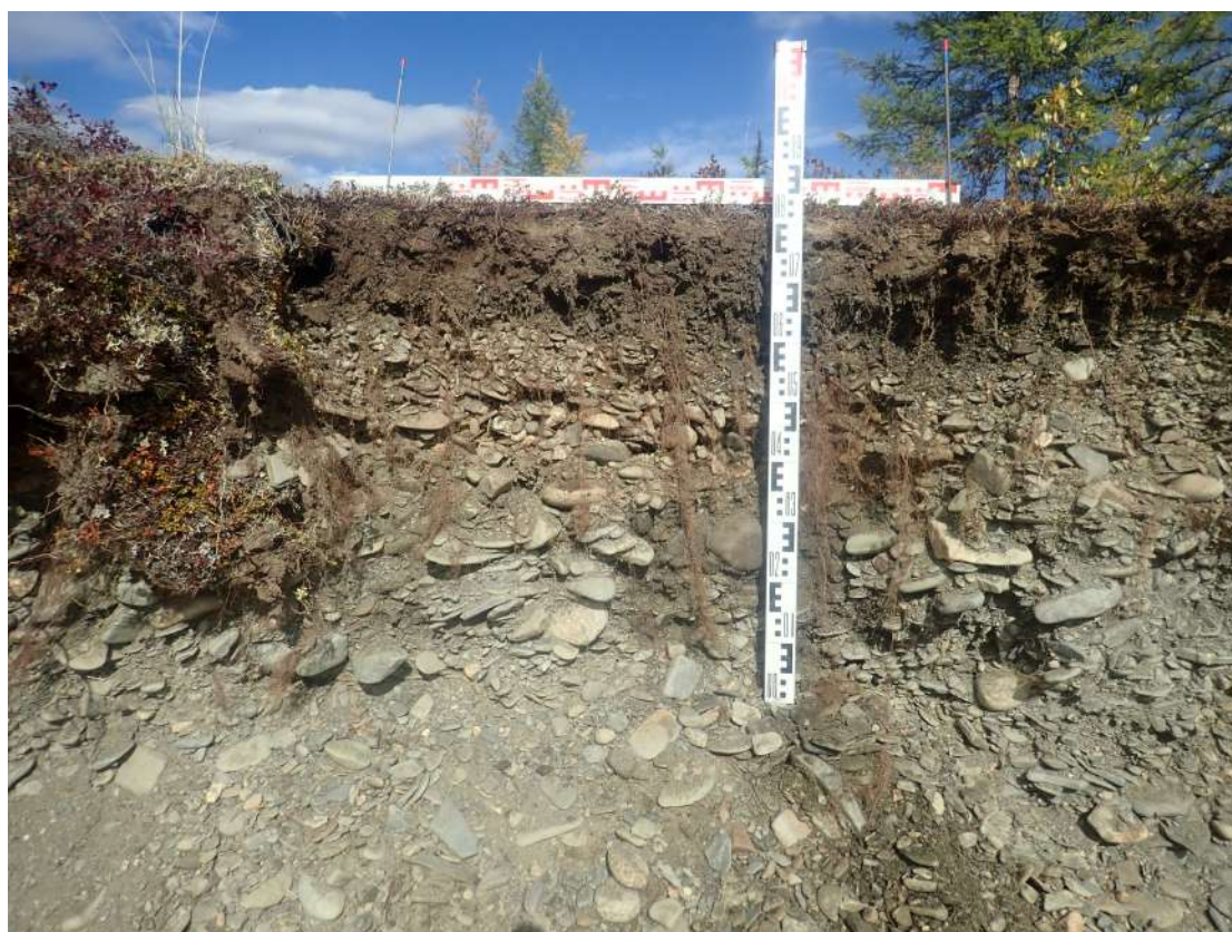
Рис. 331. СВАЭ-2022. Чукотский АО. Электроснабжение Баимского ГОК. ВЛ 330 кВ ПП Билибино-Баимский ГОК №2. Профиль зачистки 18. Вид с юго-востока.
