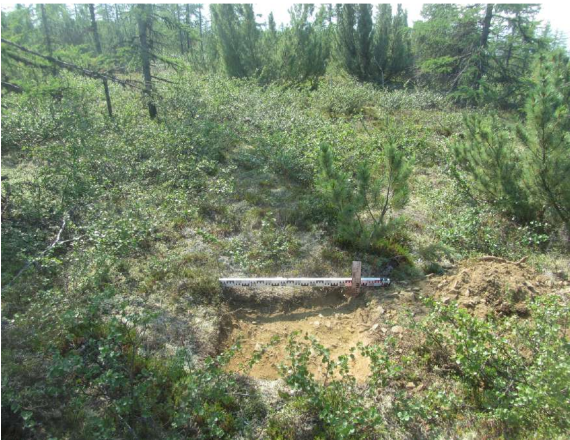
Рис. 409. СВАЭ-2022. Чукотский АО. Электроснабжение Баимского ГОК. ВЛ 330 кВ ПП Билибино-Баимский ГОК №2. Шурф 40 после вскрытия. Вид с востока.
