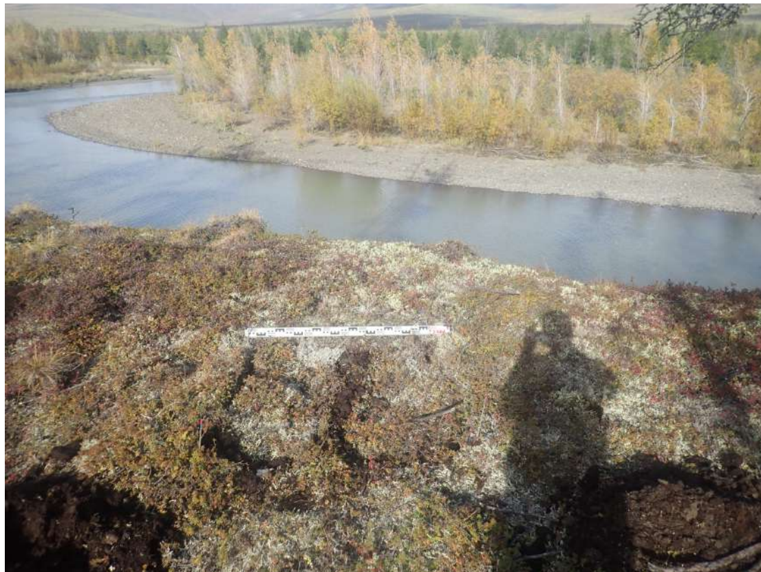
Рис. 339. СВАЭ-2022. Чукотский АО. Электроснабжение Баимского ГОК. ВЛ 330 кВ ПП Билибино-Баимский ГОК №2. Рекультивация шурфа 20. Вид с юга.
