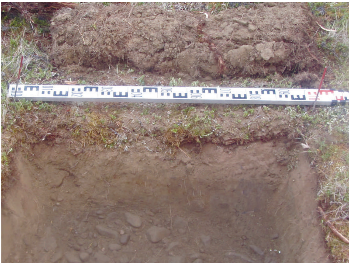
Рис. 394. СВАЭ-2022. Чукотский АО. Электроснабжение Баимского ГОК. ВЛ 330 кВ ПП Билибино-Баимский ГОК №2. Борт шурфа 35. Вид с запада.
