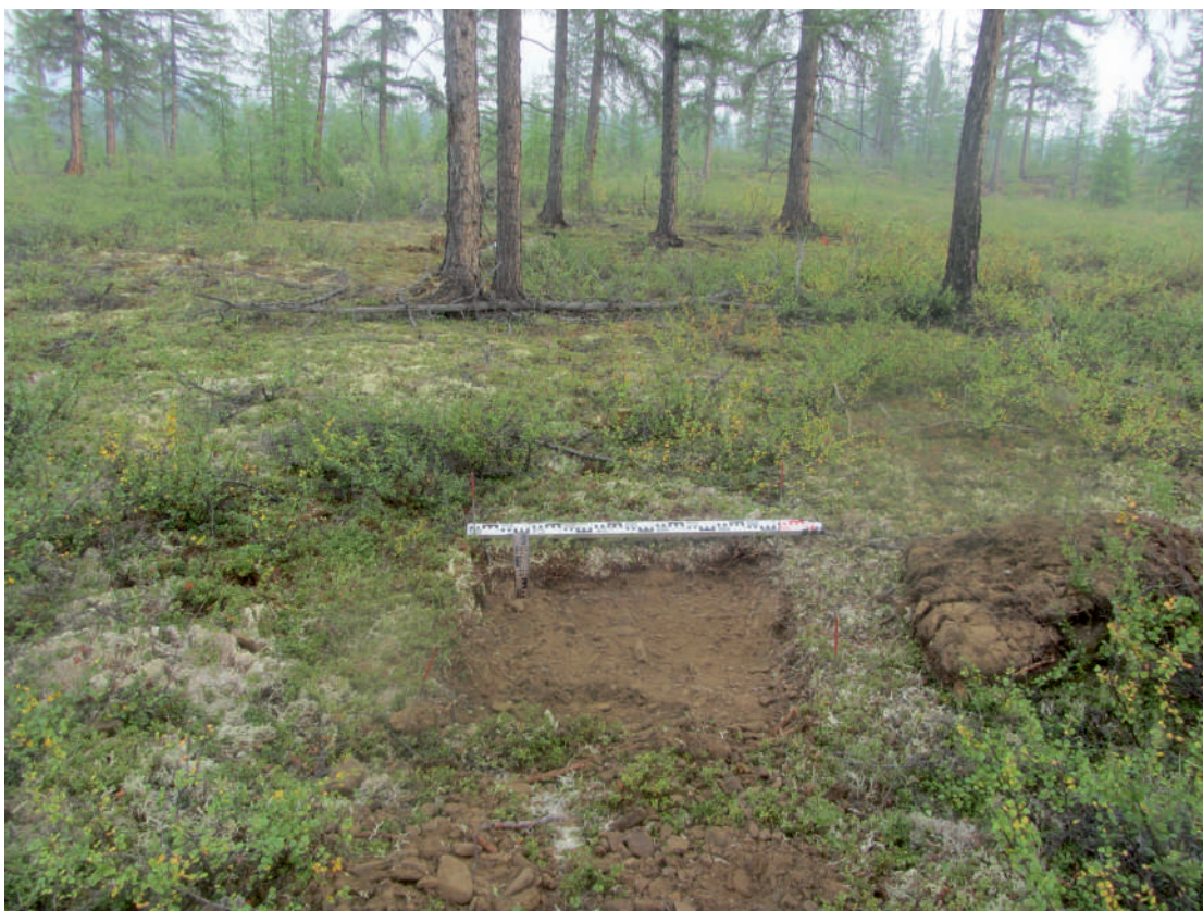
Рис. 389. СВАЭ-2022. Чукотский АО. Электроснабжение Баимского ГОК. ВЛ 330 кВ ПП Билибино-Баимский ГОК №2. Шурф 34 после вскрытия. Вид с юга.
