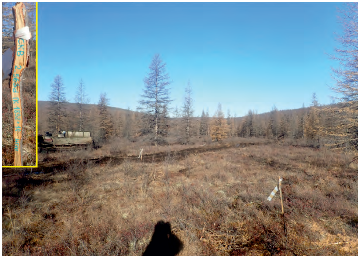
Рис. 228. СВАЭ-2022. Чукотский АО. Электроснабжение Баимского ГОК. ВЛ 330 кВ ПП Билибино-Баимский ГОК №2. ТФ 207 на участке 7. Вездеходная колея и буровые скважины ЦГЭИ на северном склоне г. Три Лиственницы в створе. Вид с северо-запада
