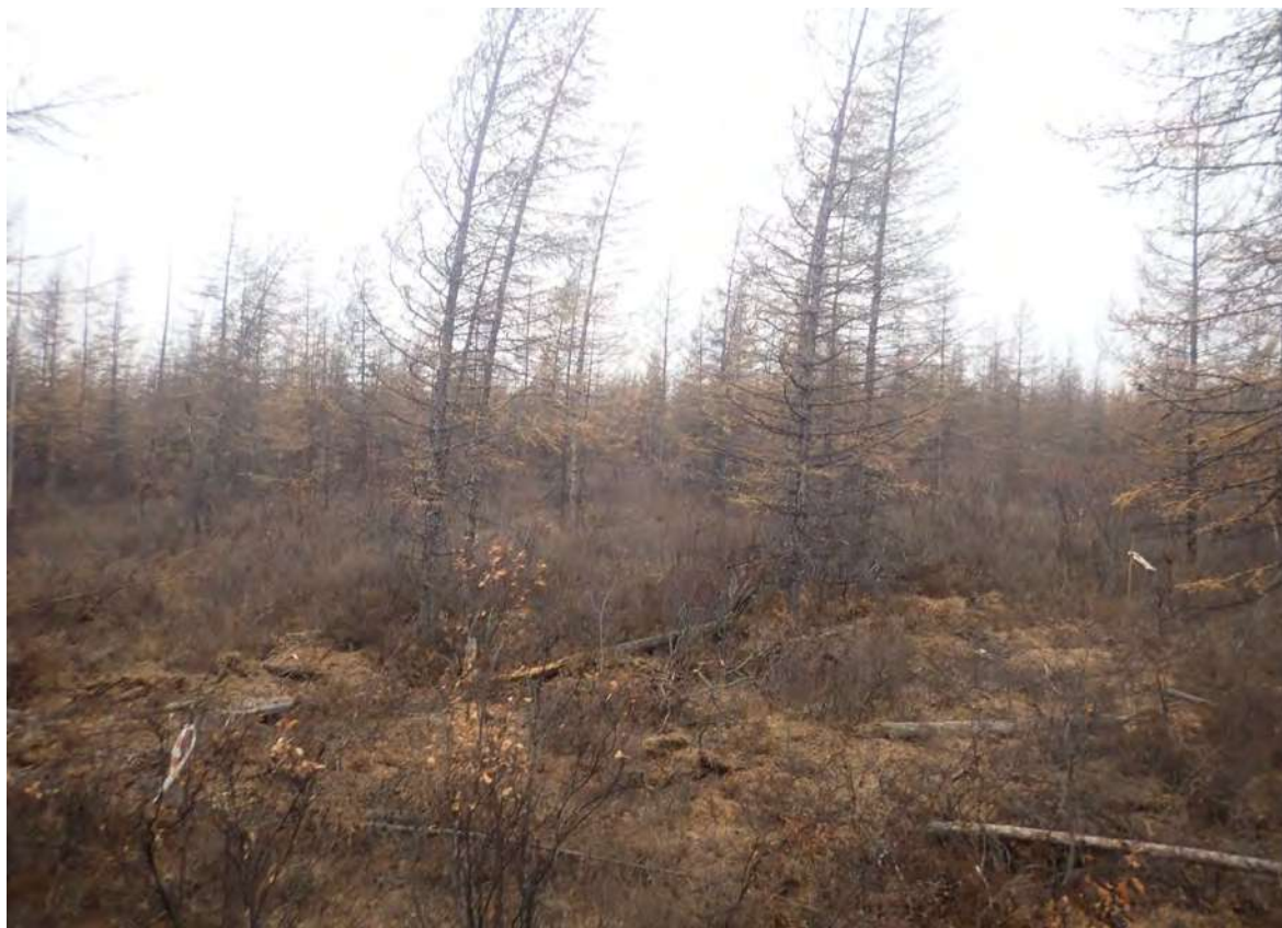
Рис. 186. СВАЭ-2022. Чукотский АО. Электроснабжение Баимского ГОК. ВЛ 330 кВ ПП Билибино-Баимский ГОК №1». ТФ 164 на участке 6. Буровые скважины ЦГЭИ в предгорной зоне г. Брусничная в долине р. Ургувеем. Вид с юга.
