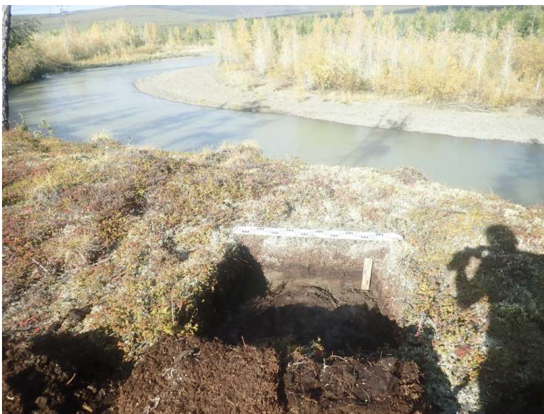
Рис. 337. СВАЭ-2022. Чукотский АО. Электроснабжение Баимского ГОК. ВЛ 330 кВ ПП Билибино-Баимский ГОК №2. Шурф 20 после вскрытия. Вид с юга.
