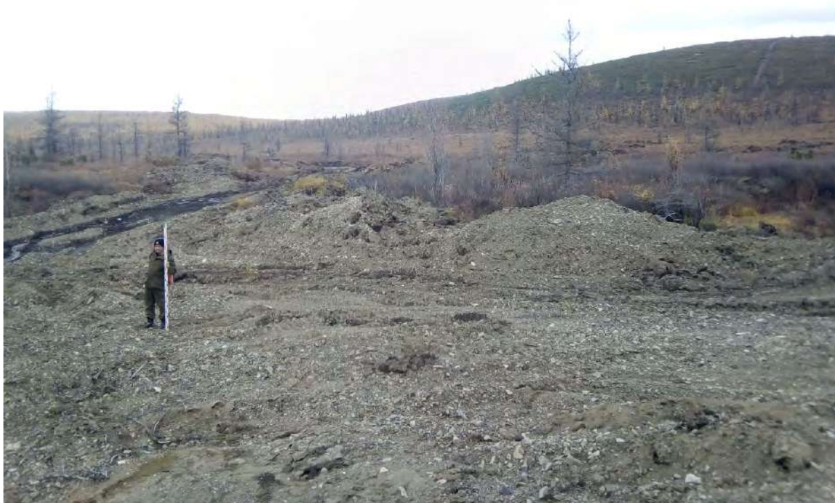
Рис. 22. СВАЭ-2022. Чукотский АО. Электроснабжение Баимского ГОК. ВЛ 330 кВ ПП Билибино-Баимский ГОК №2. ТФ 1 на участке 1. Вид с запада, с технологического проезда на долину р. Правая Песчанка в границах створа.
