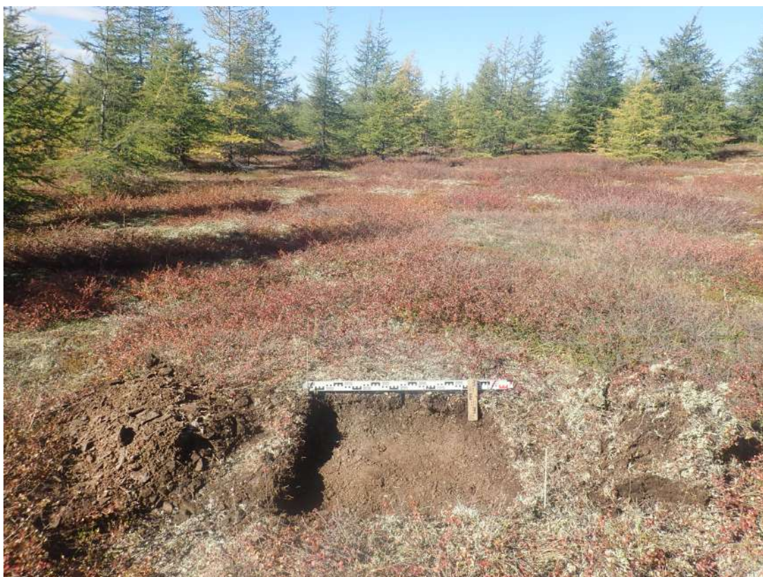
Рис. 497. СВАЭ-2022. Чукотский АО. Электроснабжение Баимского ГОК. ВЛ 330 кВ ПП Билибино-Баимский ГОК №2. Шурф 63 после вскрытия. Вид с севера.
