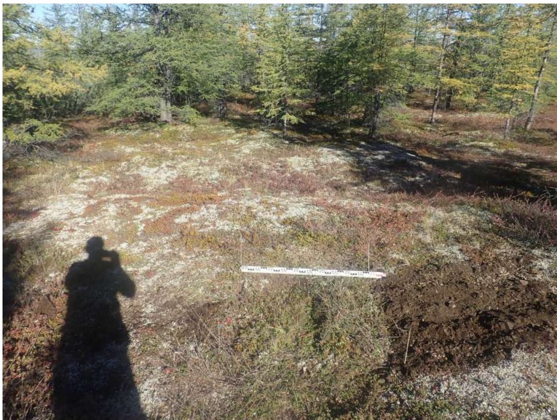
Рис. 465. СВАЭ-2022. Чукотский АО. Электроснабжение Баимского ГОК. ВЛ 330 кВ ПП Билибино-Баимский ГОК №2. Рекультивация шурфа 54. Вид с юга.
