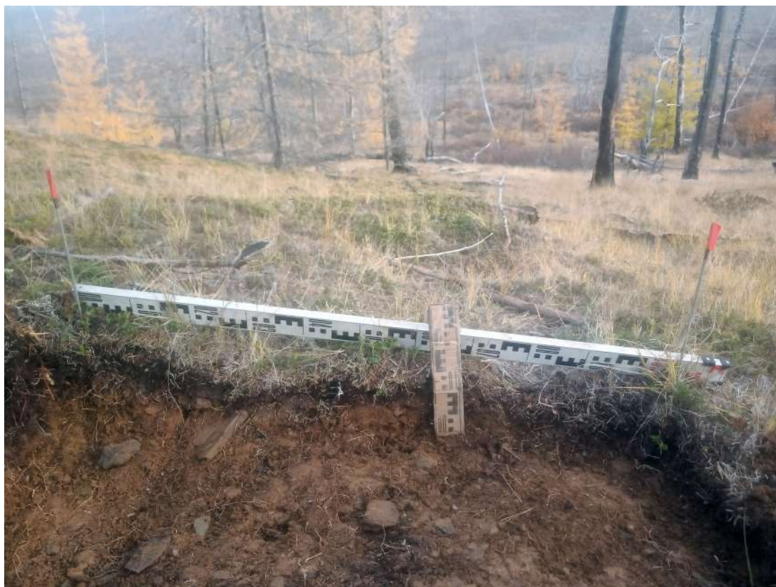
Рис. 354. СВАЭ-2022. Чукотский АО. Электроснабжение Баимского ГОК. ВЛ 330 кВ ПП Билибино-Баимский ГОК №2. Борт шурфа 24. Вид с востока.
