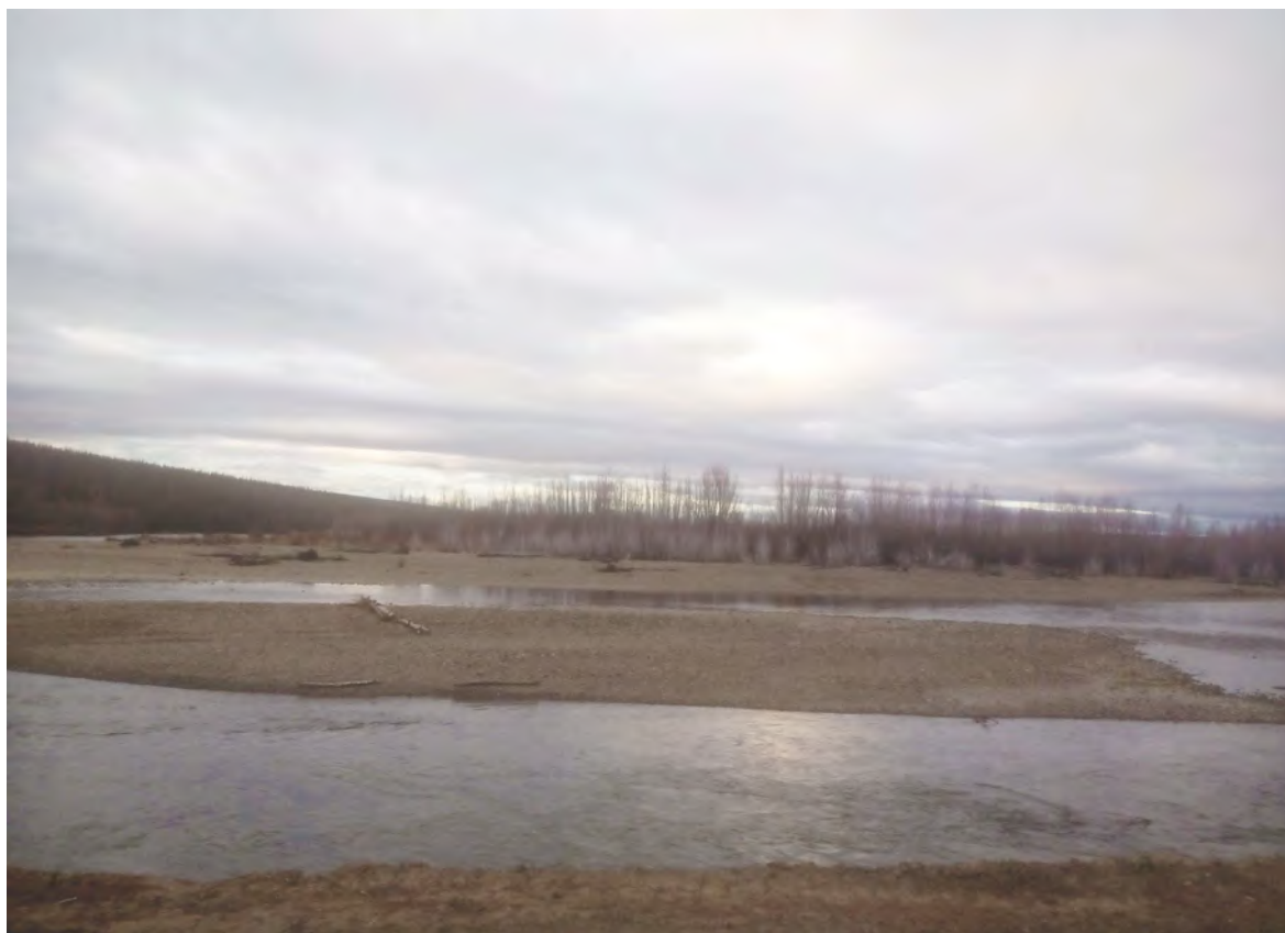
Рис. 182. СВАЭ-2022. Чукотский АО. Электроснабжение Баимского ГОК. ВЛ 330 кВ ПП Билибино-Баимский ГОК №1». ТФ 160 на участке 5. Р. Ургувеем в месте перехода створа. Вид с запада.
