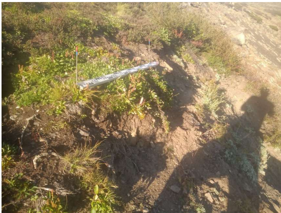
Рис. 530. СВАЭ-2022. Чукотский АО. Электроснабжение Баимского ГОК. ВЛ 330 кВ ПП Билибино-Баимский ГОК №2. Место расположения зачистки 73. Вид с северо-востока.
