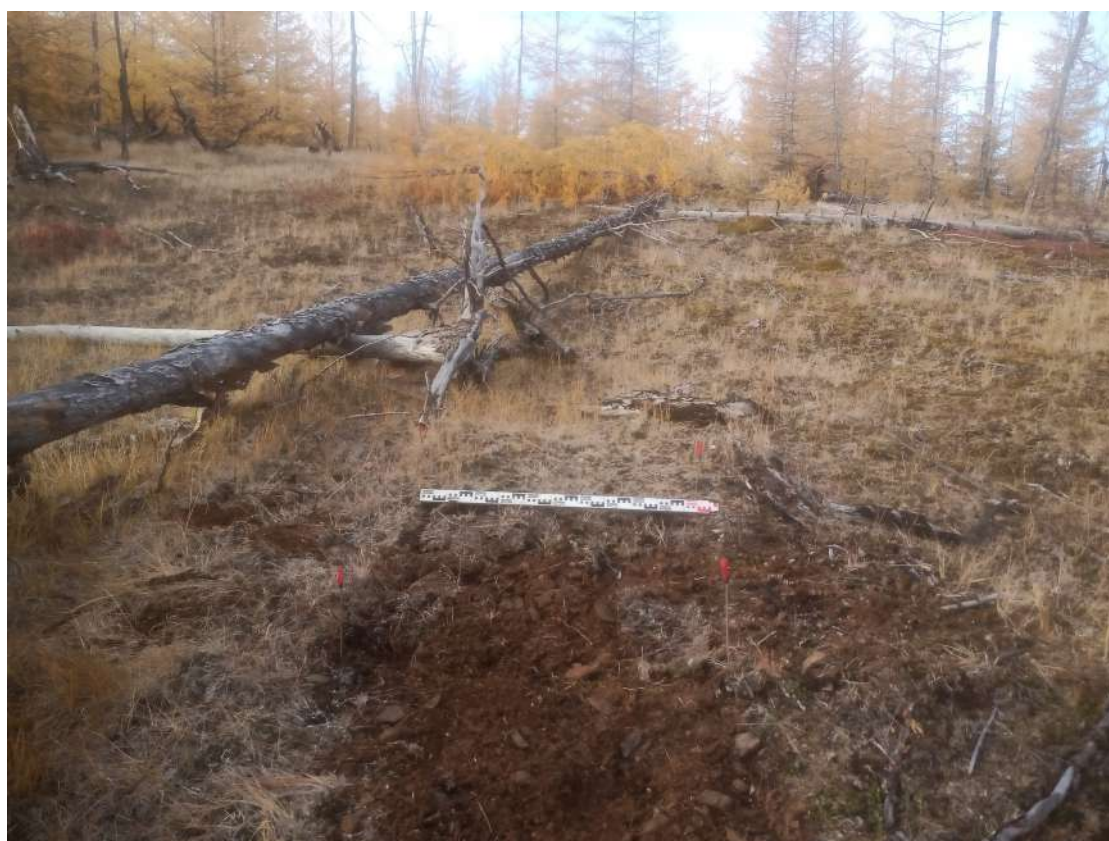
Рис. 351. СВАЭ-2022. Чукотский АО. Электроснабжение Баимского ГОК. ВЛ 330 кВ ПП Билибино-Баимский ГОК №2. Рекультивация шурфа 23. Вид с запада.
