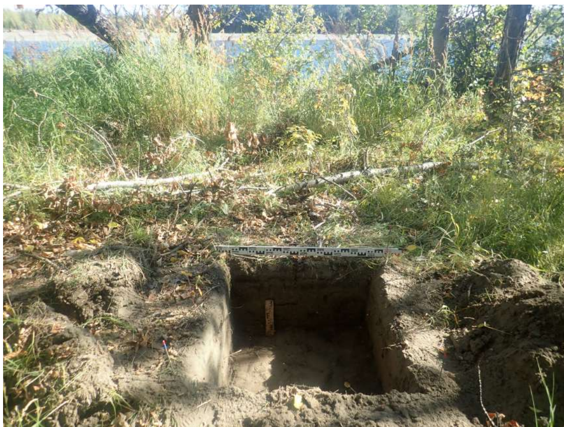
Рис. 527. СВАЭ-2022. Чукотский АО. Электроснабжение Баимского ГОК. ВЛ 330 кВ ПП Билибино-Баимский ГОК №2. Шурф 72 после вскрытия. Вид с севера.
