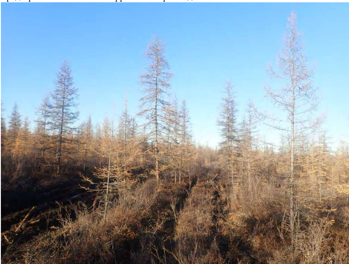
Рис. 61. СВАЭ-2022. Чукотский АО. Электроснабжение Баимского ГОК. ВЛ 330 кВ ПП Билибино-Баимский ГОК №2. ТФ 40 на участке 2. Вездеходная колея в районе истоков правого притока р. Орловка в створе. Вид с юга.
