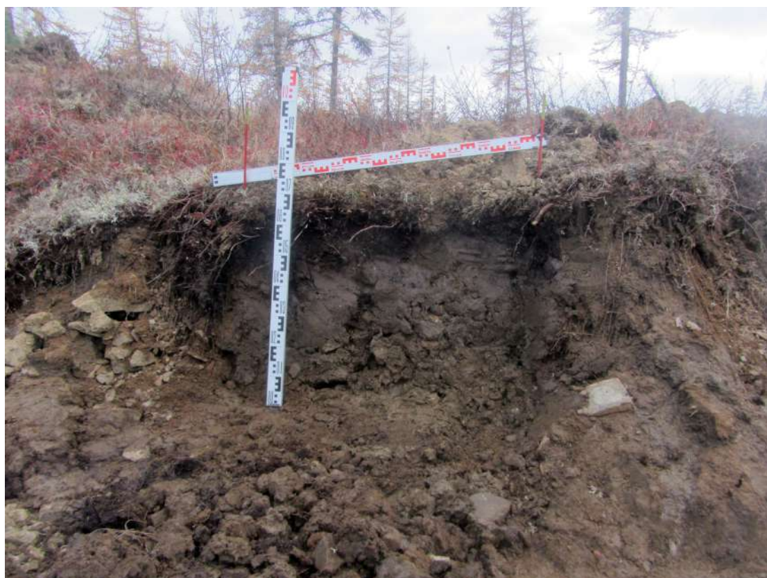
Рис. 273. СВАЭ-2022. Чукотский АО. Электроснабжение Баимского ГОК. ВЛ 330 кВ ПП Билибино-Баимский ГОК №2. Профиль зачистки 1. Вид с запада.
