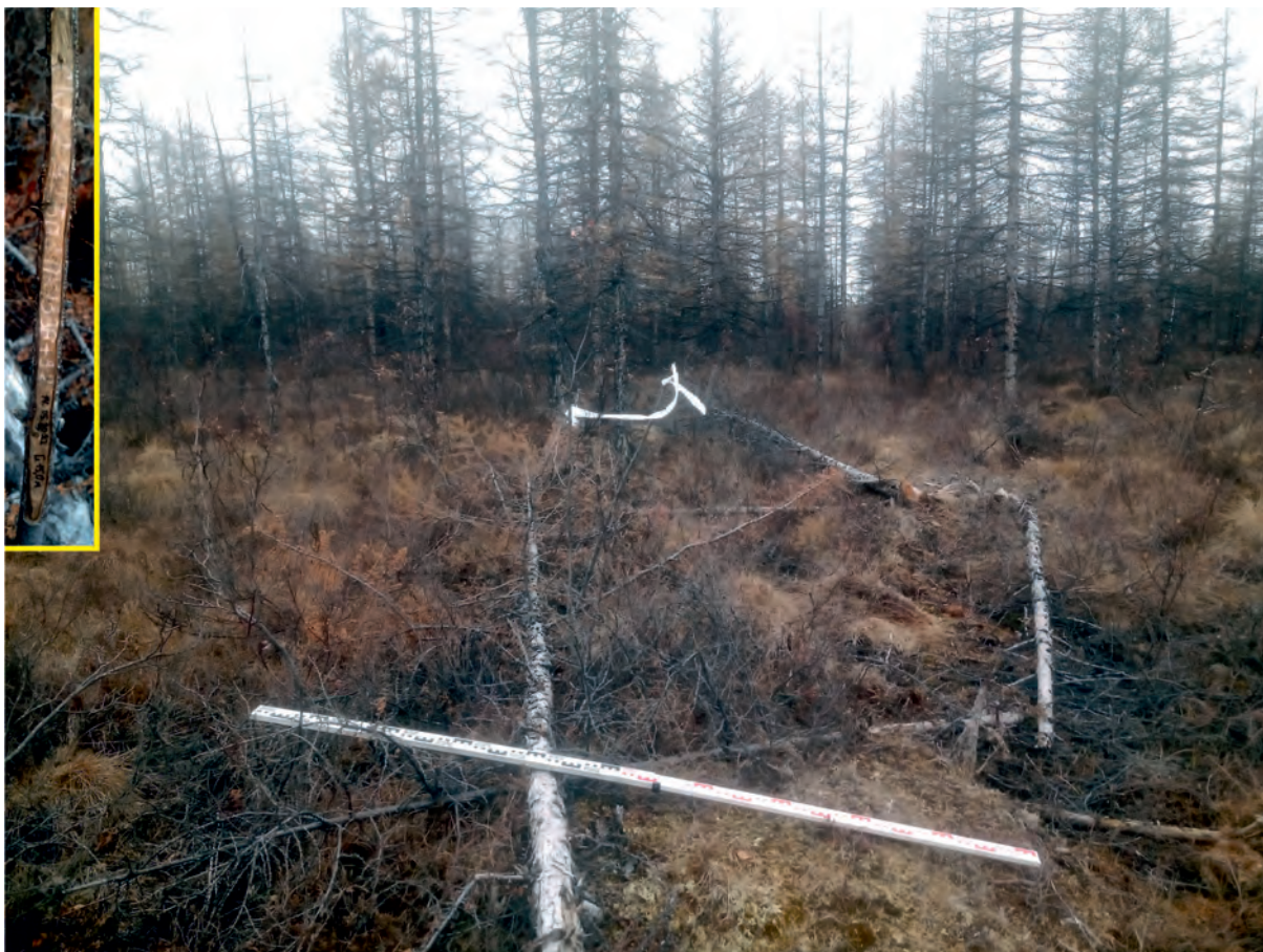
Рис. 147. СВАЭ-2022. Чукотский АО. Электроснабжение Баимского ГОК. ВЛ 330 кВ ПП Билибино-Баимский ГОК №2. ТФ 127 на участке 5. Буровая скважина ЦГЭИ на правом берегу безымянного правого притока р. Широкая Падь в районе перехода створа. Вид с востока.
