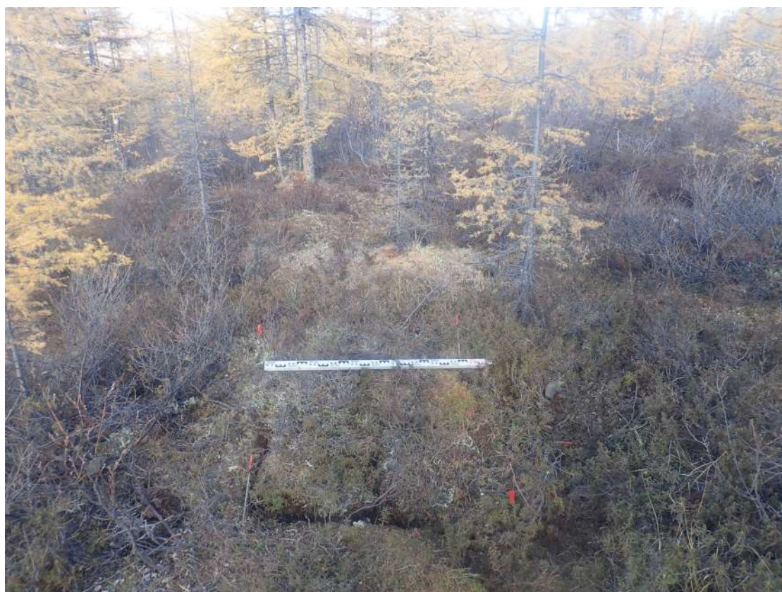
Рис. 335. СВАЭ-2022. Чукотский АО. Электроснабжение Баимского ГОК. ВЛ 330 кВ ПП Билибино-Баимский ГОК №2. Рекультивация шурфа 19. Вид с юга.
