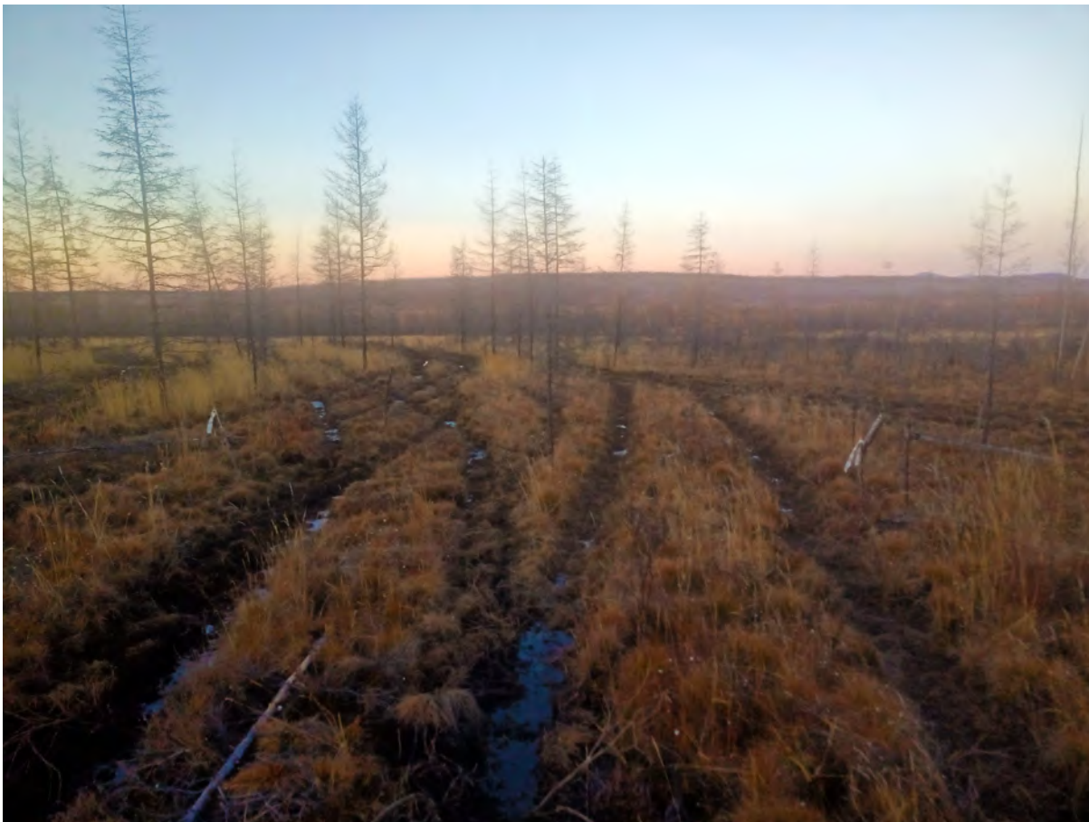
Рис. 72. СВАЭ-2022. Чукотский АО. Электроснабжение Баимского ГОК. ВЛ 330 кВ ПП Билибино-Баимский ГОК №2. ТФ 51 на участке 2. Вид с востока на долину р Уямканда с заболоченной низменности в долине р. Прорва.
