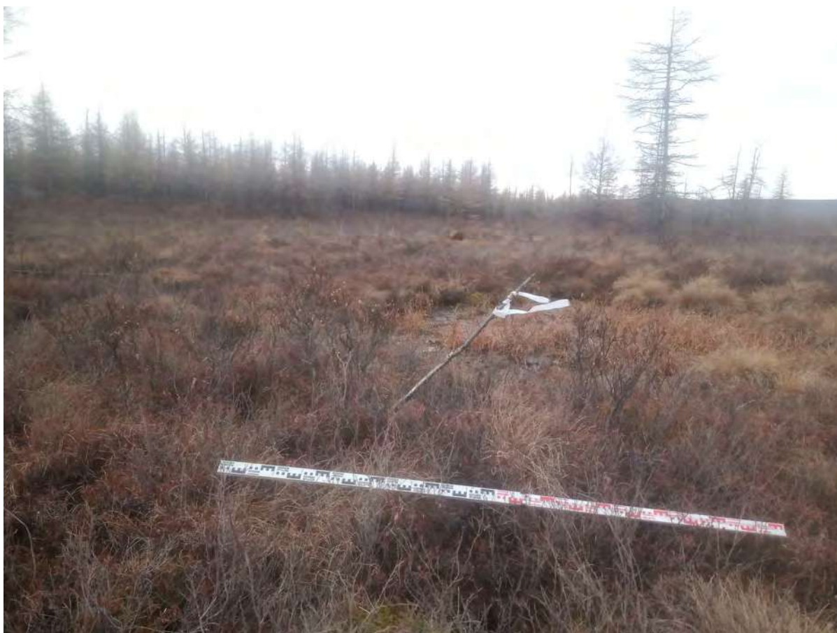
Рис. 112. СВАЭ-2022. Чукотский АО. Электроснабжение Баимского ГОК. ВЛ 330 кВ ПП Билибино-Баимский ГОК №2. ТФ 91 на участке 4. Буровая скважина ЦГЭИ в русле р. Марь в створе трассы. Вид с юго-запада.
