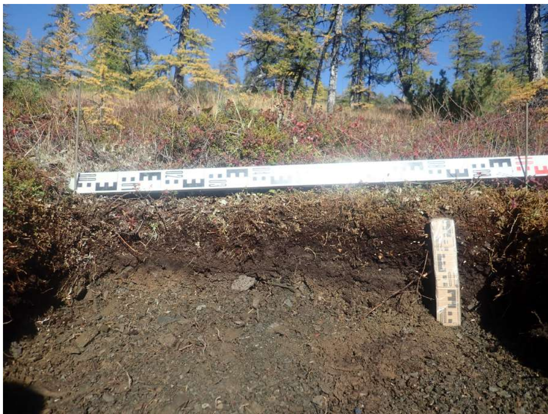
Рис. 310. СВАЭ-2022. Чукотский АО. Электроснабжение Баимского ГОК. ВЛ 330 кВ ПП Билибино-Баимский ГОК №2. Борт шурфа 12. Вид с севера.
