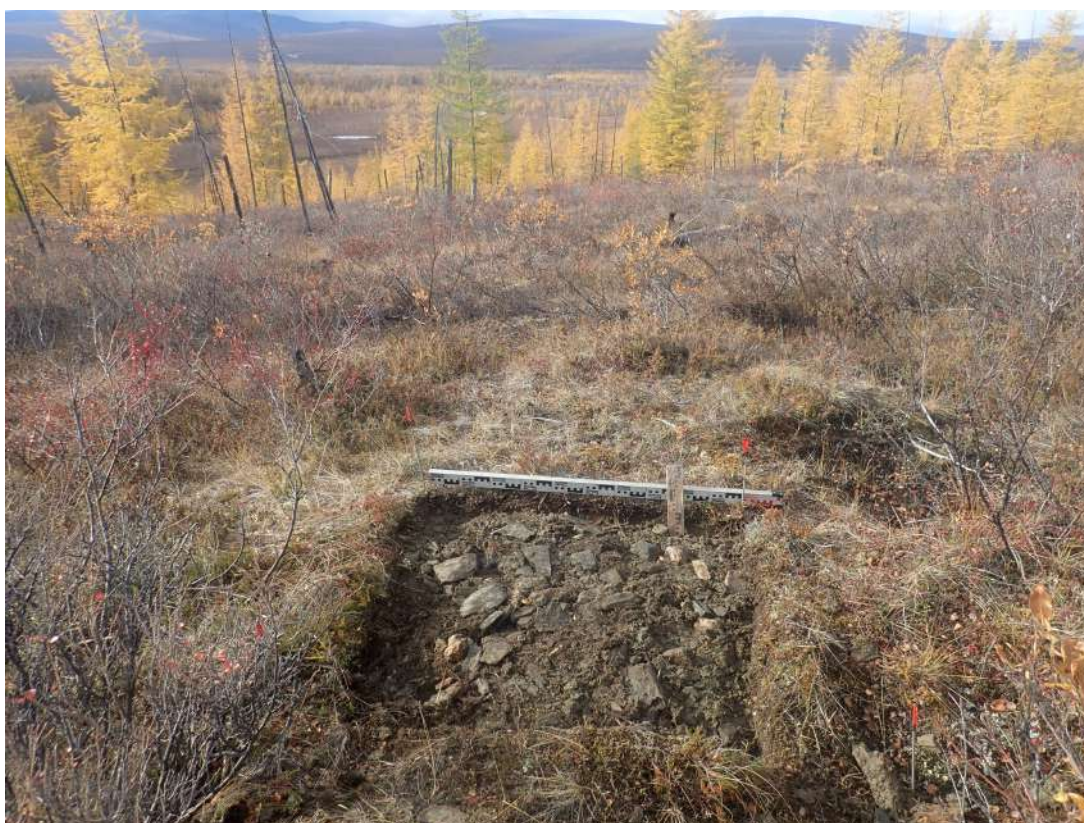
Рис. 467. СВАЭ-2022. Чукотский АО. Электроснабжение Баимского ГОК. ВЛ 330 кВ ПП Билибино-Баимский ГОК №2. Шурф 55 после вскрытия. Вид с запада.
