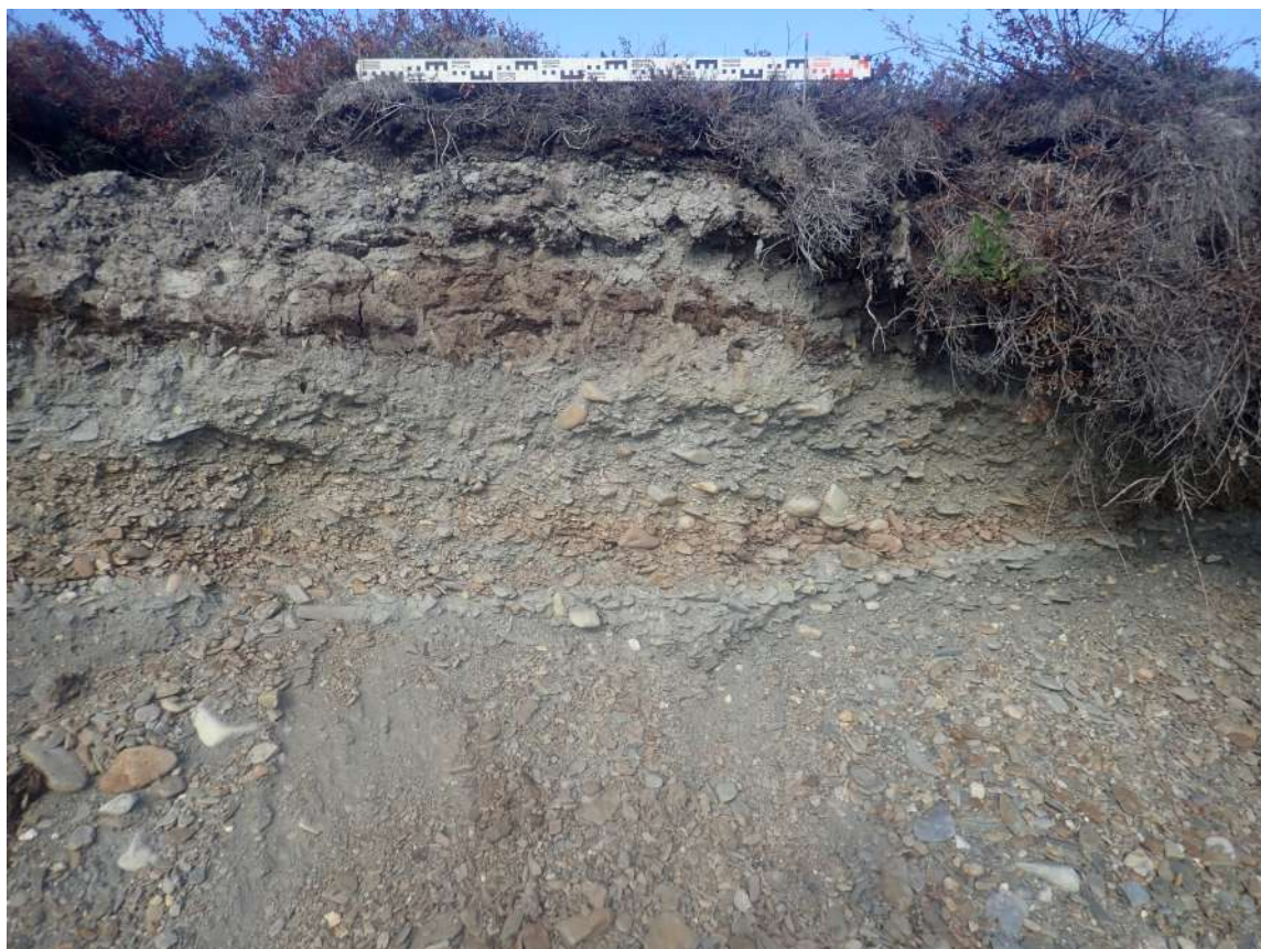
Рис. 436. СВАЭ-2022. Чукотский АО. Электроснабжение Баимского ГОК. ВЛ 330 кВ ПП Билибино-Баимский ГОК №2. Место расположения зачистки 47. Вид с запада.
