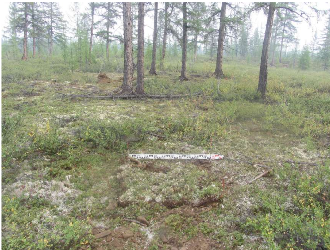
Рис. 391. СВАЭ-2022. Чукотский АО. Электроснабжение Баимского ГОК. ВЛ 330 кВ ПП Билибино-Баимский ГОК №2. Рекультивация шурфа 34. Вид с юга.
