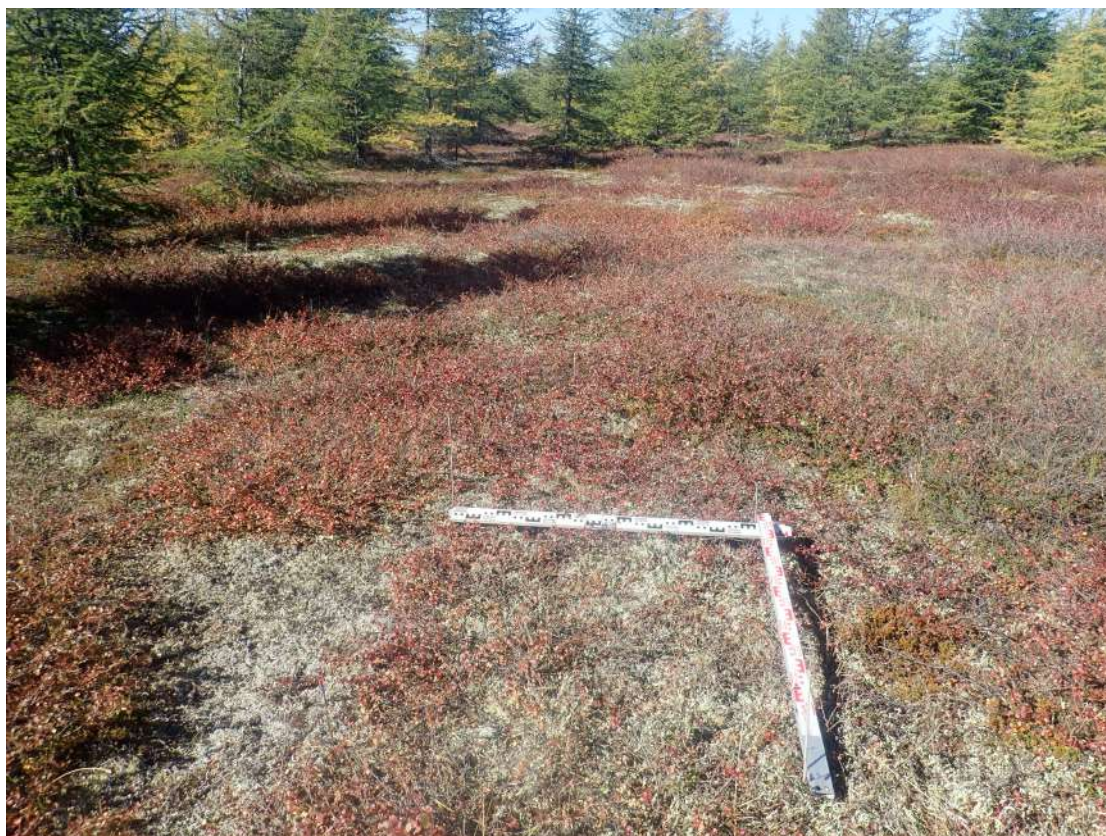
Рис. 496. СВАЭ-2022. Чукотский АО. Электроснабжение Баимского ГОК. ВЛ 330 кВ ПП Билибино-Баимский ГОК №2. Место расположения шурфа 63. Вид с севера.
