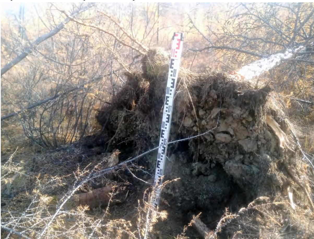
Рис. 49. СВАЭ-2022. Чукотский АО. Электроснабжение Баимского ГОК. ВЛ 330 кВ ПП Билибино-Баимский ГОК №2. ТФ 28 на участке 2. Выворот на западном склоне вершины 408 м в створе. Вид запада.
