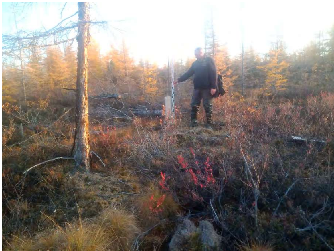
Рис. 224. СВАЭ-2022. Чукотский АО. Электроснабжение Баимского ГОК. ВЛ 330 кВ ПП Билибино-Баимский ГОК №2. ТФ 203 на участке 7. Заготовка топографического знака в долине р. Тетемвеем в створе. Вид с юго-запада.
