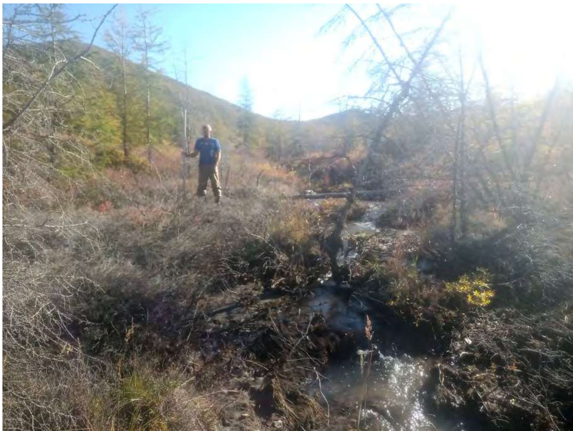
Рис. 234. СВАЭ-2022. Чукотский АО. Электроснабжение Баимского ГОК. ВЛ 330 кВ ПП Билибино-Баимский ГОК №2. ТФ 213 на участке 7. Правый берег ручья Глубокий - приток р. Малый Анюй - в створе. Вид с севера.
