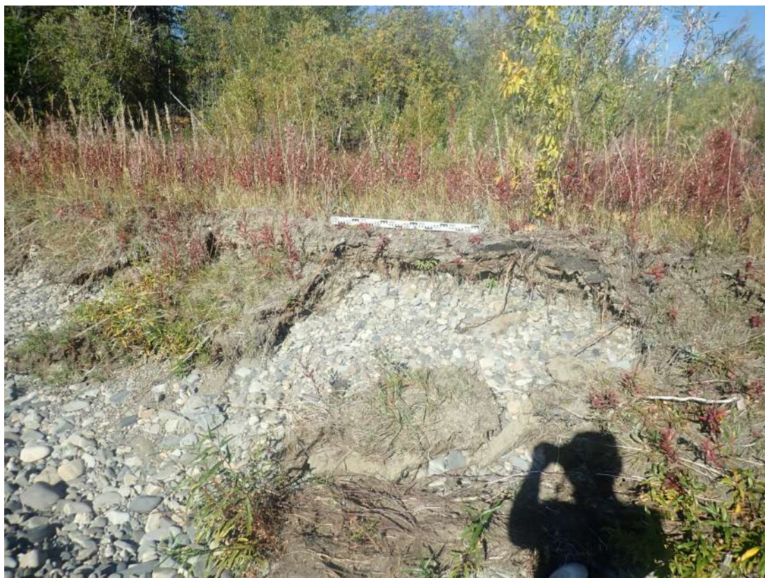
Рис. 294. СВАЭ-2022. Чукотский АО. Электроснабжение Баимского ГОК. ВЛ 330 кВ ПП Билибино-Баимский ГОК №2. Место расположения зачистки 7. Вид с юго-запада.
