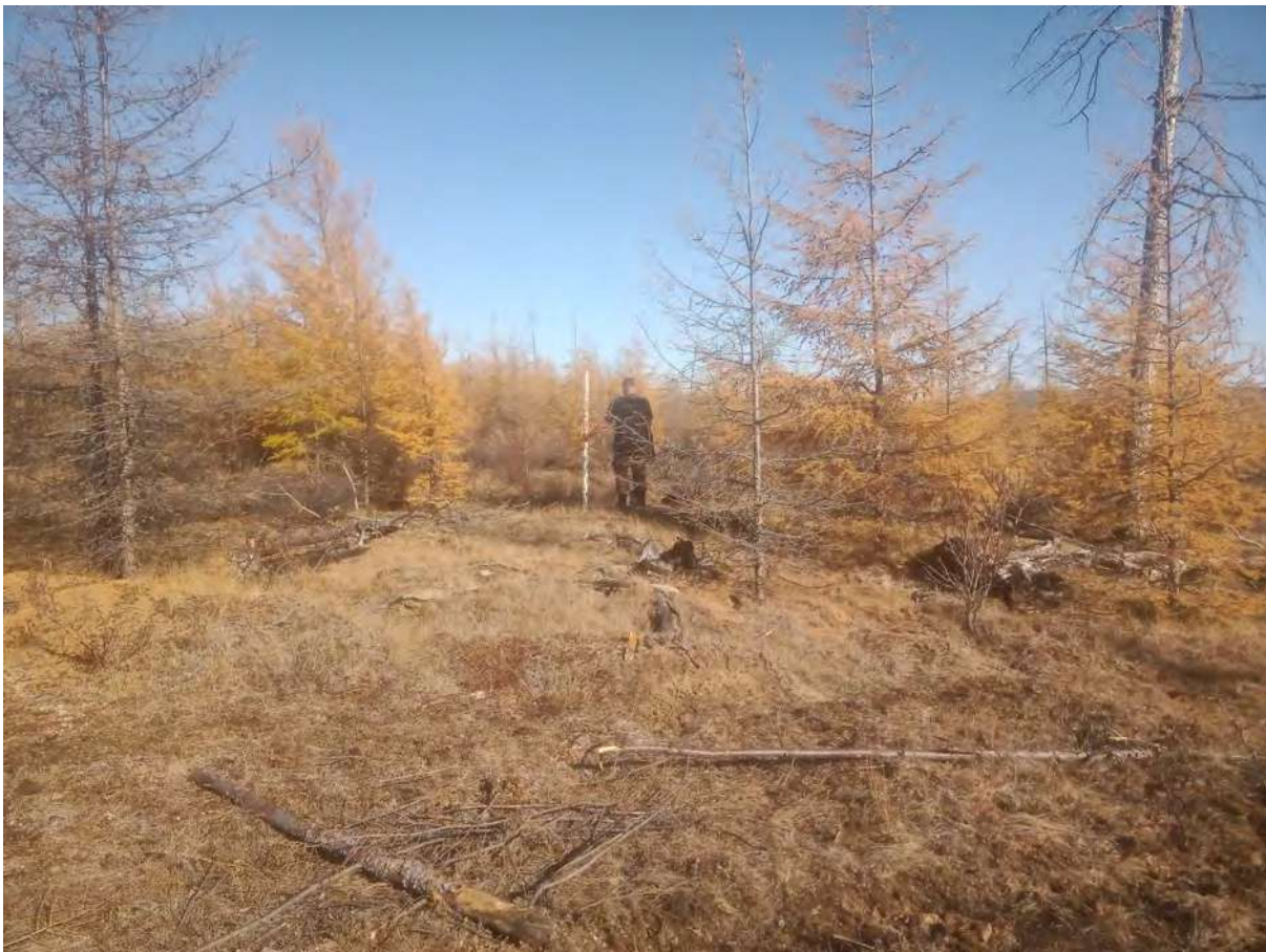
Рис. 46. СВАЭ-2022. Чукотский АО. Электроснабжение Баимского ГОК. ВЛ 330 кВ ПП Билибино-Баимский ГОК №2. ТФ 25 на участке 2. Юго-западный склон вершины 408 м в створе. Вид с запада.
