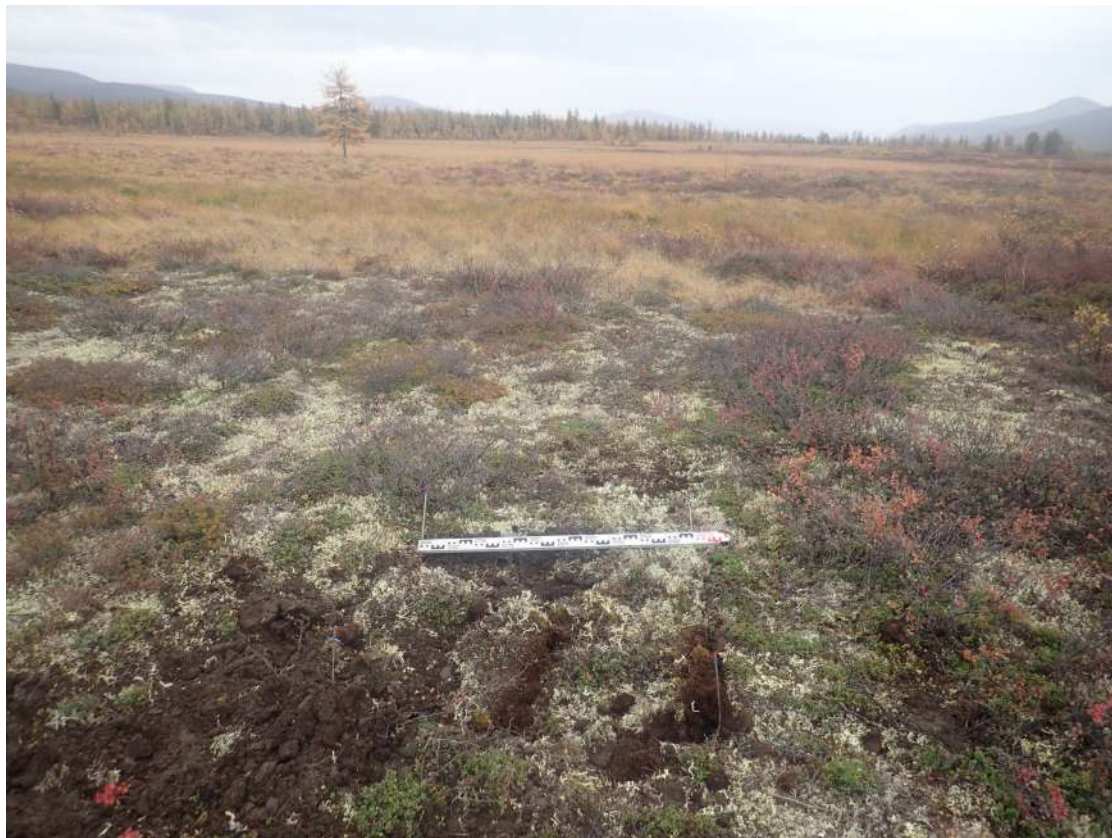
Рис. 359. СВАЭ-2022. Чукотский АО. Электроснабжение Баимского ГОК. ВЛ 330 кВ ПП Билибино-Баимский ГОК №2. Рекультивация шурфа 25. Вид с юга.
