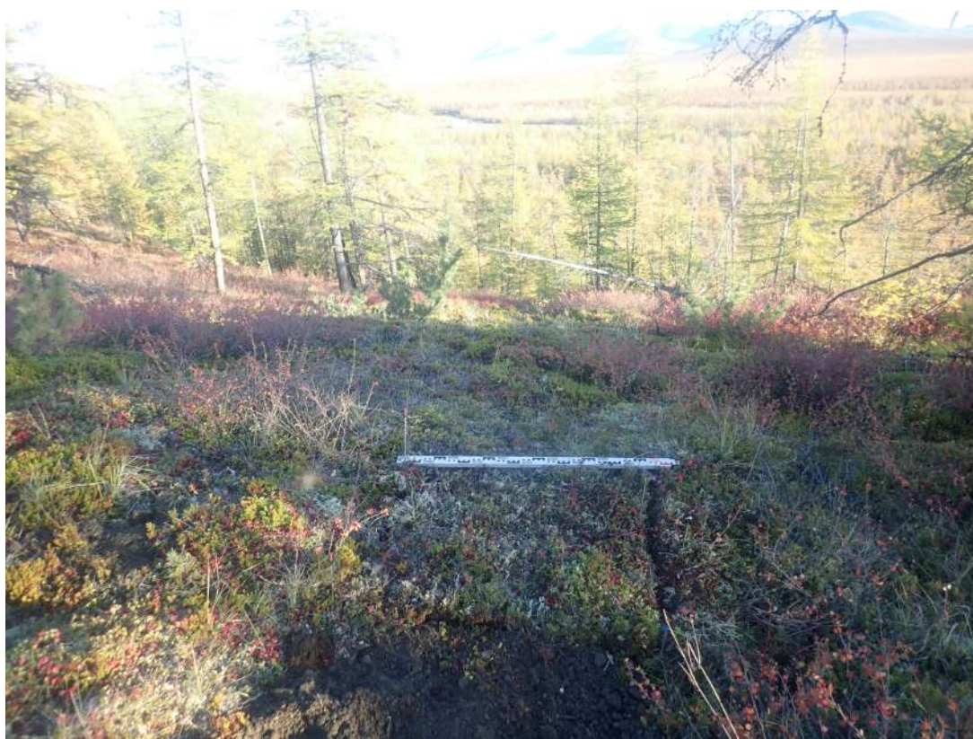
Рис. 293. СВАЭ-2022. Чукотский АО. Электроснабжение Баимского ГОК. ВЛ 330 кВ ПП Билибино-Баимский ГОК №2. Рекультивация шурфа 6. Вид с севера.
