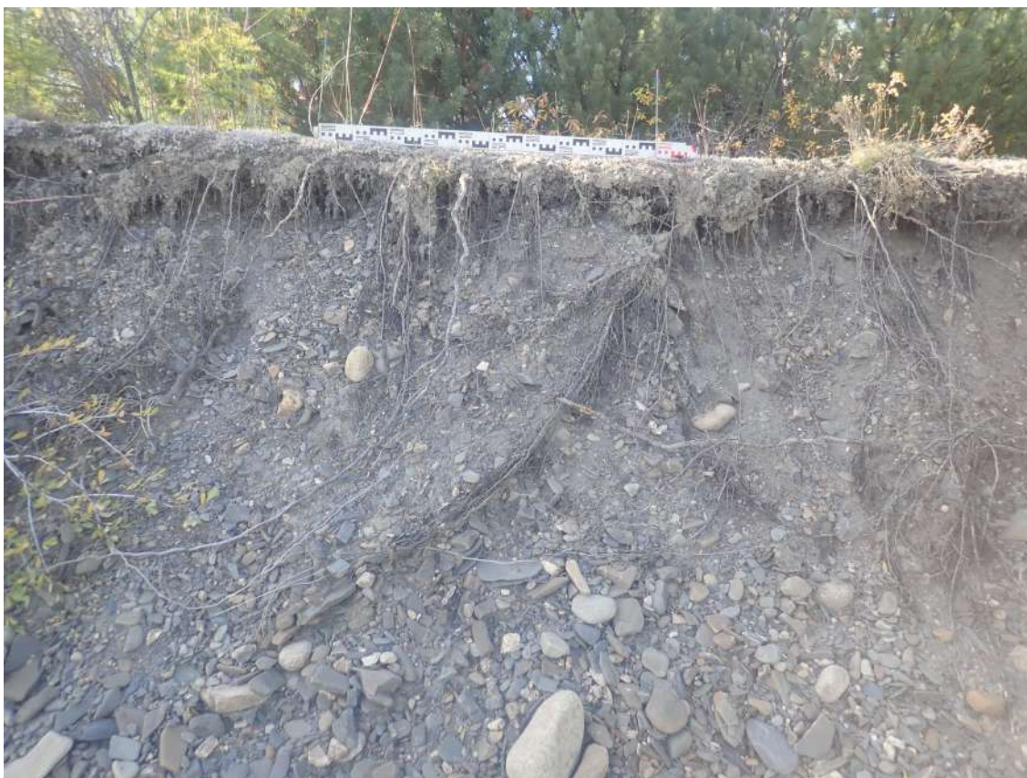
Рис. 382. СВАЭ-2022. Чукотский АО. Электроснабжение Баимского ГОК. ВЛ 330 кВ ПП Билибино-Баимский ГОК №2. Место расположения зачистки 32. Вид с севера.
