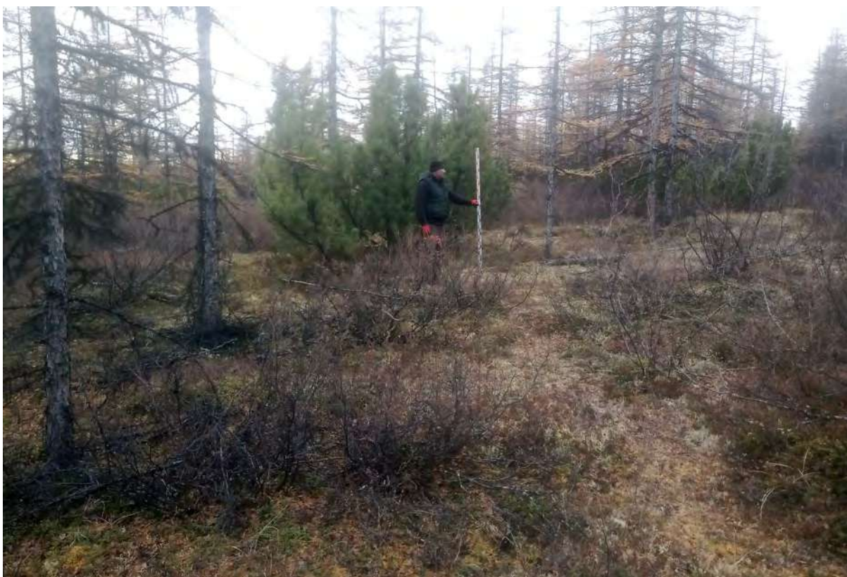
Рис. 130а. СВАЭ-2022. Чукотский АО. Электроснабжение Баимского ГОК. ВЛ 330 кВ ПП Билибино-Баимский ГОК №2. ТФ 110 на участке 4. Типичный ландшафт на хребте между г. Анупа и Анюйским хребтом в створе трассы. Вид с запада.
