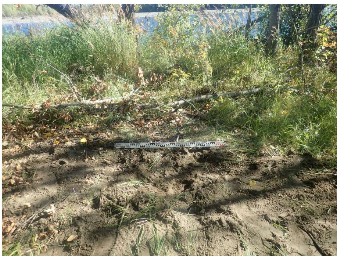
Рис. 529. СВАЭ-2022. Чукотский АО. Электроснабжение Баимского ГОК. ВЛ 330 кВ ПП Билибино-Баимский ГОК №2. Рекультивация шурфа 72. Вид с севера.
