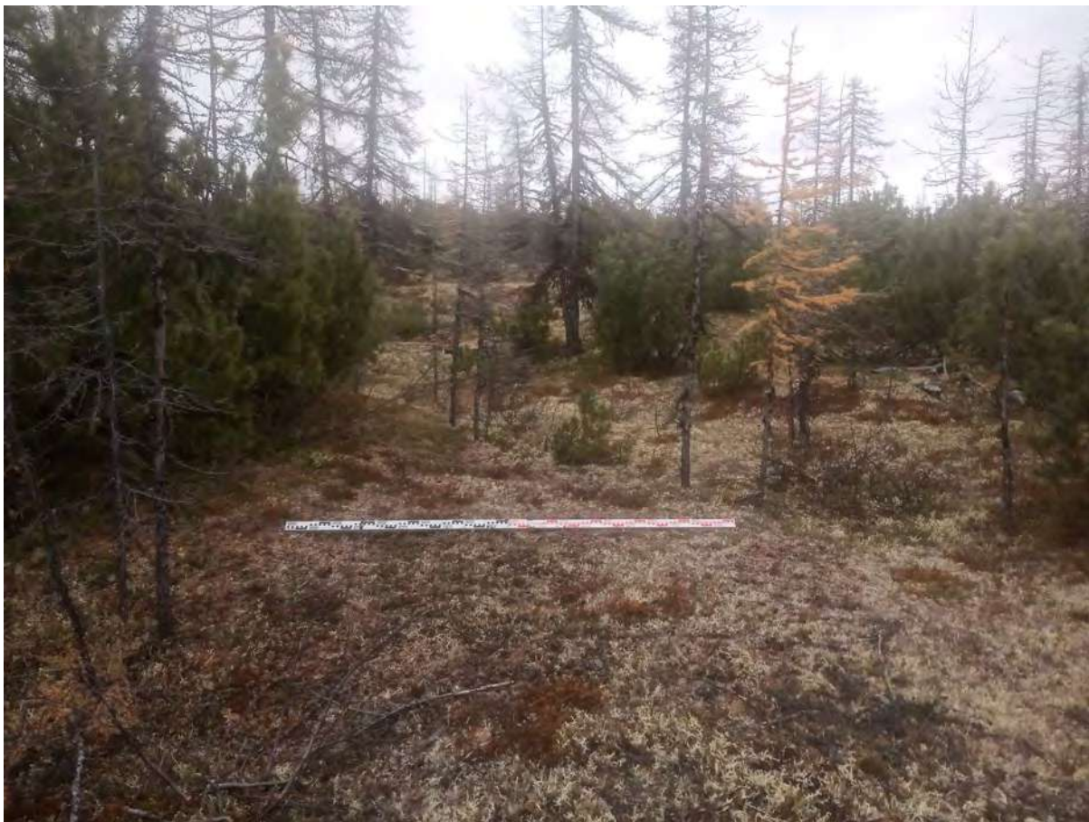
Рис. 158. СВАЭ-2022. Чукотский АО. Электроснабжение Баймского ГОК. ВЛ 330 кВ ПП Билибино-Баймский ГОК №2. ТФ 138 на участке 5. Буровая скважина ЦГЭИ на Анюйском хребте в створе. Вид с юго-запада.
