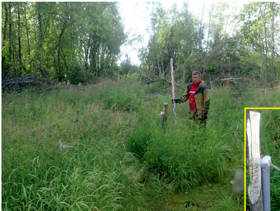
Рис. 254. СВАЭ-2022. Чукотский АО. Электроснабжение Баимского ГОК. ВЛ 330 кВ ПП Билибино-Баимский ГОК №2. ТФ 233 на участке 7. Буровая скважина Геотех в низкой пойме Малого Анюя в створе трассы. Вид с востока.
