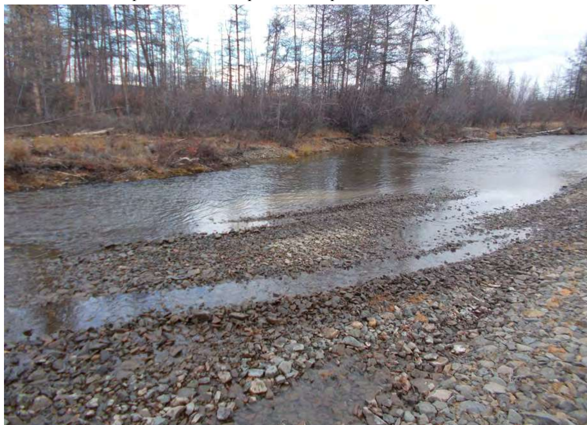
Рис. 176. СВАЭ-2022. Чукотский АО. Электроснабжение Баимского ГОК. ВЛ 330 кВ ПП Билибино-Баимский ГОК №1». ТФ 154 на участке 5. Переход ручья Поперечный в створе. Вид с севера.
