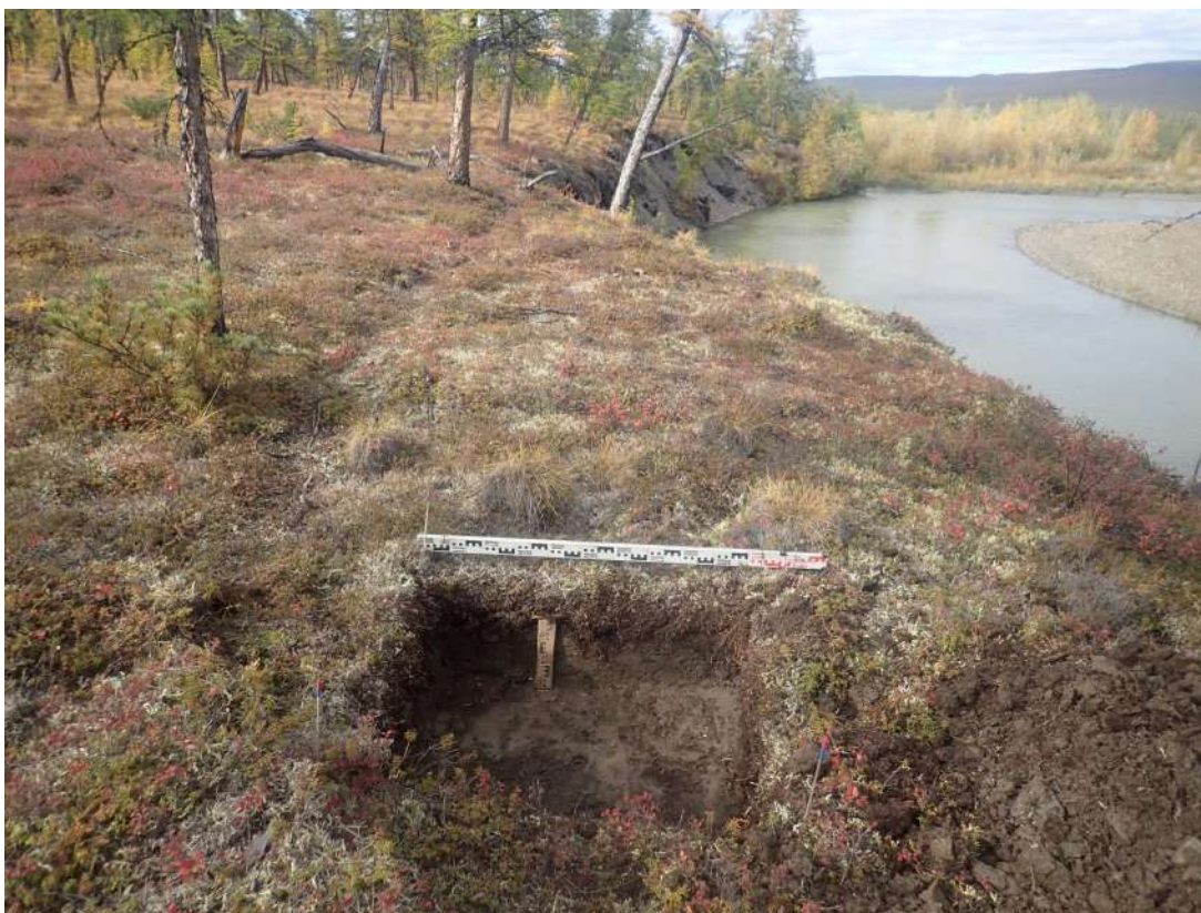
Рис. 341. СВАЭ-2022. Чукотский АО. Электроснабжение Баимского ГОК. ВЛ 330 кВ ПП Билибино-Баимский ГОК №2. Шурф 21 после вскрытия. Вид с запада.
