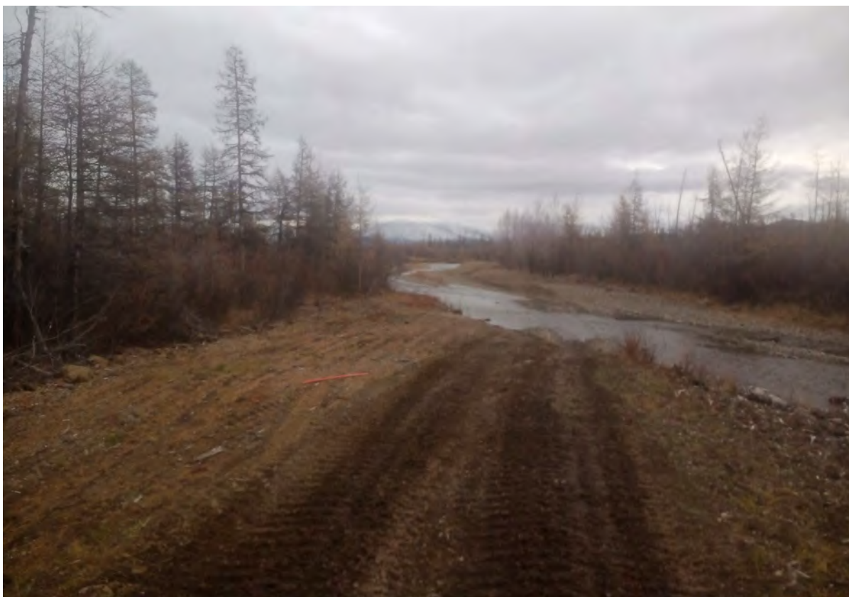
Рис. 160. СВАЭ-2022. Чукотский АО. Электроснабжение Баимского ГОК. ВЛ 330 кВ ПП Билибино-Баимский ГОК №2. ТФ 140 на участке 5. Зимник через Анюйский хребет в створе. Вид с севера.
