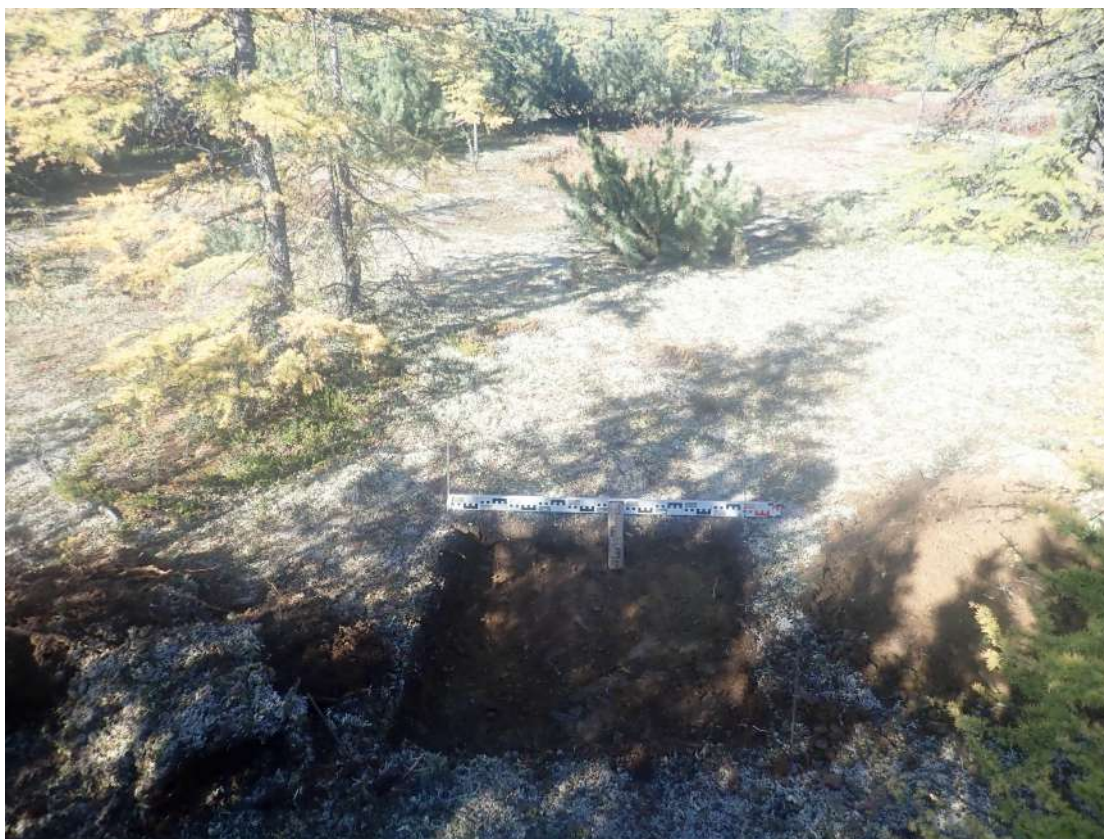
Рис. 443. СВАЭ-2022. Чукотский АО. Электроснабжение Баимского ГОК. ВЛ 330 кВ ПП Билибино-Баимский ГОК №2. Шурф 49 после вскрытия. Вид с востока.
