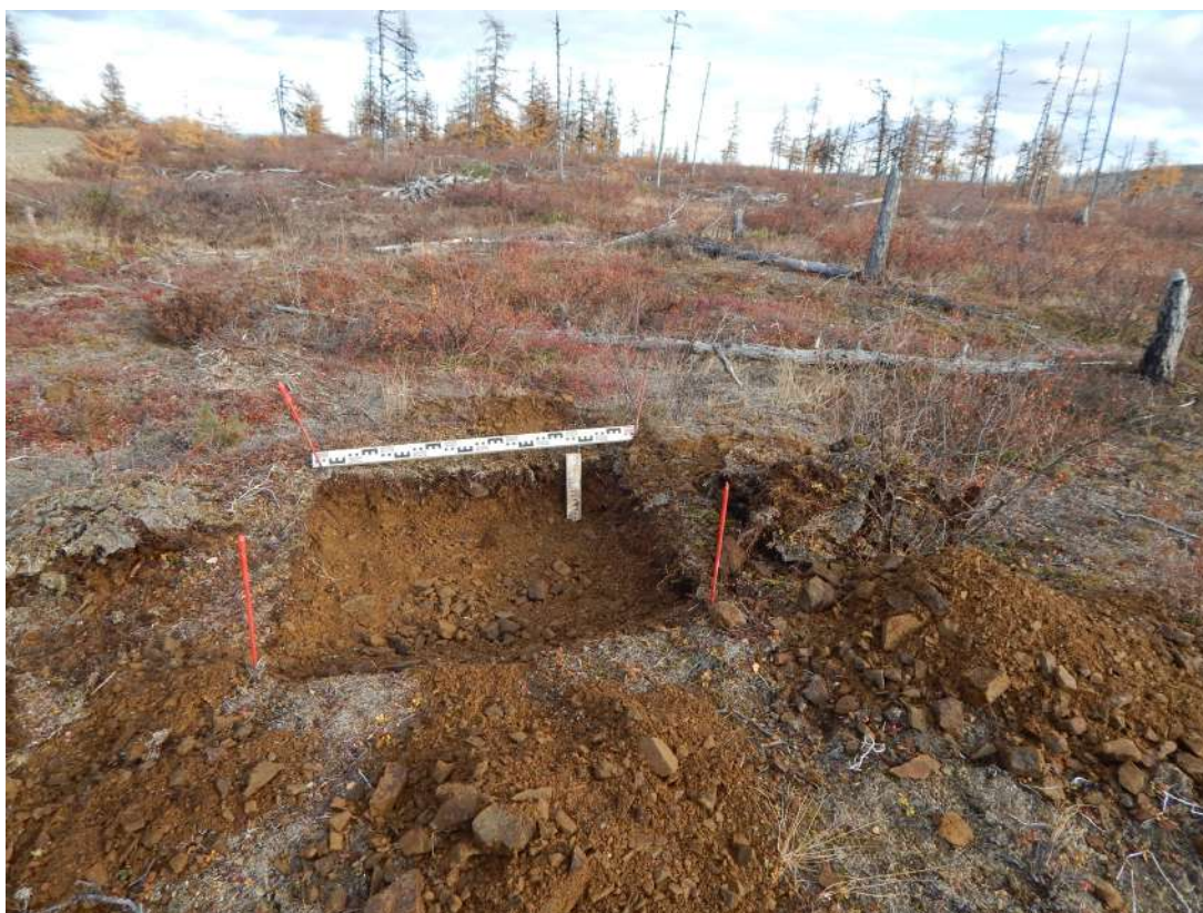
Рис. 287. СВАЭ-2022. Чукотский АО. Электроснабжение Баимского ГОК. ВЛ 330 кВ ПП Билибино-Баимский ГОК №2. Шурф 5 после вскрытия. Вид с запада.
