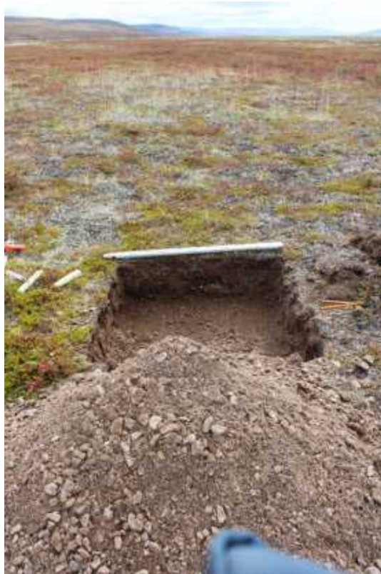
Рис. 438. Чаунский район ЧАО. Проектируемая трасса автодороги, район км.728. Долина р. Малый Мильгывеем. Площадка строительных грунтовых материалов. Западная стенка шурфа №79. Вид с В.
