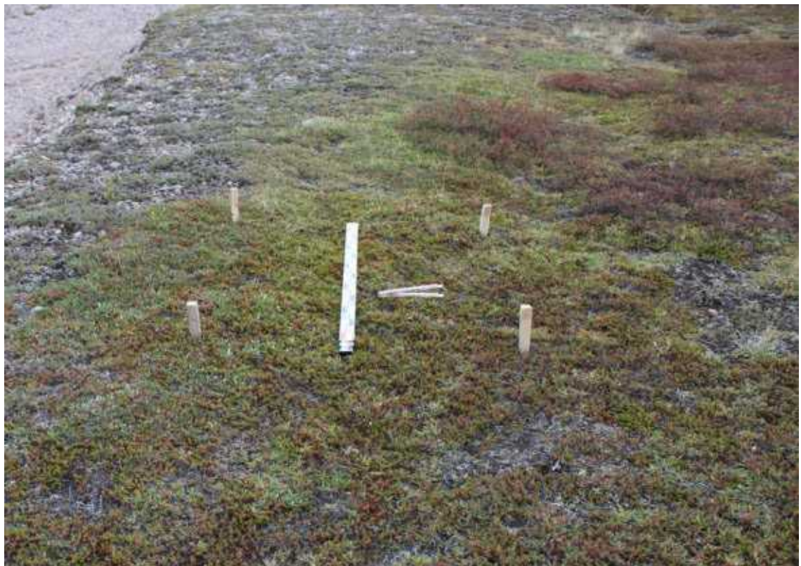
Рис. 87. Чаунский район ЧАО. Участок проектируемой трассы автодороги, район км.820. Левый берег ручья Латиф, Закладка шурфа №13. Вид с З.
