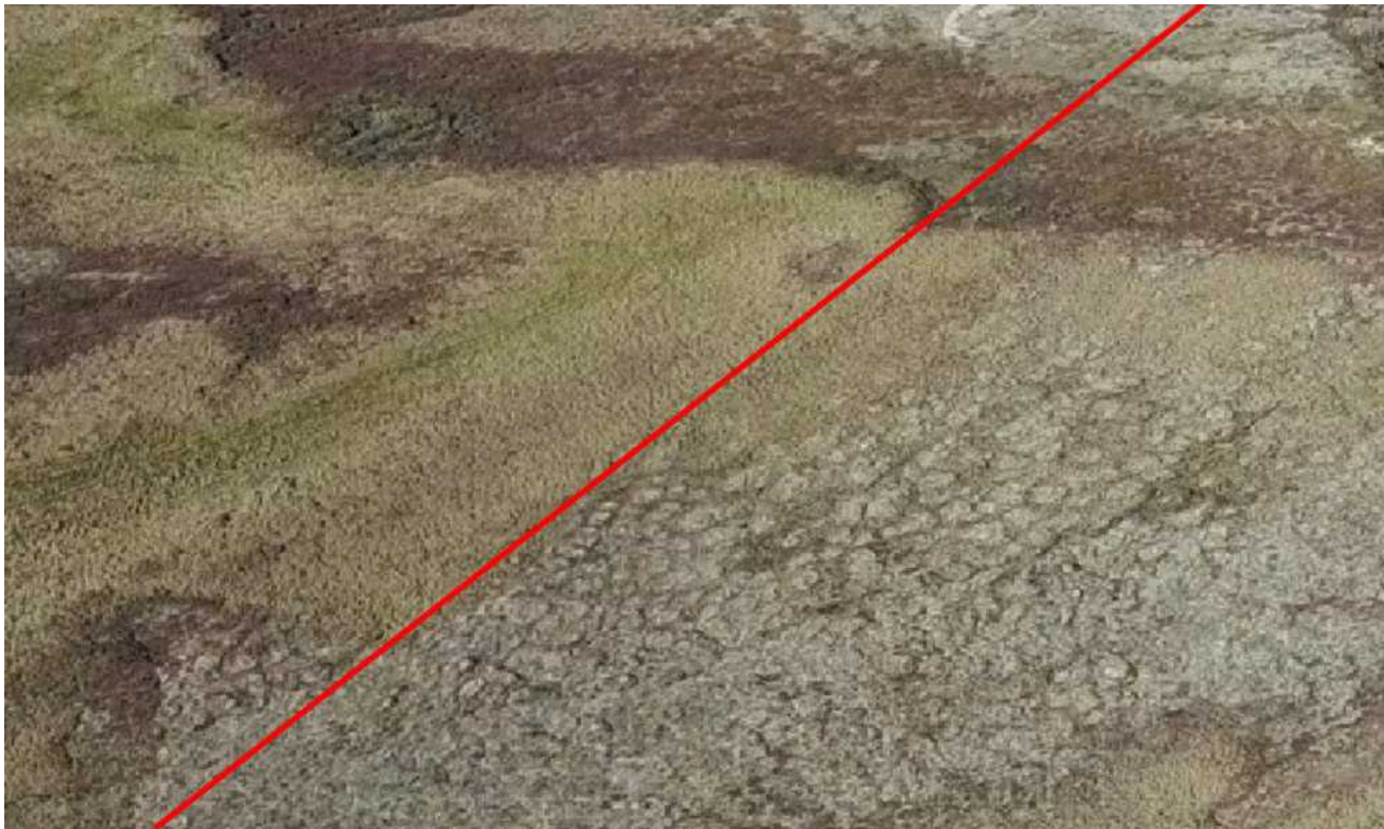
Рис. 12. Чаунский район ЧАО. Проектируемая трасса автодороги Колыма-Омсукчан-Омолон-Анадырь. Правый берег р. Левтуттуутвеем. Конечный отрезок. Вид сверху, с Ю.
