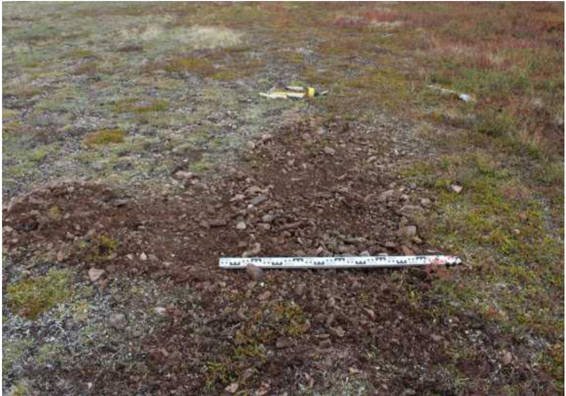
Рис. 436. Чаунский район ЧАО. Проектируемая трасса автодороги, район км.728. Долина р. Малый Мильгывеем. Площадка строительных грунтовых материалов. Рекультивация шурфа №78. Вид с В.
