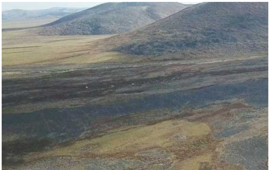
Рис. 18. Чаунский район ЧАО. Начальный участок обследования проектируемой трассы автодороги. Карьер строительных материалов на СЗ склоне г. Светлая. Вид с ЮЮЗ.
