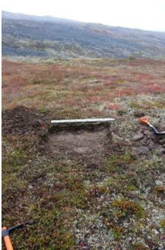
Рис. 195. Чаунский район ЧАО. Проектируемая трасса автодороги район км. 774-км.773. Левый борт р.Эльпычкыкин. Восточная стенка шурфа №33. Вид с З.
