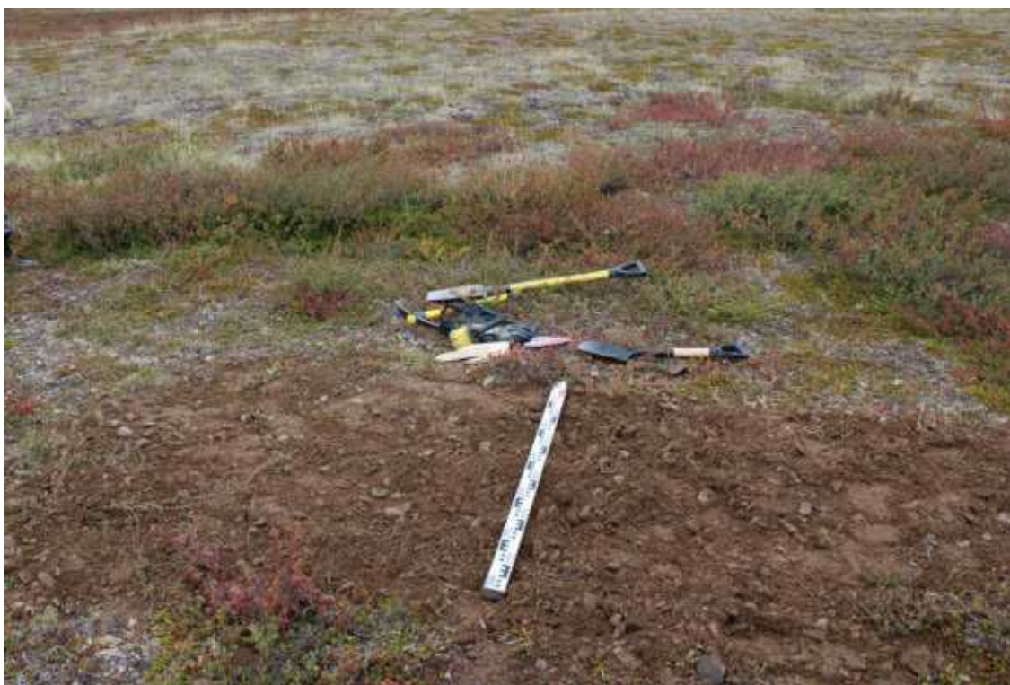
Рис. 458. Чаунский район ЧАО. Проектируемая трасса автодороги, район км.732. Долина р. Малый Мильгывеем. Место расположения резервного карьера строительных материалов. Рекультивация шурфа №82. Вид с В.
