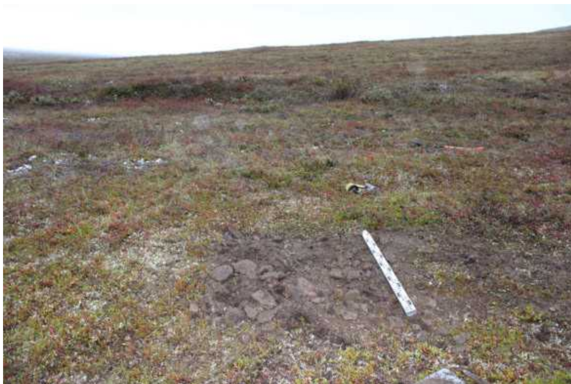
Рис. 208. Чаунский район ЧАО. Проектируемая трасса автодороги район км.773-км.772. Выход в долину р. Эльгыкаквын. Южный подъём на гряде. Рекультивация шурфа №37. Вид с Ю.
