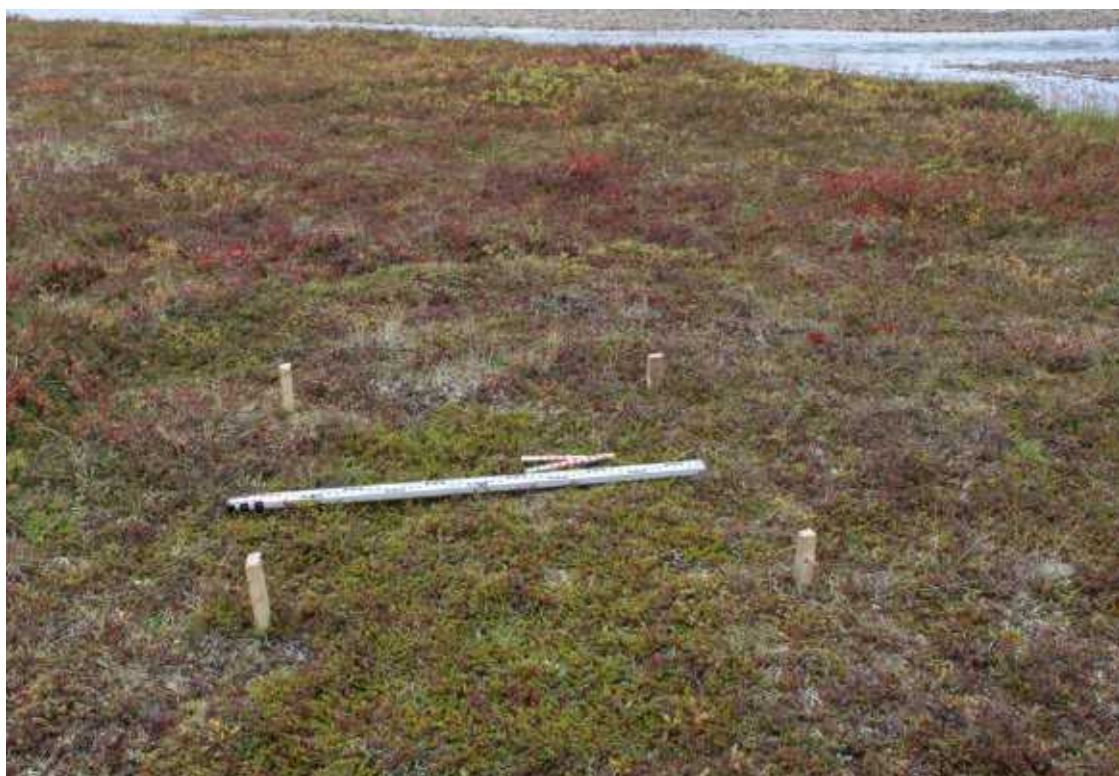
Рис. 285. Чаунский район ЧАО. Проектируемая трасса автодороги. Правый берег р.Завитая. Закладка шурфа №58. Вид с В.
