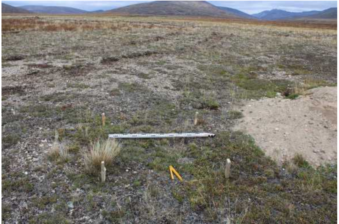
Рис. 218. Чаунский район ЧАО. Проектируемая трасса автодороги район км.771. Закладка шурфа №41. Вид с Ю.
