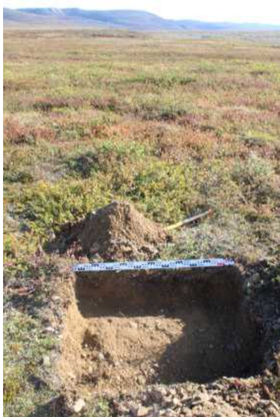
Рис. 100. Чаунский район ЧАО. Участок проектируемой трассы автодороги, район км.816. Долина р. Левтуттуувем, приустьевый участок ручья Смуглый. Южная стенка шурфа №17. Вид с С.
