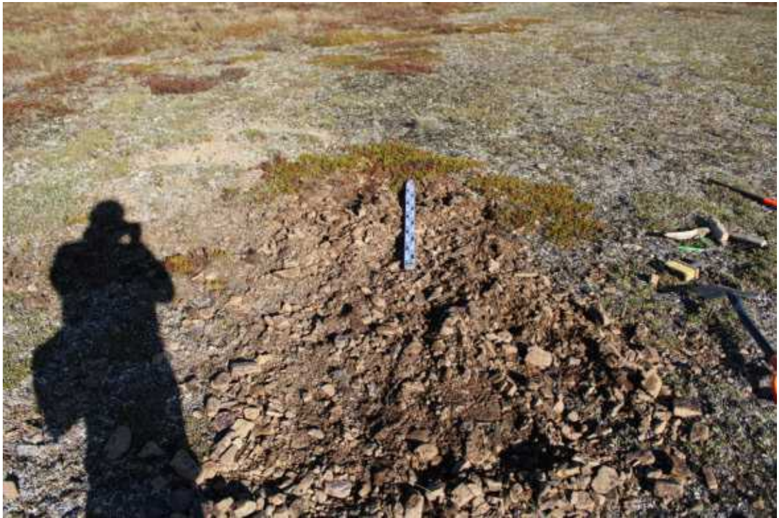
Рис. 86. Чаунский район ЧАО. Участок проектируемой трассы автодороги, район км.820. Долина ручья Латиф, Правый борт. Рекультивация шурфа №12. Вид с З.
