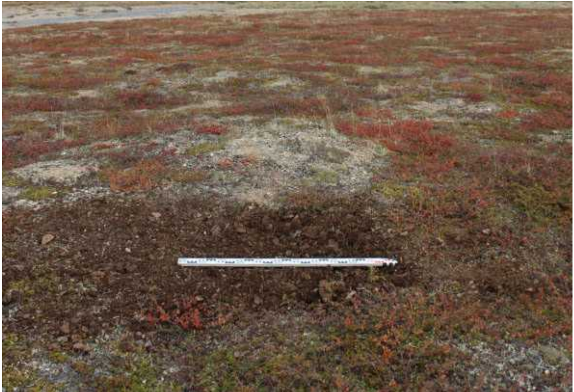
Рис. 242. Чаунский район ЧАО. Проектируемая трасса автодороги. Левый берег р.Эльгыкаквын в месте перехода. Рекультивация шурфа №44. Вид с Ю.
