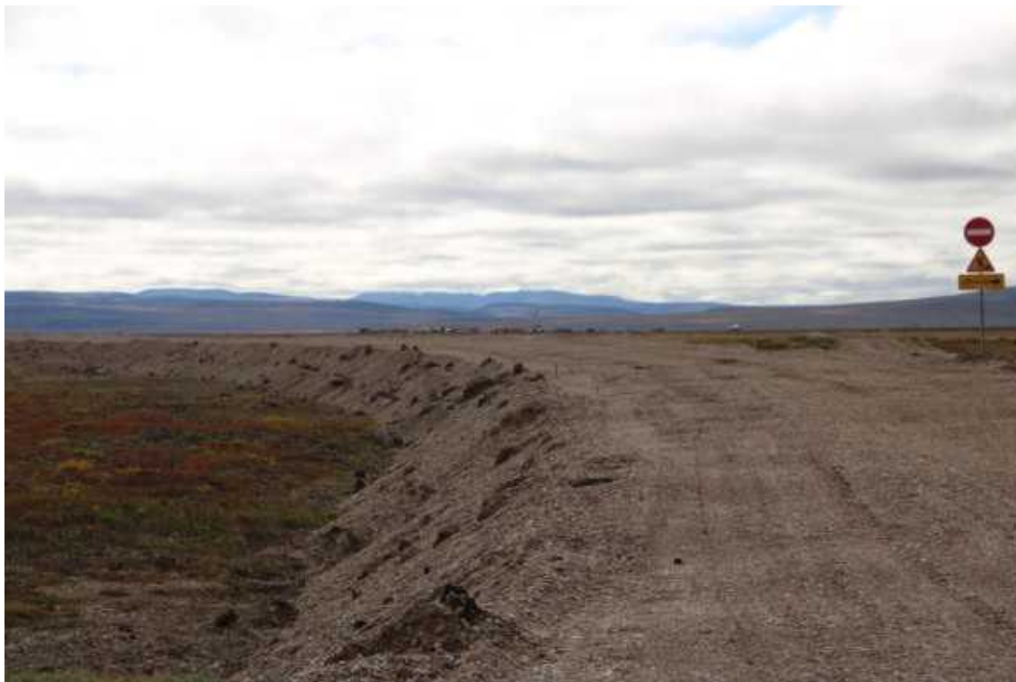
Рис. 414. Чаунский район ЧАО. Проектируемая трасса автодороги, район км.723+618. Долина реки Мыльгывеем. Дальний план - база изыскателей; строителей мостового перехода. Вид с ССВ.
