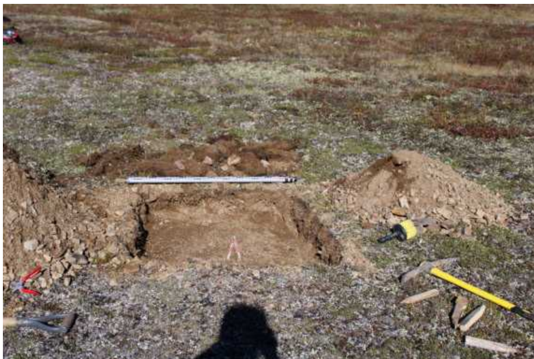
Рис. 27. Чаунский район ЧАО. Начальный участок обследования проектируемой трассы автодороги, район км.822. Долина реки Левтуттуутвеем. Северная стенка шурфа №4. Вид с Ю.
