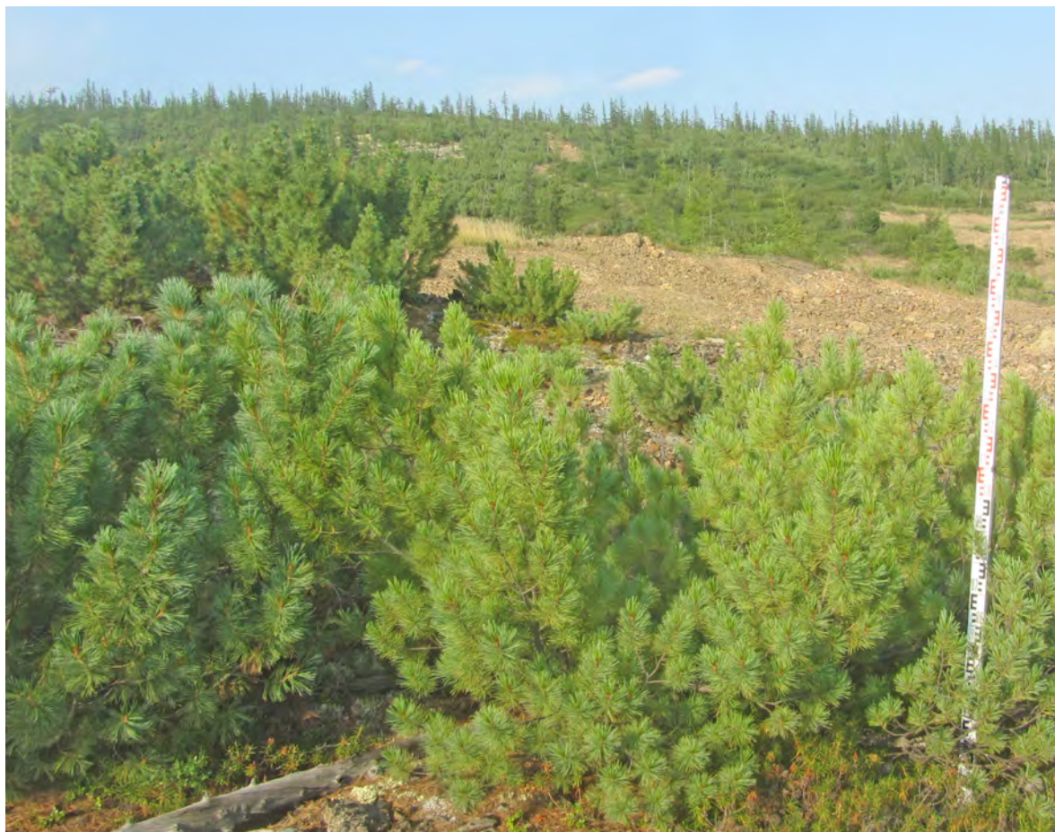
Рис. 394. СВАЭ-2022. Чукотский АО. Строительство автомобильной дороги от Баимского ГОКа до г. Билибино. Карьеры ОПИ. Участок 26. ТФ 235. Отвалы коренной породы в западной части площадки карьера. Вид с юга.
