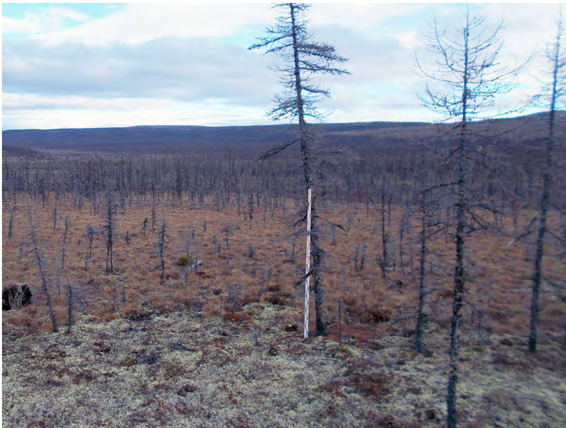
Рис. 509. СВАЭ-2022. Чукотский АО. Строительство автомобильной дороги от Баимского ГОКа до г. Билибино. Карьеры ОПИ. Участок 35. ТФ 316. Граница ландшафтов на склоне сопки в северной части площадки карьера в восточной части площадки карьера. Вид с востока.
