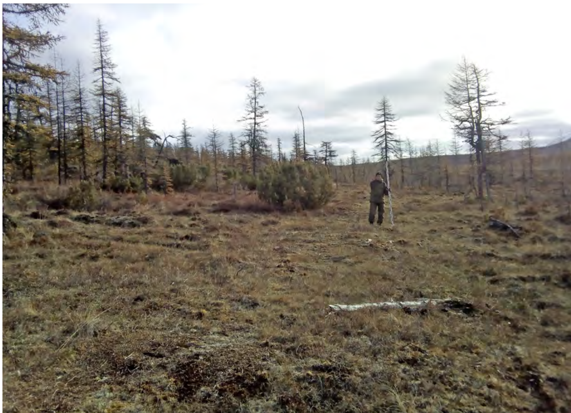
Рис. 29. СВАЭ-2022. Чукотский АО. Строительство автомобильной дороги от Баимского ГОКа до г. Билибино. Карьеры ОПИ. Участок 2. ТФ 16. Очищенная от растительности площадка на западном склоне г. Круглая в западной части площадки карьера. Вид с севера.
