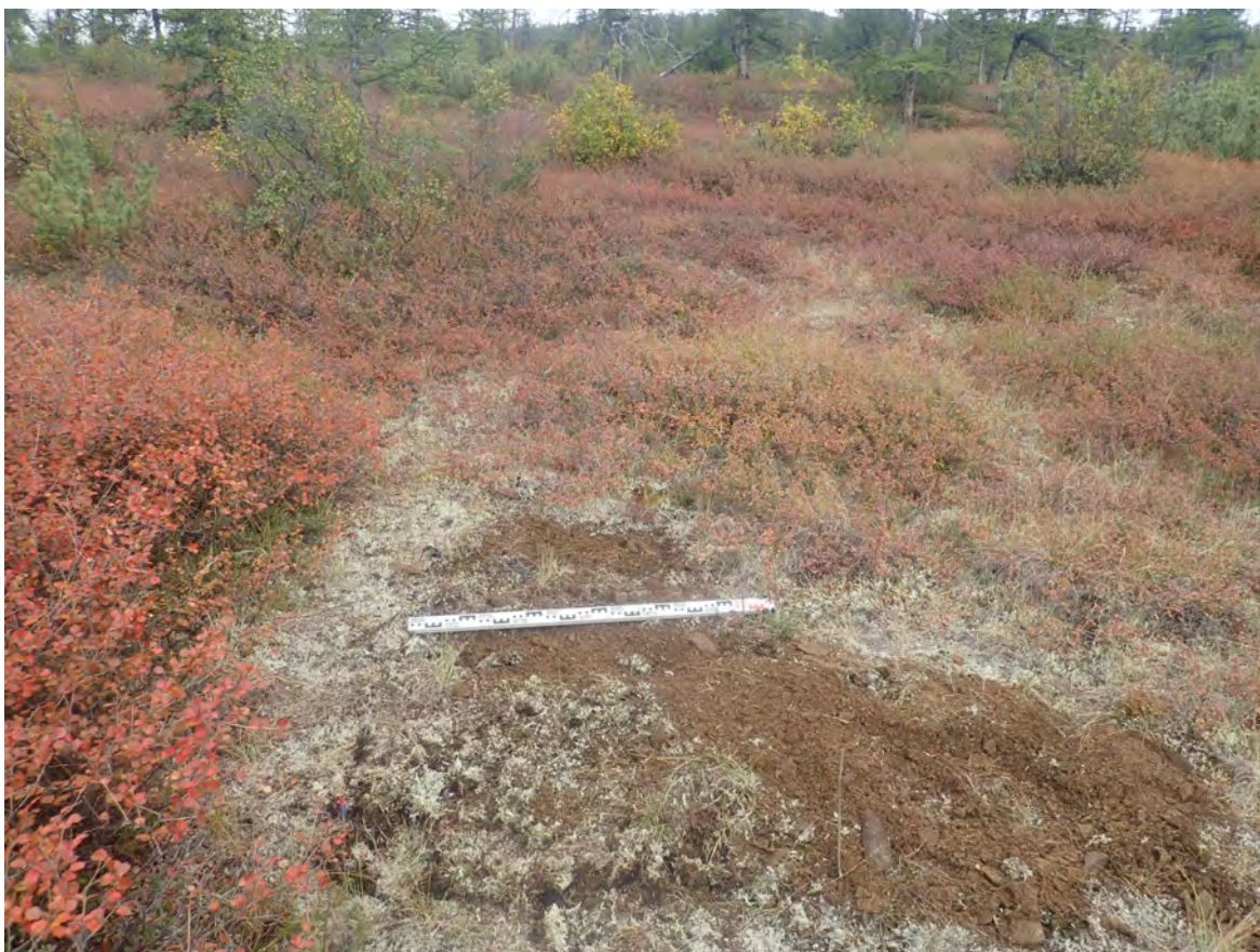
Рис. 495. СВАЭ-2022. Чукотский АО. Строительство автомобильной дороги от Баимского ГОКа до г. Билибино. Карьеры ОПИ. Участок 34. Рекультивация шурфа № 32. Вид с востока.
