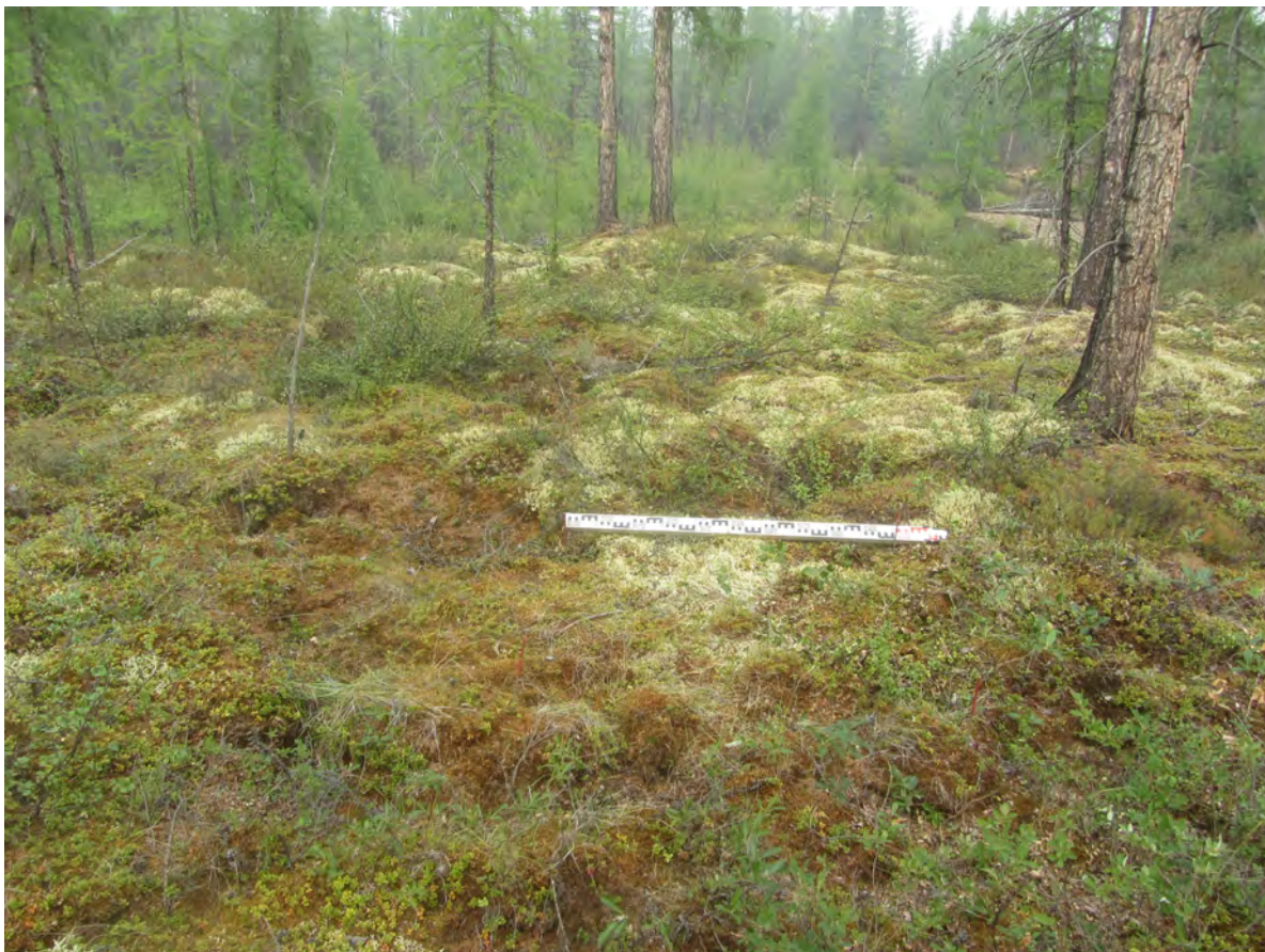
Рис. 104. СВАЭ-2022. Чукотский АО. Строительство автомобильной дороги от Баимского ГОКа до г. Билибино. Карьеры ОПИ. Участок 6. Шурф № 8 до начала работ. Вид с юга.
