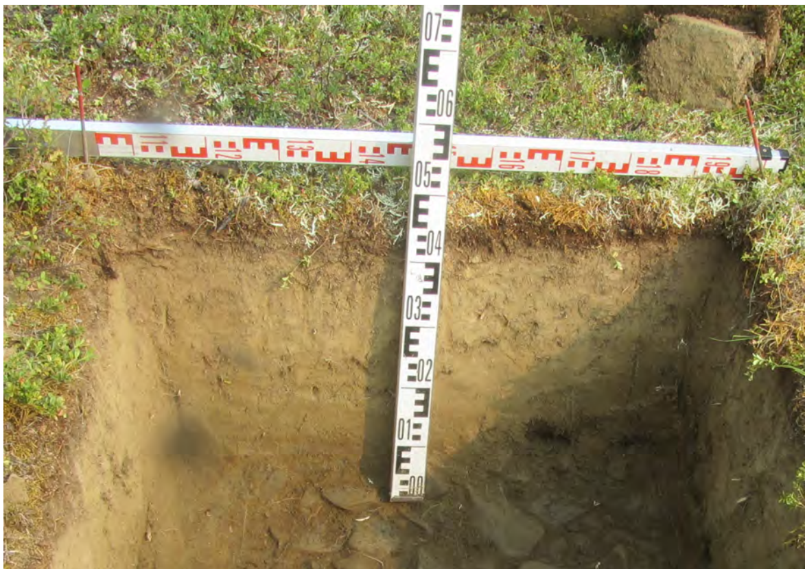
Рис. 70. СВАЭ-2022. Чукотский АО. Строительство автомобильной дороги от Баимского ГОКа до г. Билибино. Карьеры ОПИ. Участок 4. Борт шурфа № 5. Вид с юга.
