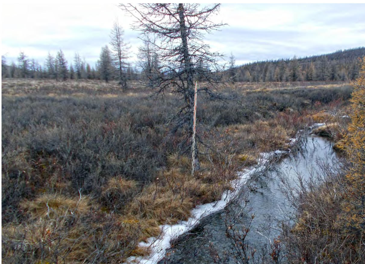
Рис. 201. СВАЭ-2022. Чукотский АО. Строительство автомобильной дороги от Баимского ГОКа до г. Билибино. Карьеры ОПИ. Участок 14-1. ТФ 114. Русло безымянного левого притока р. Уямканда в южной части площадки карьера. Вид с северо-востока.
