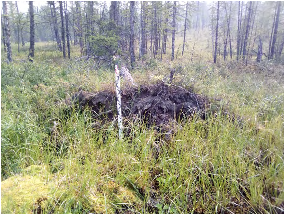
Рис. 80. СВАЭ-2022. Чукотский АО. Строительство автомобильной дороги от Баимского ГОКа до г. Билибино. Карьеры ОПИ. Участок 5. ТФ 43. Характер почв в вывороте в восточной части площадки карьера. Вид с севера.
