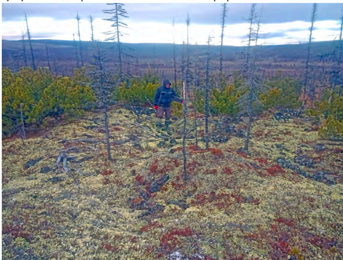
Рис. 391. СВАЭ-2022. Чукотский АО. Строительство автомобильной дороги от Баимского ГОКа до г. Билибино. Карьеры ОПИ. Участок 26. ТФ 232. Курумники южного склона сопки в южной части площадки карьера, долина р. Ургувеем на заднем плане. Вид с северо-запада.
