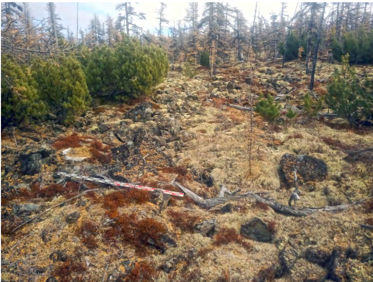
Рис. 207. СВАЭ-2022. Чукотский АО. Строительство автомобильной дороги от Баимского ГОКа до г. Билибино. Карьеры ОПИ. Участок 14-1. ТФ 120. Выходы коренных пород в северной части площадки карьера. Вид с востока.
