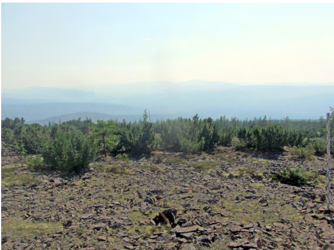
Рис. 428. СВАЭ-2022. Чукотский АО. Строительство автомобильной дороги от Баимского ГОКа до г. Билибино. Карьеры ОПИ. Участок 28. ТФ 257. Курумники в северной части площадки карьера. Вид с запада.
