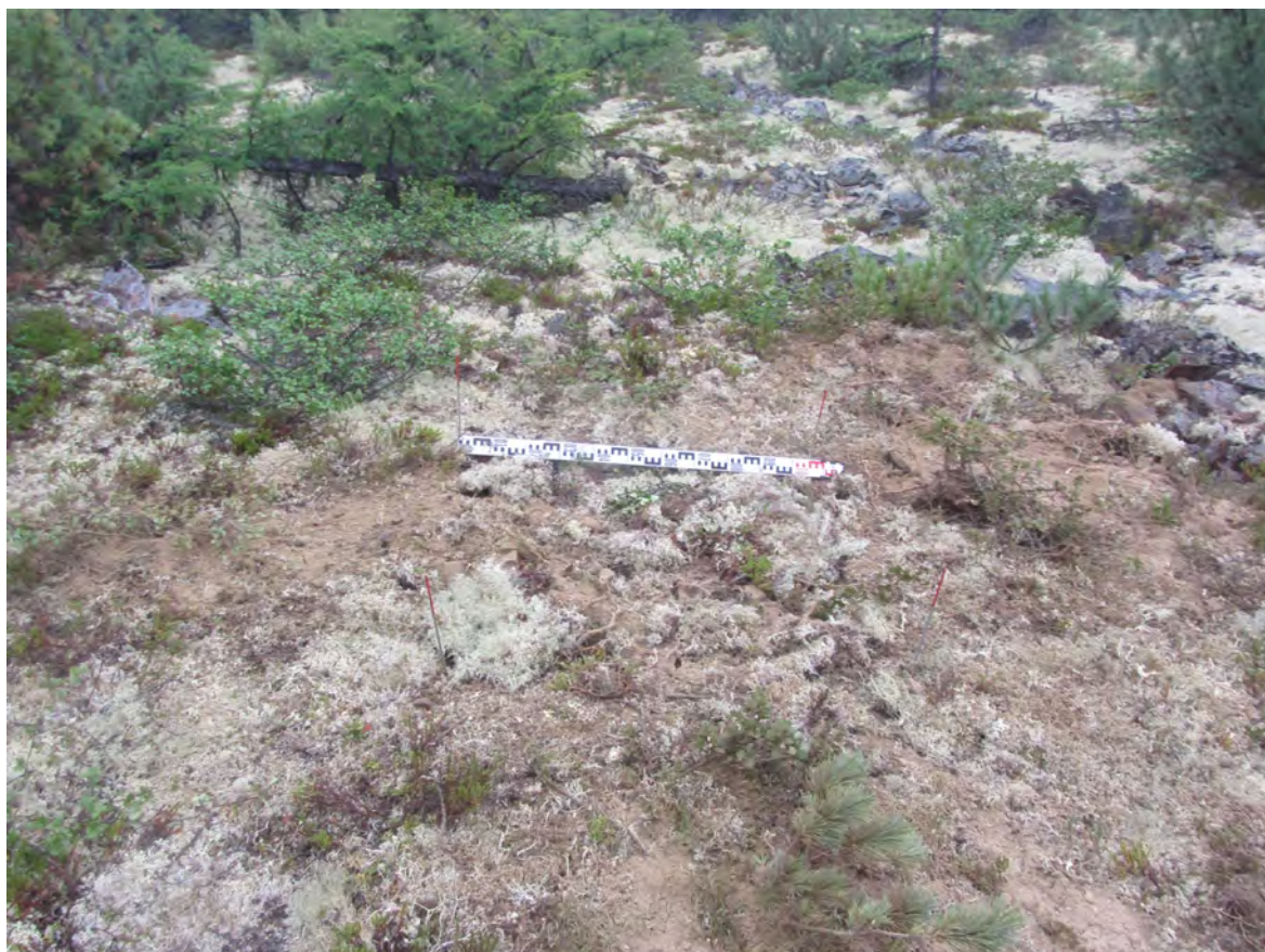
Рис. 387. СВАЭ-2022. Чукотский АО. Строительство автомобильной дороги от Баимского ГОКа до г. Билибино. Карьеры ОПИ. Участок 25. Рекультивация шурфа № 27. Вид с востока.
