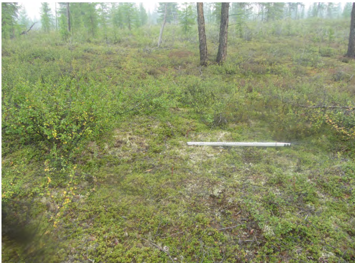
Рис. 210. СВАЭ-2022. Чукотский АО. Строительство автомобильной дороги от Баймского ГОКа до г. Билибино. Карьеры ОПИ. Участок 14-1. Шурф № 16 до начала работ. Вид с востока.
