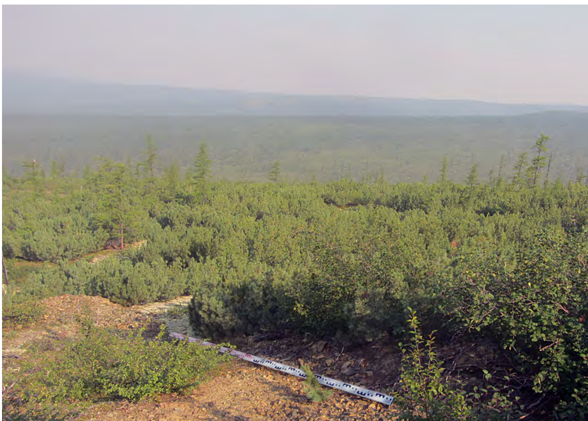
Рис. 521. СВАЭ-2022. Чукотский АО. Строительство автомобильной дороги от Баимского ГОКа до г. Билибино. Карьеры ОПИ. Участок 36. ТФ 322. Горно-тундровый ландшафт на курумниках в восточной части площадки карьера. Вид с запада.
