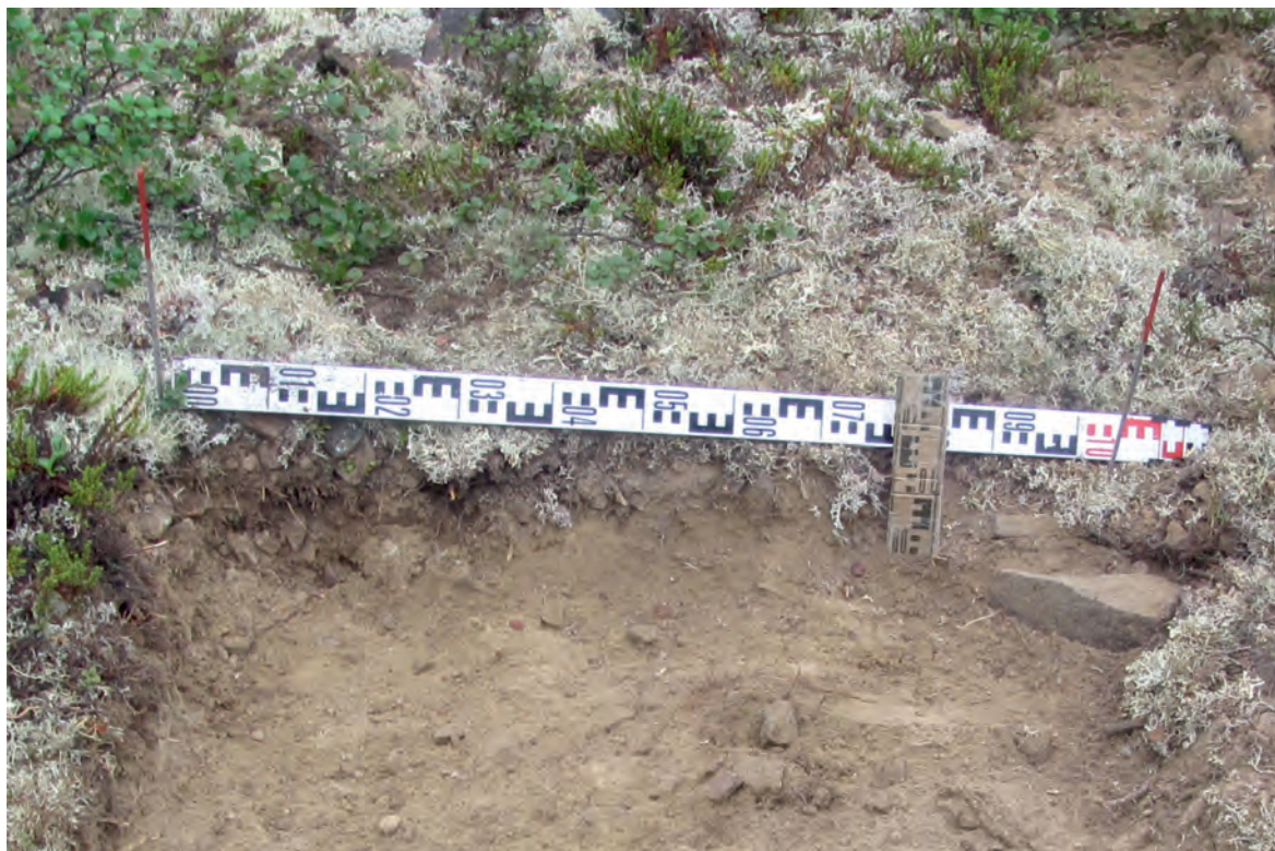
Рис. 386. СВАЭ-2022. Чукотский АО. Строительство автомобильной дороги от Баимского ГОКа до г. Билибино. Карьеры ОПИ. Участок 25. Борт шурфа № 27. Вид с востока.
