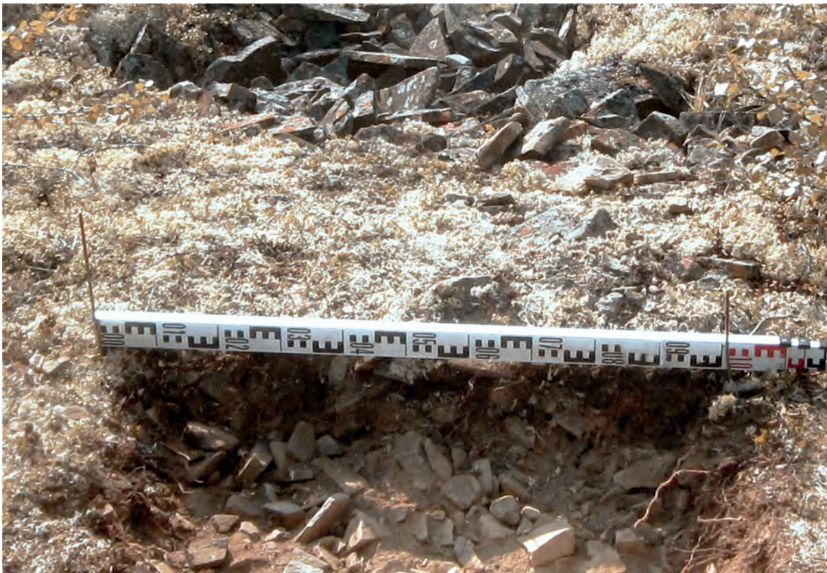
Рис. 554. СВАЭ-2022. Чукотский АО. Строительство автомобильной дороги от Баимского ГОКа до г. Билибино. Карьеры ОПИ. Участок 37. Борт шурфа № 35 до начала работ. Вид с севера.
