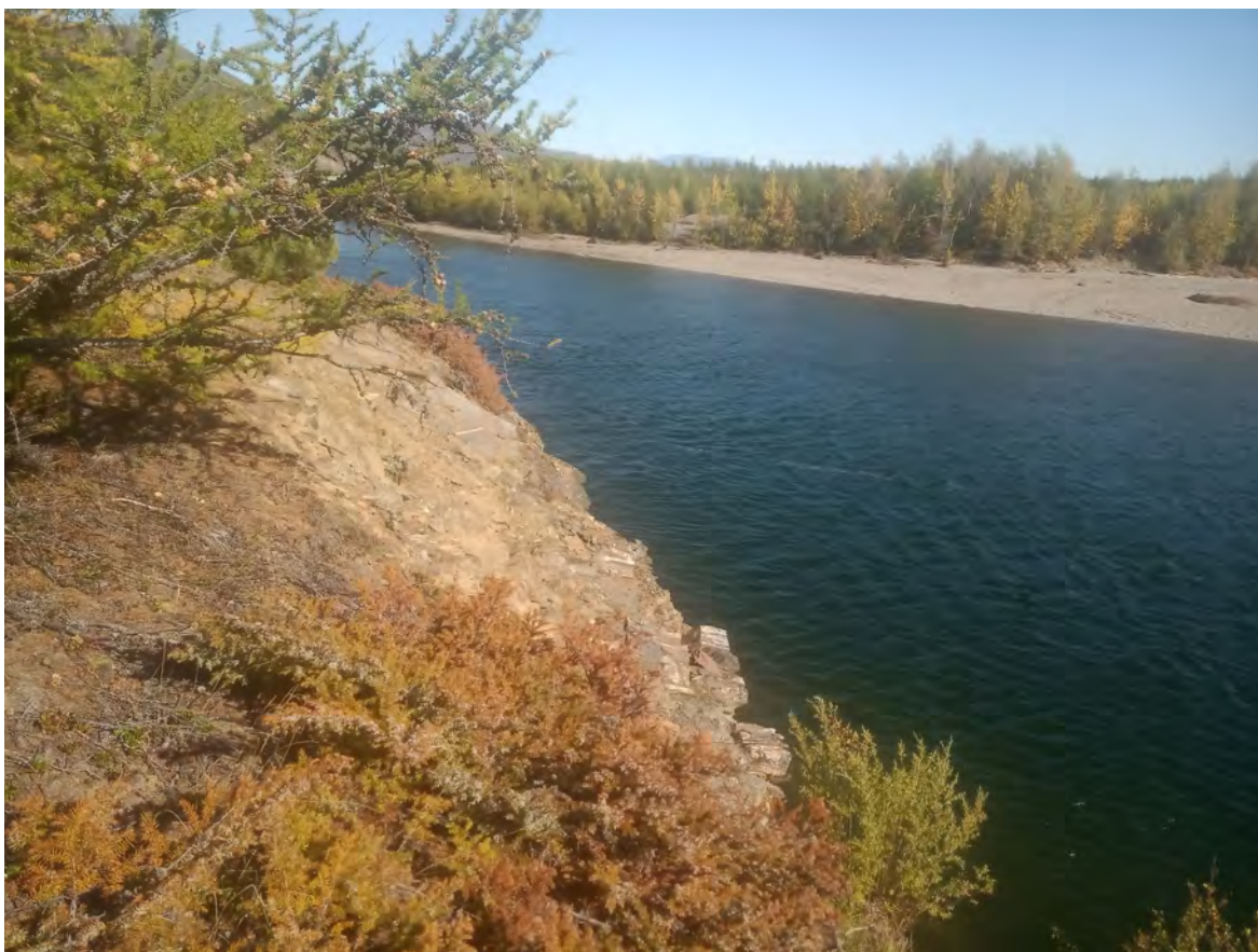
Рис. 520. СВАЭ-2022. Чукотский АО. Строительство автомобильной дороги от Баимского ГОКа до г. Билибино. Карьеры ОПИ. Участок 36. ТФ 321. Скальные выходы в юго-восточной части площадки карьера, р. Малый Анюй на заднем плане. Вид с юго-запада.
