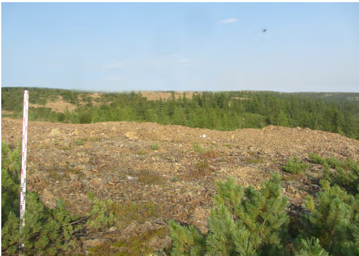
Рис. 395. СВАЭ-2022. Чукотский АО. Строительство автомобильной дороги от Баимского ГОКа до г. Билибино. Карьеры ОПИ. Участок 26. ТФ 236. Отвалы коренной породы в западной части площадки карьера. Вид с юго-запада.
