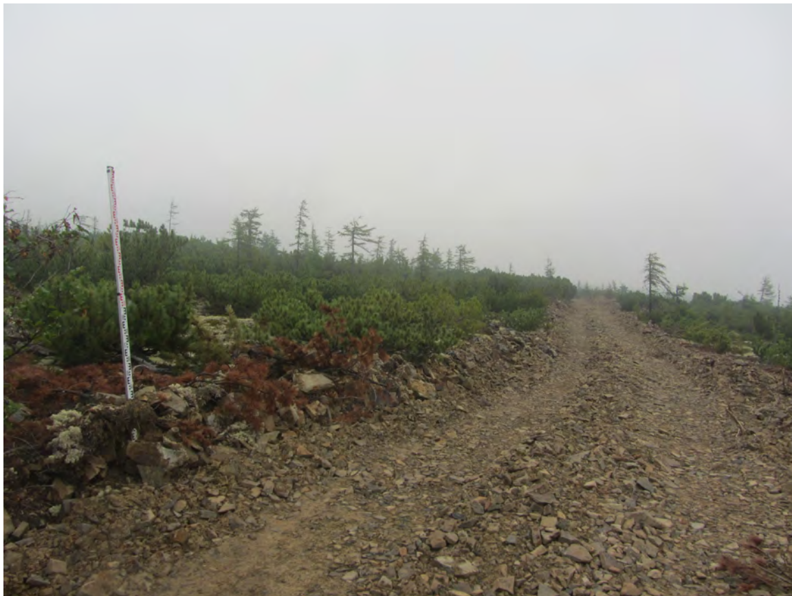
Рис. 60. СВАЭ-2022. Чукотский АО. Строительство автомобильной дороги от Баимского ГОКа до г. Билибино. Карьеры ОПИ. Участок 4. ТФ 33. Технологический проезд в восточной части площадки карьера площадке карьера. Вид с запада.
