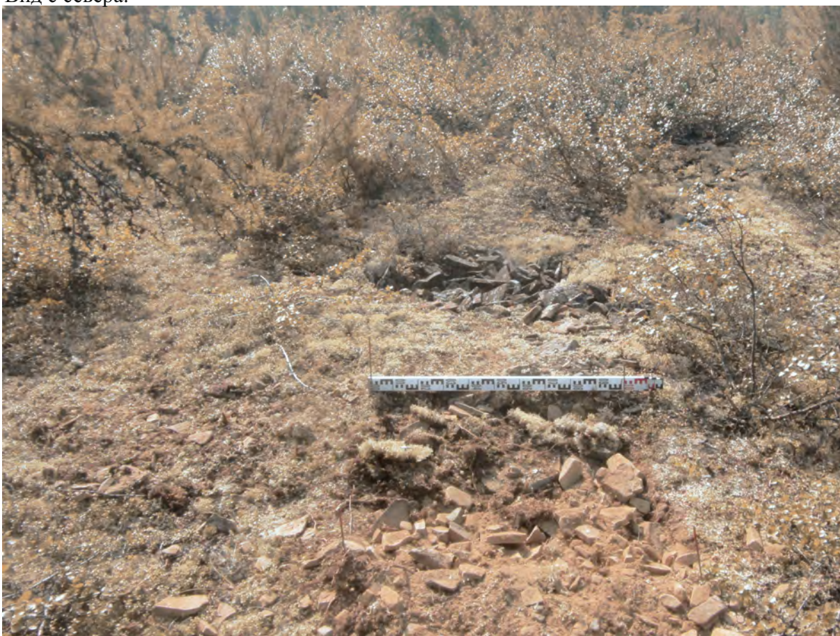
Рис. 555. СВАЭ-2022. Чукотский АО. Строительство автомобильной дороги от Баимского ГОКа до г. Билибино. Карьеры ОПИ. Участок 37. Рекультивация шурфа № 35. Вид с севера.
