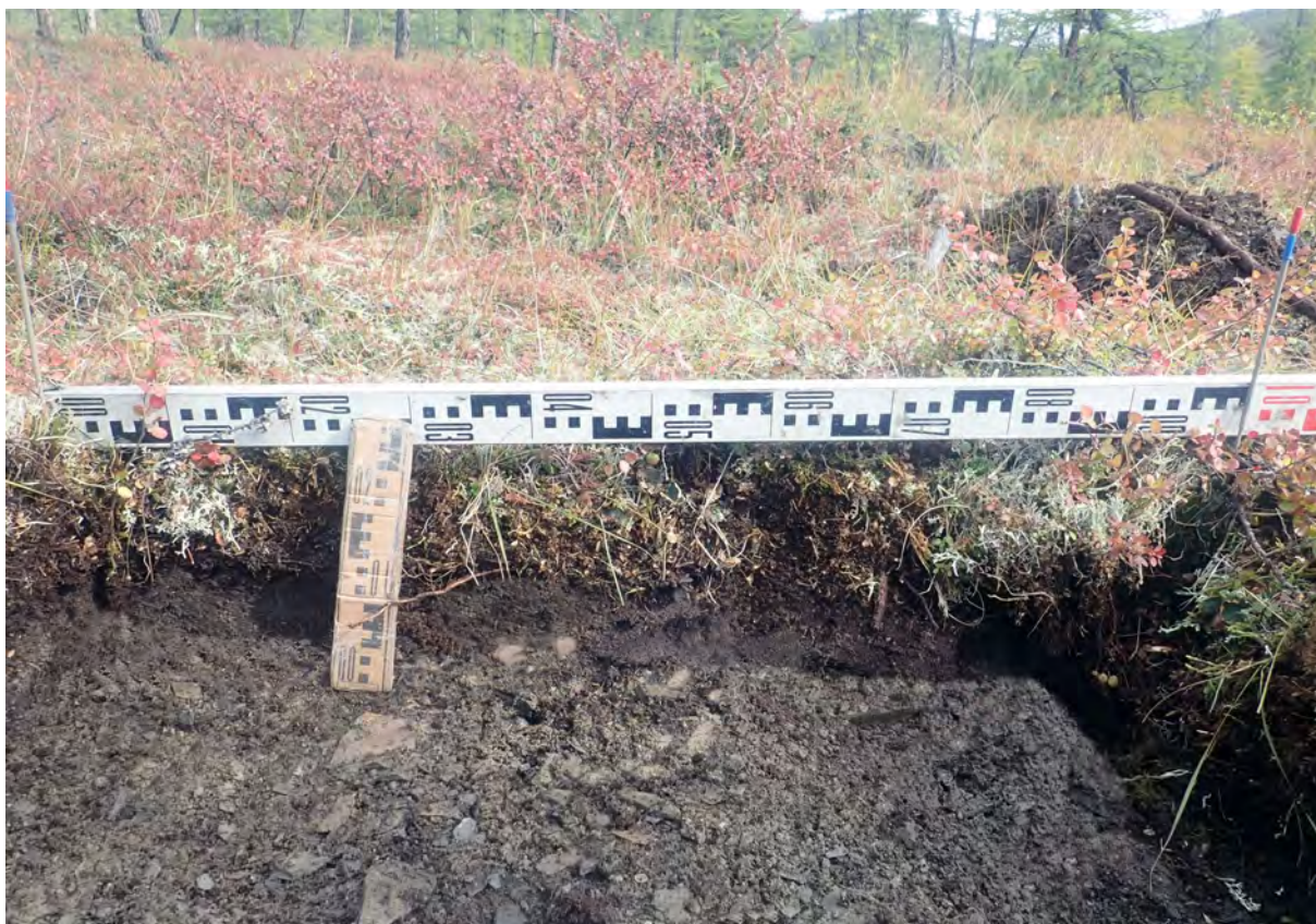
Рис. 458. СВАЭ-2022. Чукотский АО. Строительство автомобильной дороги от Баимского ГОКа до г. Билибино. Карьеры ОПИ. Участок 30-1. Борт шурфа № 30. Вид с запада.
