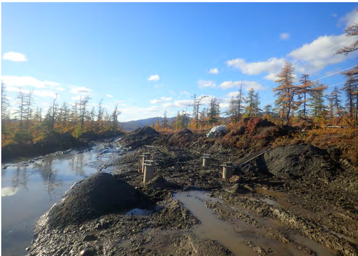
Рис. 15. СВАЭ-2022. Чукотский АО. Строительство автомобильной дороги от Баимского ГОКа до г. Билибино. Карьеры ОПИ. Участок 1. ТФ 8. Вл 110 кВ Песчанка-Билибино с отводом на Кекуру в восточной части площадки карьера. Вид с юго-запада.
