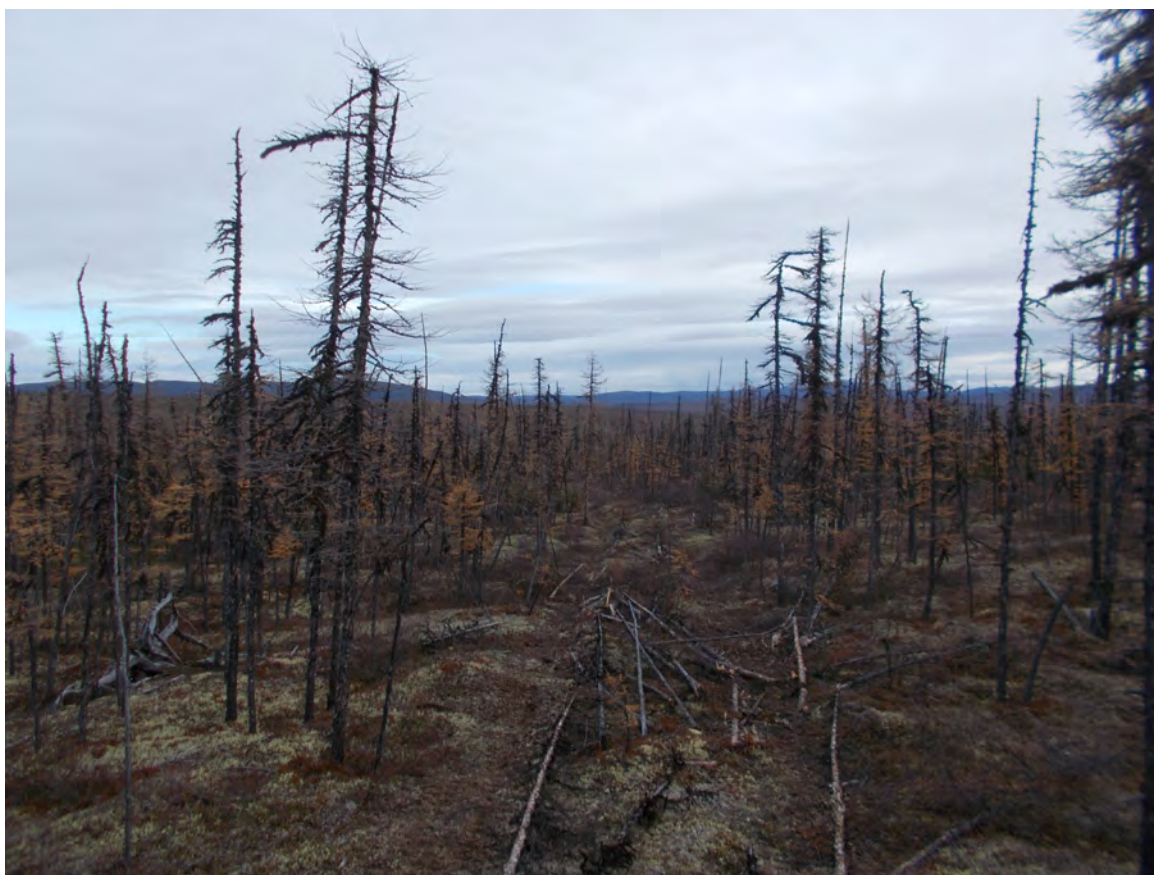
Рис. 101. СВАЭ-2022. Чукотский АО. Строительство автомобильной дороги от Баимского ГОКа до г. Билибино. Карьеры ОПИ. Участок 6. ТФ 58. Технологический проезд в центральной части площадки карьера. Вид с юга.
