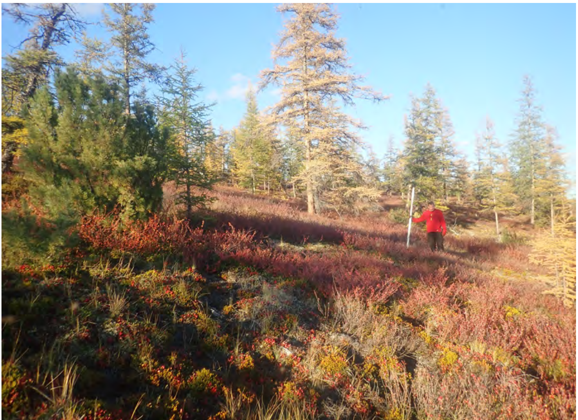
Рис. 17. СВАЭ-2022. Чукотский АО. Строительство автомобильной дороги от Баимского ГОКа до г. Билибино. Карьеры ОПИ. Участок 1. ТФ 10. Северный склон вершины 620 в центральной части площадки карьера. Вид с севера.
