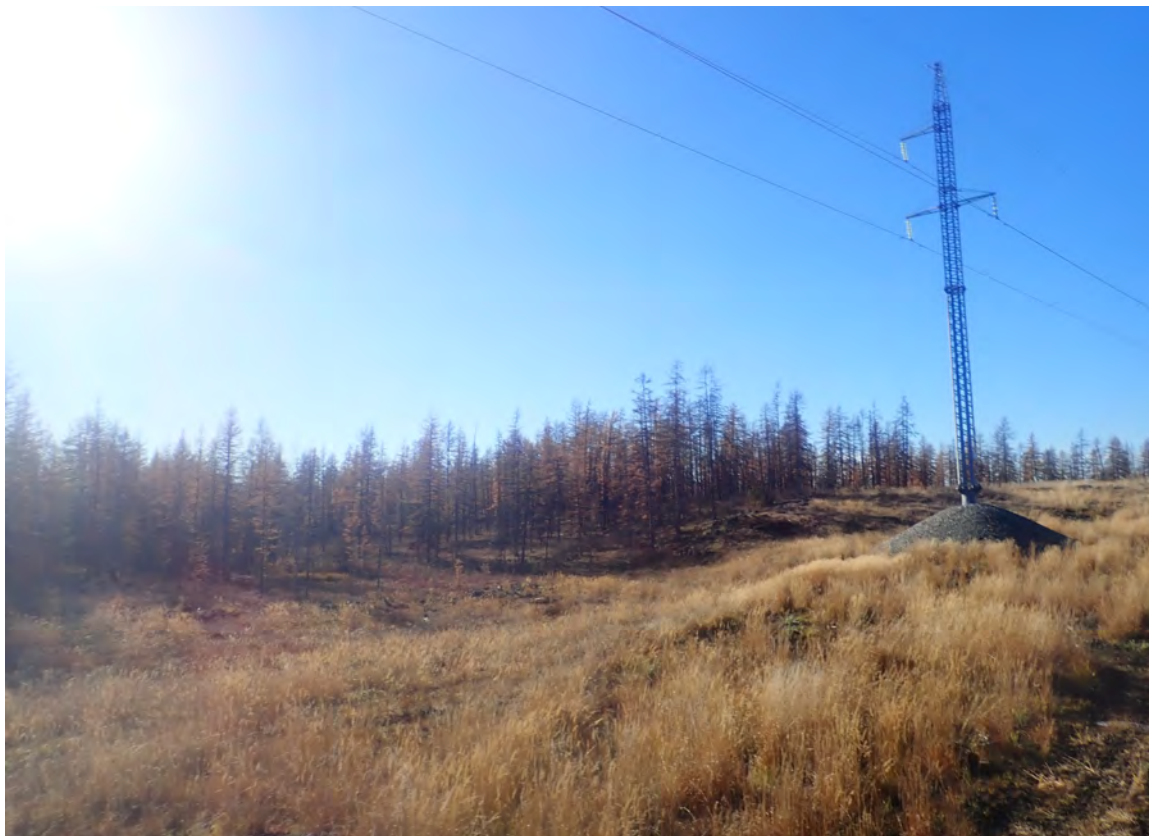
Рис. 67. СВАЭ-2022. Чукотский АО. Строительство автомобильной дороги от Баимского ГОКа до г. Билибино. Карьеры ОПИ. Участок 4. ТФ 40. Вл 110 кВ Песчанка-Билибино с отводом на Кекуру в западной части площадки карьера. Вид с юго-востока.
