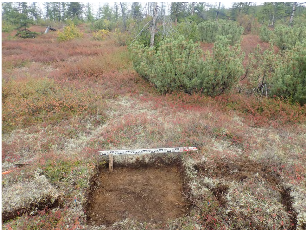
Рис. 53. СВАЭ-2022. Чукотский АО. Строительство автомобильной дороги от Баимского ГОКа до г. Билибино. Карьеры ОПИ. Участок 3-1. Шурф № 4 после вскрытия. Вид с запада.
