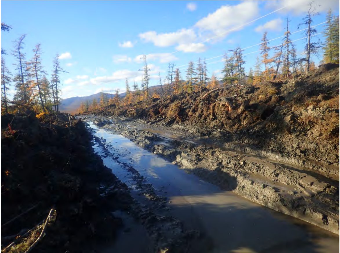
Рис. 16. СВАЭ-2022. Чукотский АО. Строительство автомобильной дороги от Баимского ГОКа до г. Билибино. Карьеры ОПИ. Участок 1. ТФ 9. Вл 110 кВ Песчанка-Билибино с отводом на Кекуру в восточной части площадки карьера. Вид с северо-востока.
