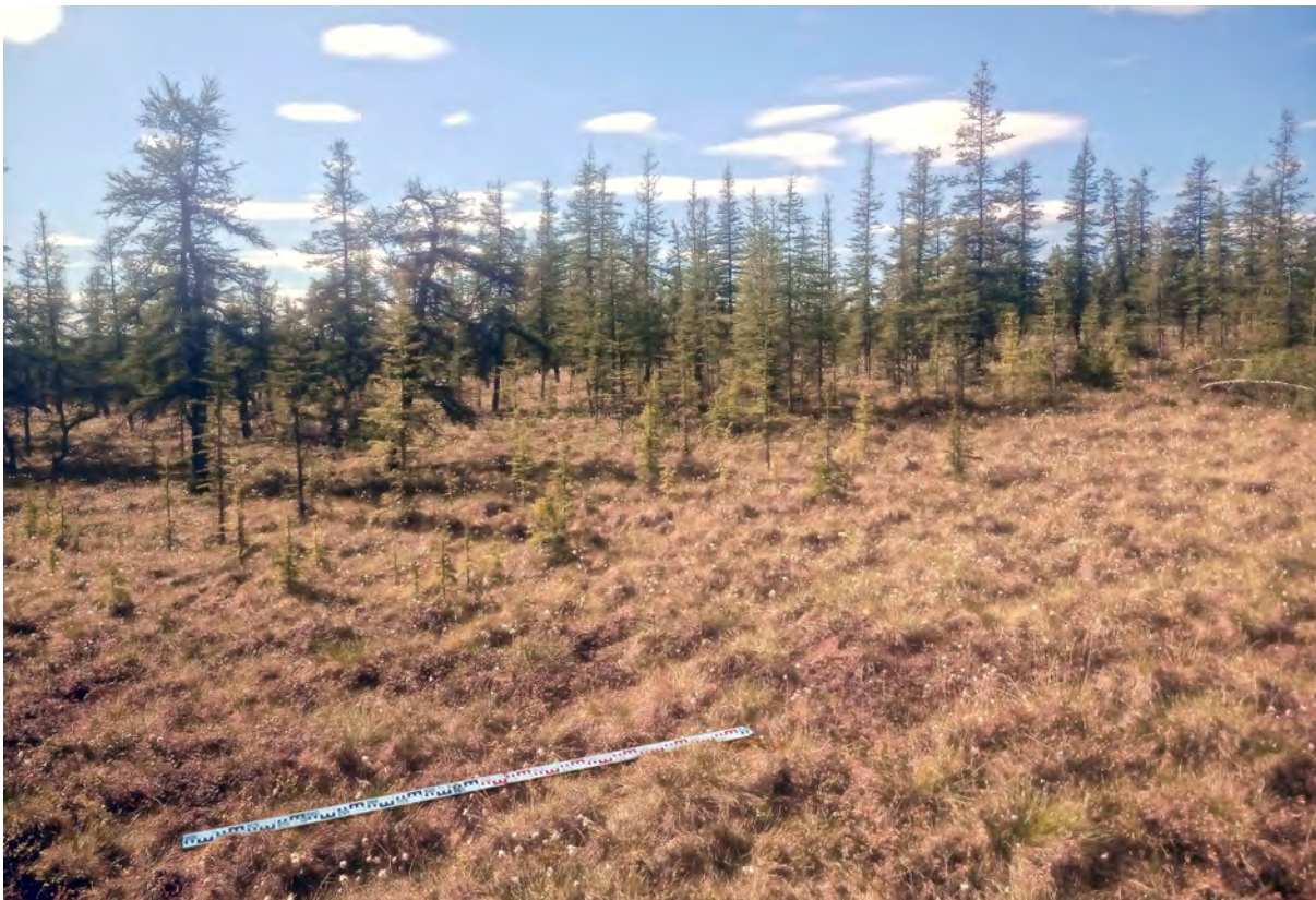
Рис. 151. СВАЭ-2022. Чукотский АО. Строительство автомобильной дороги от г. Билибино до мыса Наглёйнын. Карьеры ОПИ. Участок 45. ТФ 40. Граница высотных ярусов в южной части площадки карьера. Вид с юга.
