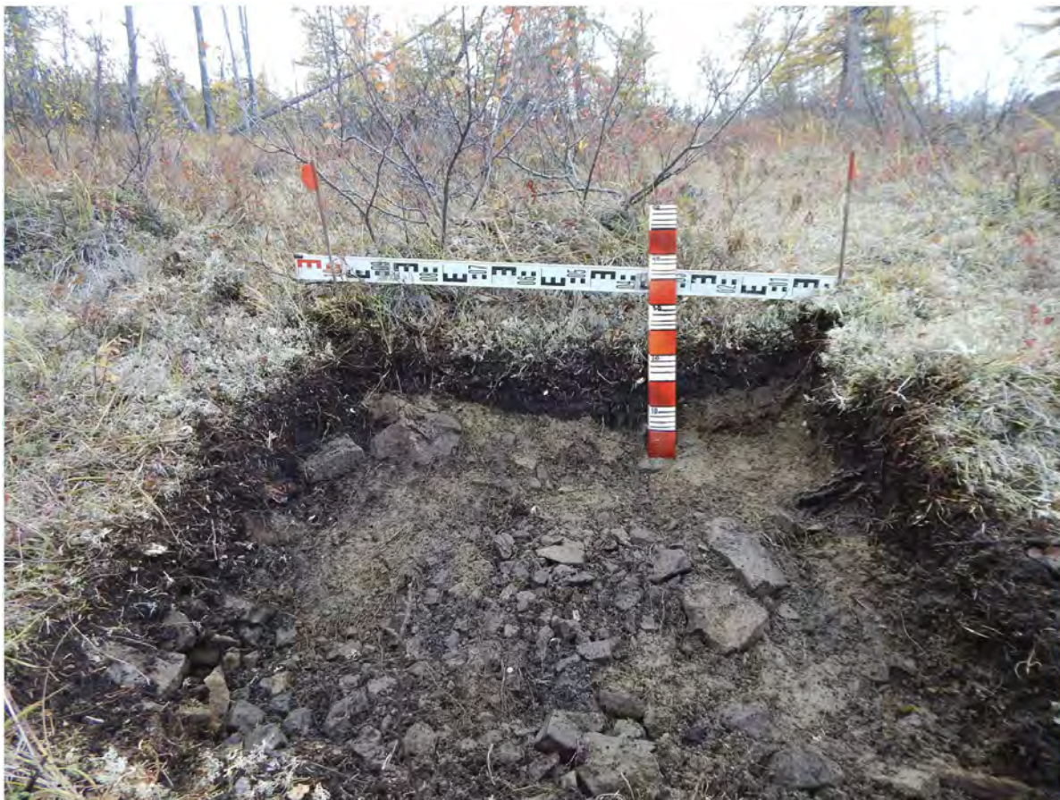
Рис. 143. СВАЭ-2022. Чукотский АО. Строительство автомобильной дороги от г. Билибино до мыса Наглёйнын. Карьеры ОПИ. Участок 44. Борт шурфа № 23. Вид с севера.
