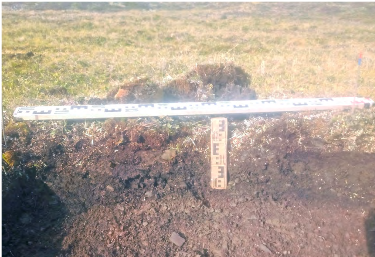
Рис. 313. СВАЭ-2022. Чукотский АО. Строительство автомобильной дороги от г. Билибино до мыса Наглёйнын. Карьеры ОПИ. Участок 59. Борт шурфа № 40. Вид с юга.
