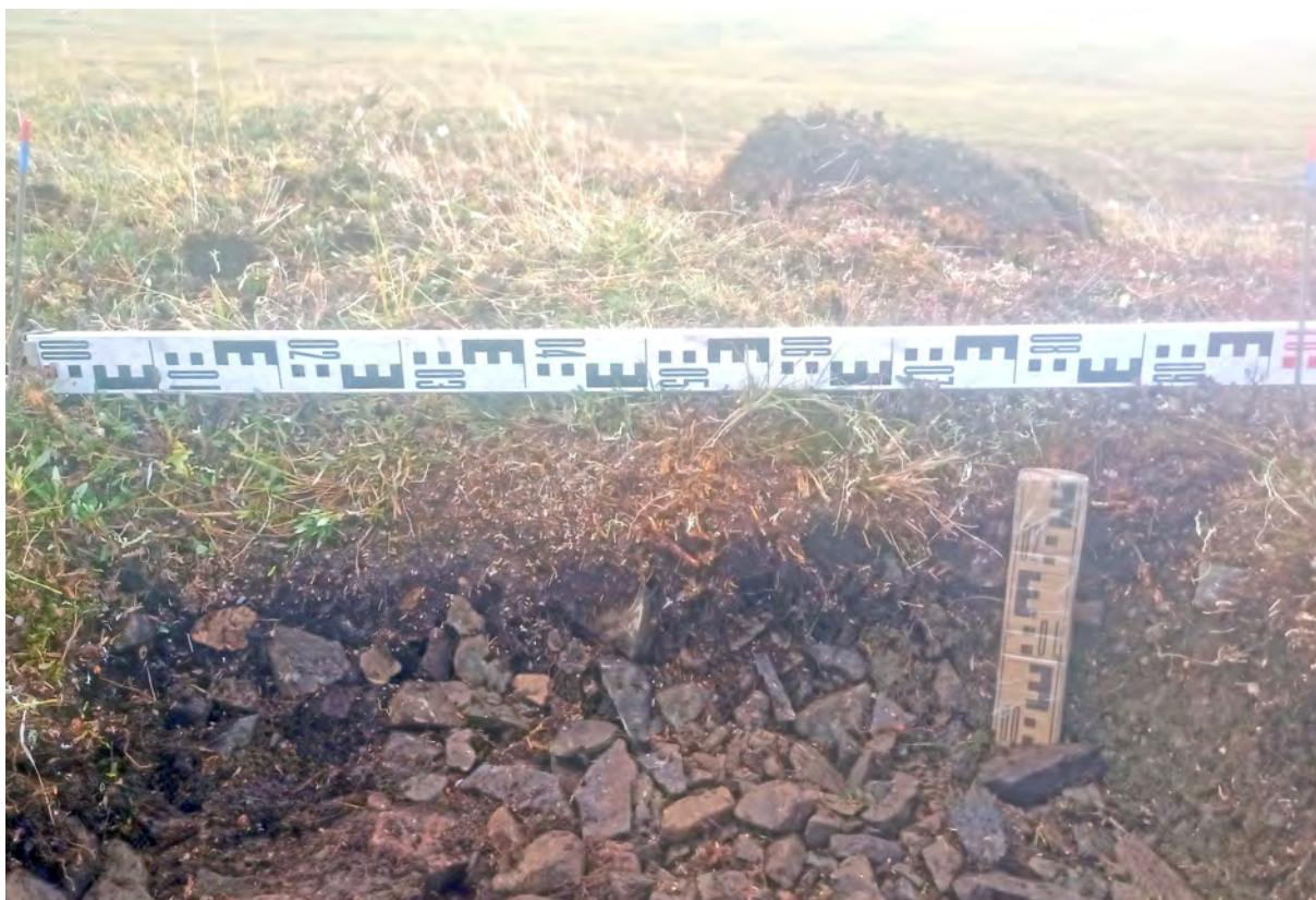
Рис. 203. СВАЭ-2022. Чукотский АО. Строительство автомобильной дороги от г. Билибино до мыса Наглёйнын. Карьеры ОПИ. Участок 48. Борт шурфа № 32. Вид с запада.
