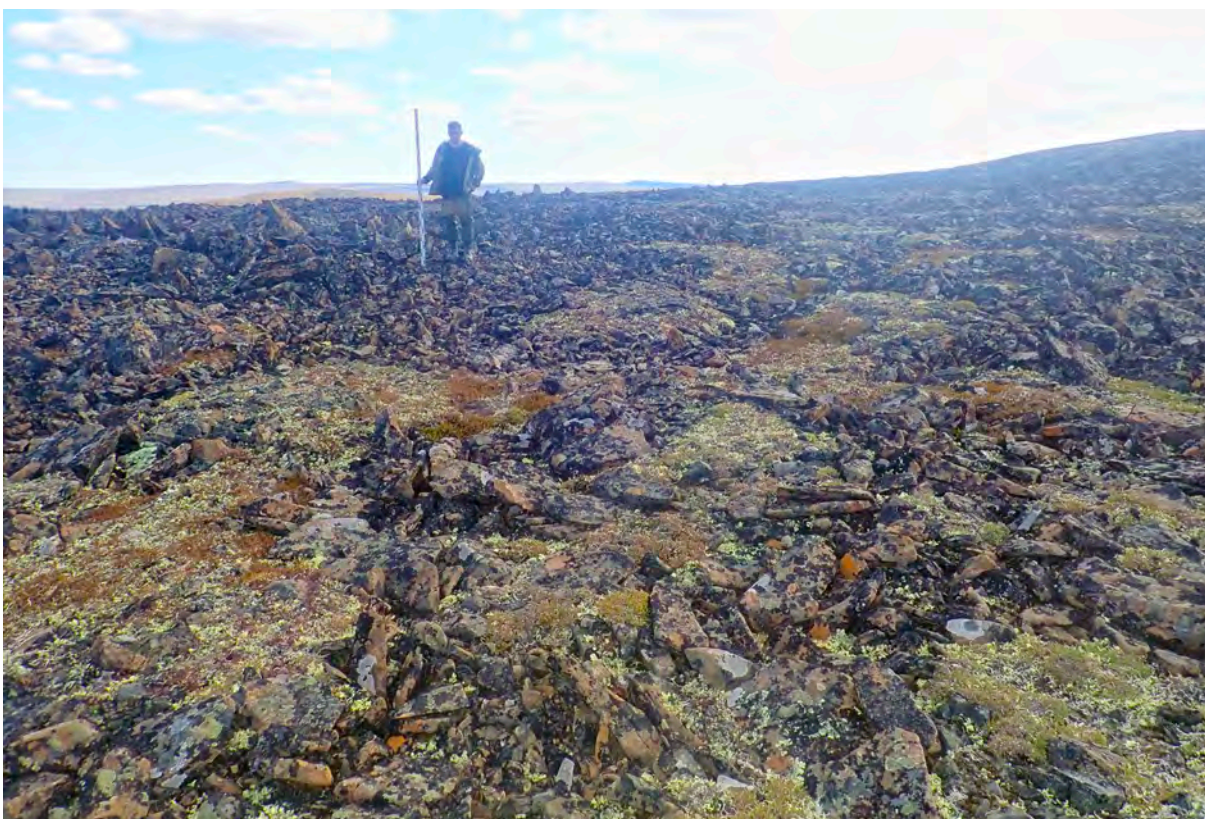
Рис. 198. СВАЭ-2022. Чукотский АО. Строительство автомобильной дороги от г. Билибино до мыса Наглёйнын. Карьеры ОПИ. Участок 48. ТФ 61. Вершина сопки в центральной части площадки карьера. Вид с севера.
