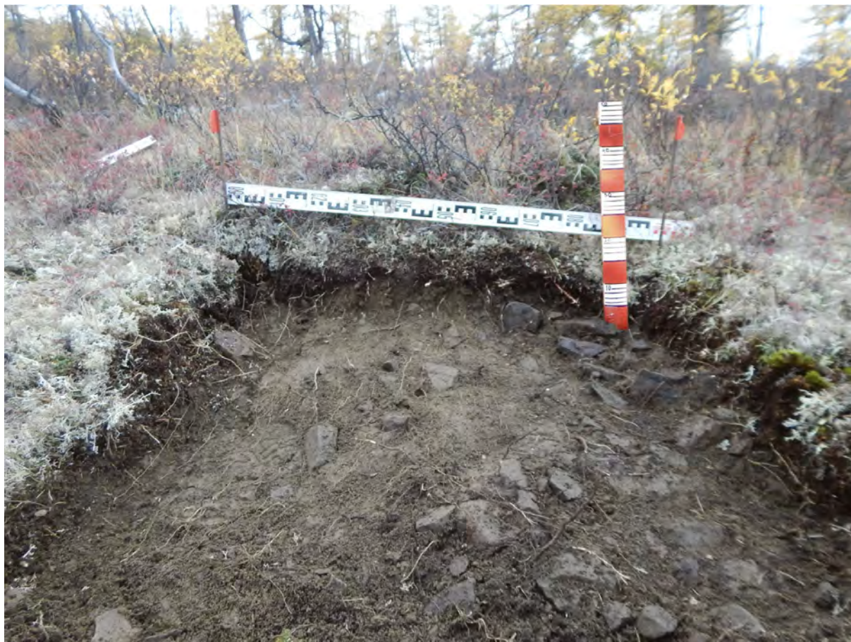
Рис. 135. СВАЭ-2022. Чукотский АО. Строительство автомобильной дороги от г. Билибино до мыса Наглёйнын. Карьеры ОПИ. Участок 44. Борт шурфа № 21. Вид с юга.
