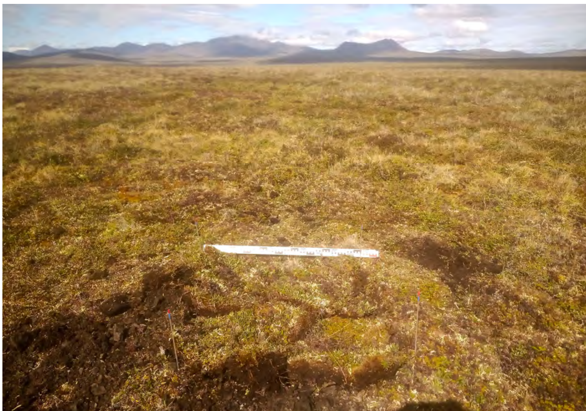
Рис. 214. СВАЭ-2022. Чукотский АО. Строительство автомобильной дороги от г. Билибино до мыса Наглёйнын. Карьеры ОПИ. Участок 49. Рекультивация шурфа № 33. Вид с юга.
