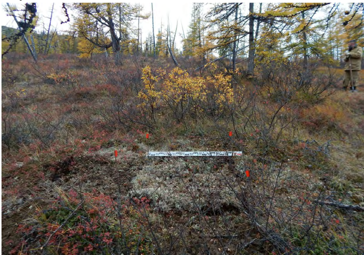
Рис. 144. СВАЭ-2022. Чукотский АО. Строительство автомобильной дороги от г. Билибино до мыса Наглёйнын. Карьеры ОПИ. Участок 44. Рекультивация шурфа № 23. Вид с севера.
