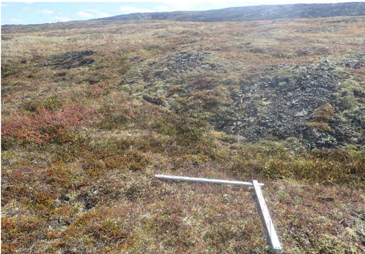
Рис. 363. СВАЭ-2022. Чукотский АО. Строительство автомобильной дороги от г. Билибино до мыса Наглёйнын. Карьеры ОПИ. Участок 62. Место расположения шурфа № 46. Вид с запада.
