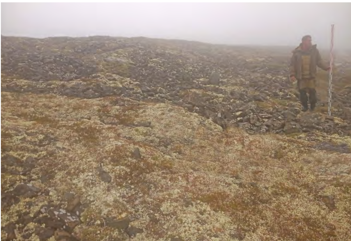
Рис. 334. СВАЭ-2022. Чукотский АО. Строительство автомобильной дороги от г. Билибино до мыса Наглёйнын. Карьеры ОПИ. Участок 61. ТФ 134. Курумники в восточной части площадки карьера. Вид с востока.
