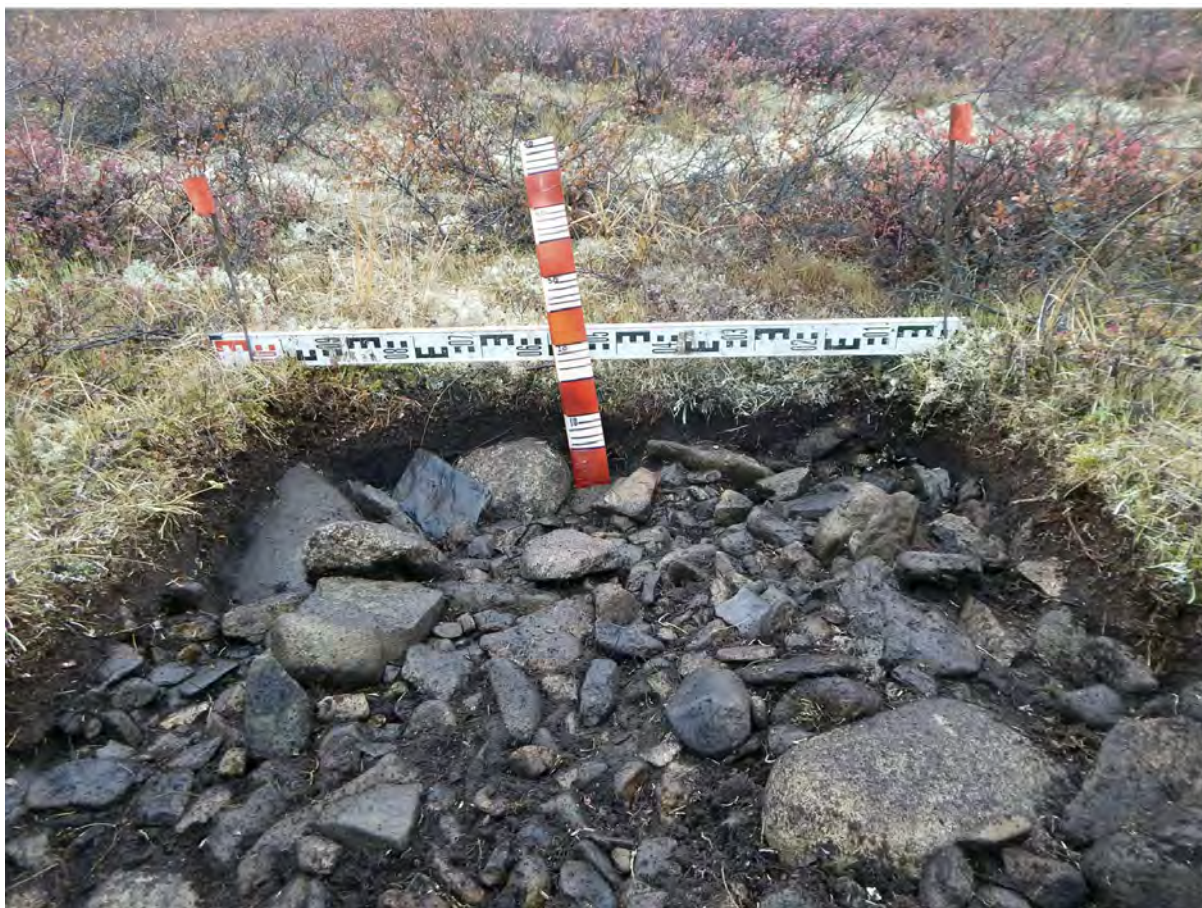
Рис. 165. СВАЭ-2022. Чукотский АО. Строительство автомобильной дороги от г. Билибино до мыса Наглёйнын. Карьеры ОПИ. Участок 45. Борт шурфа № 26. Вид с юга.
