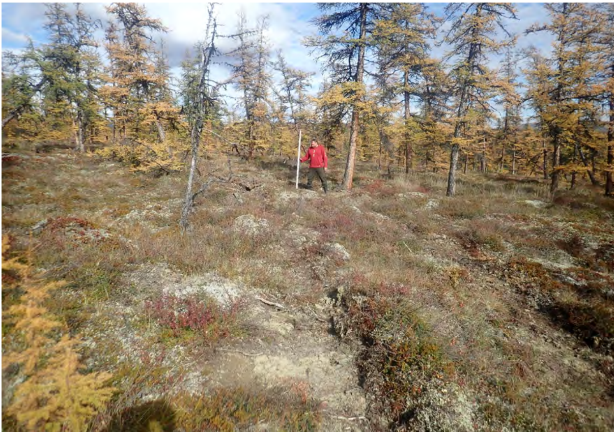
Рис. 125. СВАЭ-2022. Чукотский АО. Строительство автомобильной дороги от г. Билибино до мыса Наглёйнын. Карьеры ОПИ. Участок 44. ТФ 32. Локальные раздернованные участки на кочкарниках на склоне сопки в центральной части площадки карьера. Вид с запада.
