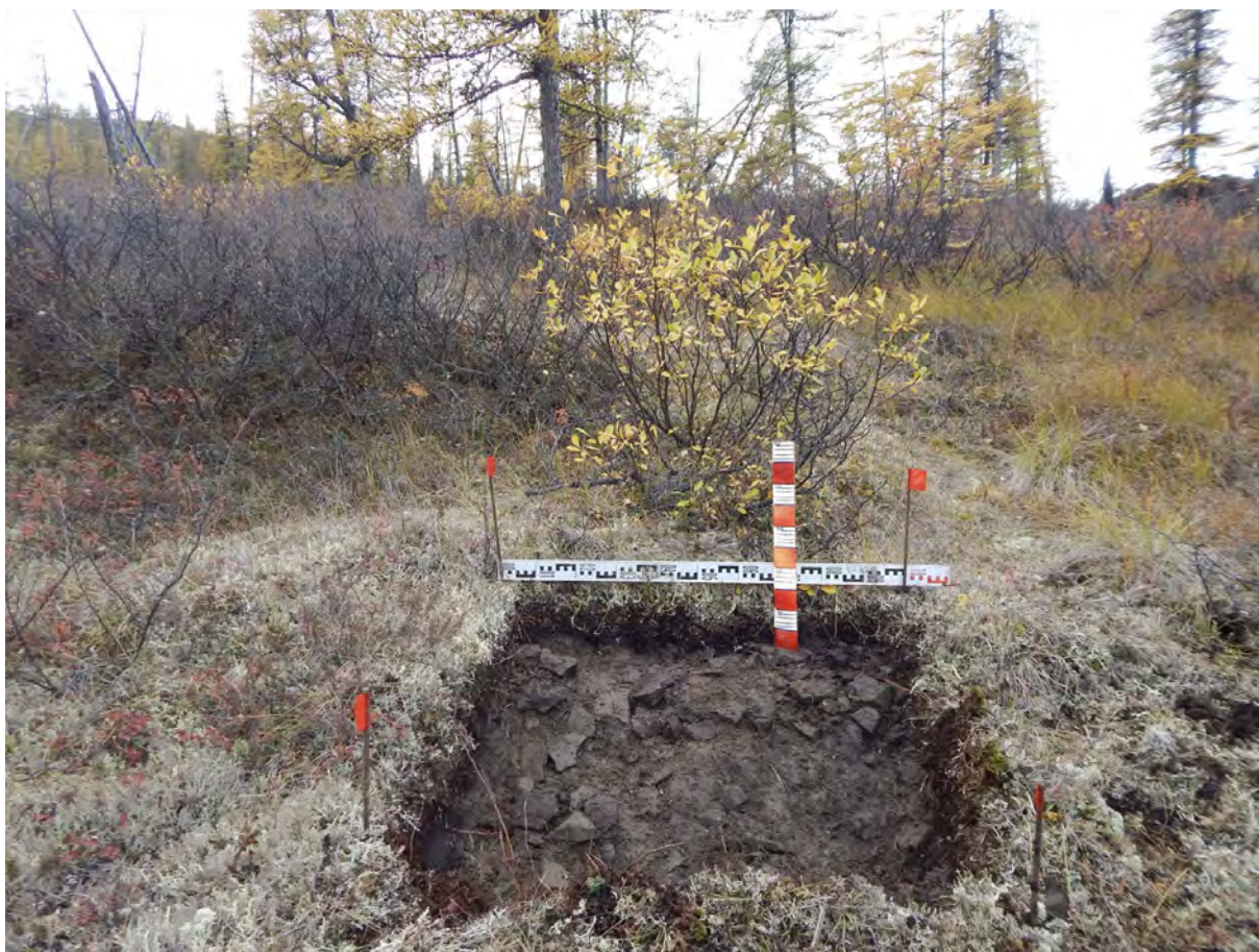
Рис. 138. СВАЭ-2022. Чукотский АО. Строительство автомобильной дороги от г. Билибино до мыса Наглёйнын. Карьеры ОПИ. Участок 44. Шурф № 22 после вскрытия. Вид с юга.
