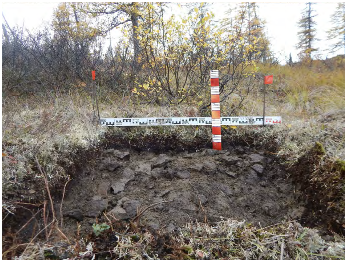
Рис. 139. СВАЭ-2022. Чукотский АО. Строительство автомобильной дороги от г. Билибино до мыса Наглёйнын. Карьеры ОПИ. Участок 44. Борт шурфа № 22. Вид с юга.
