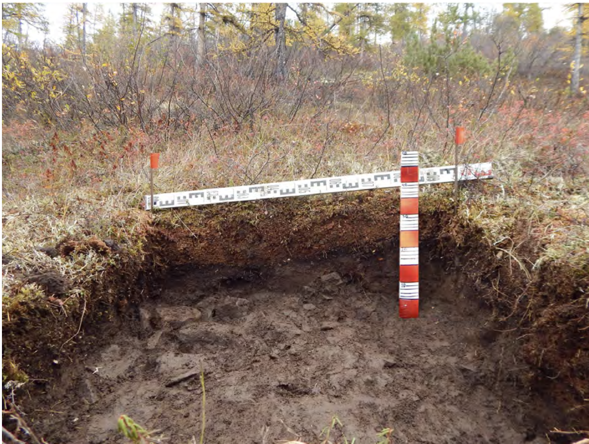
Рис. 173. СВАЭ-2022. Чукотский АО. Строительство автомобильной дороги от г. Билибино до мыса Наглёйнын. Карьеры ОПИ. Участок 45. Борт шурфа № 28. Вид с юга.
