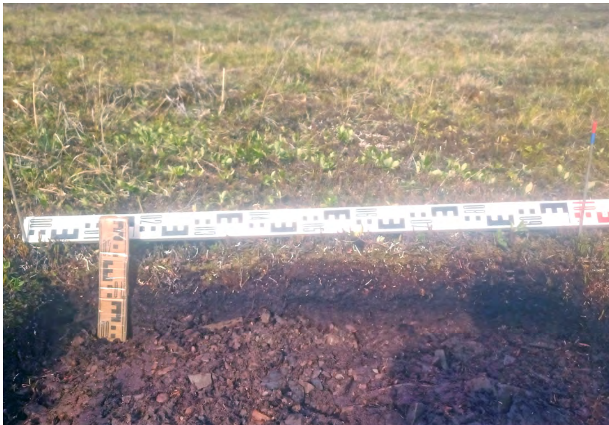
Рис. 357. СВАЭ-2022. Чукотский АО. Строительство автомобильной дороги от г. Билибино до мыса Наглёйнын. Карьеры ОПИ. Участок 62. Борт шурфа № 44. Вид с запада.
