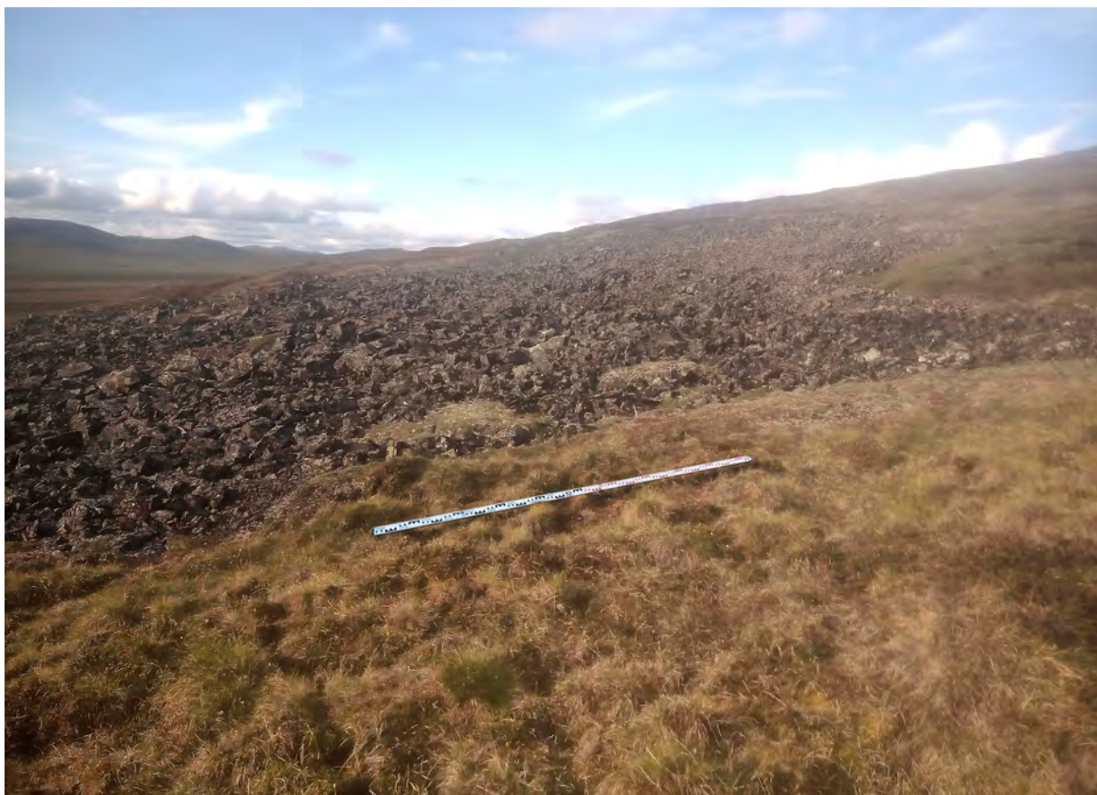
Рис. 232. СВАЭ-2022. Чукотский АО. Строительство автомобильной дороги от г. Билибино до мыса Наглёйнын. Карьеры ОПИ. Участок 51. ТФ 75. Курумники в восточной части площадки карьера. Вид с севера.
