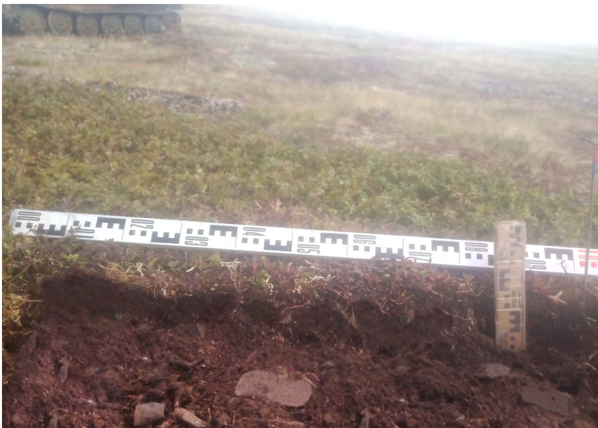
Рис. 187. СВАЭ-2022. Чукотский АО. Строительство автомобильной дороги от г. Билибино до мыса Наглёйнын. Карьеры ОПИ. Участок 47. Борт шурфа № 30. Вид с востока.
