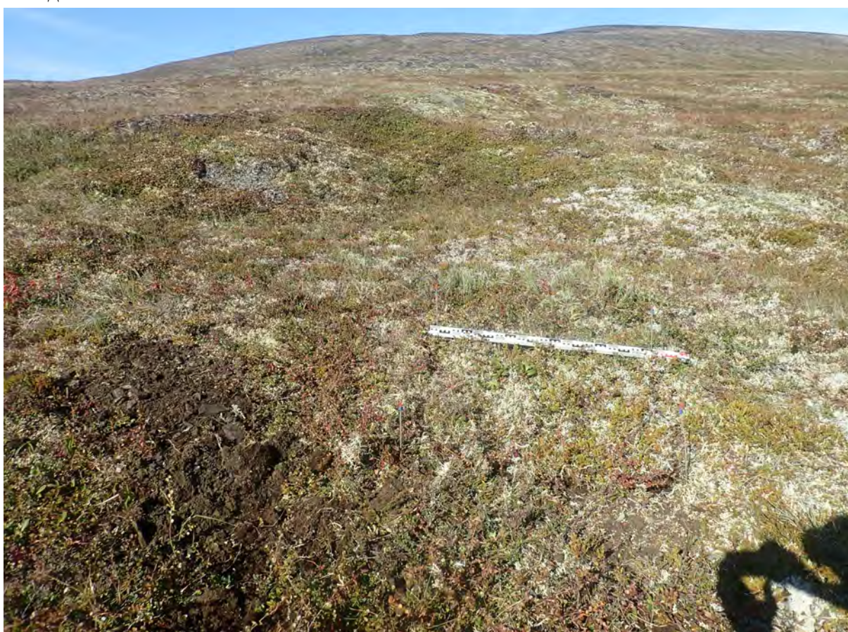
Рис. 362. СВАЭ-2022. Чукотский АО. Строительство автомобильной дороги от г. Билибино до мыса Наглёйнын. Карьеры ОПИ. Участок 62. Рекультивация шурфа № 45. Вид с запада.
