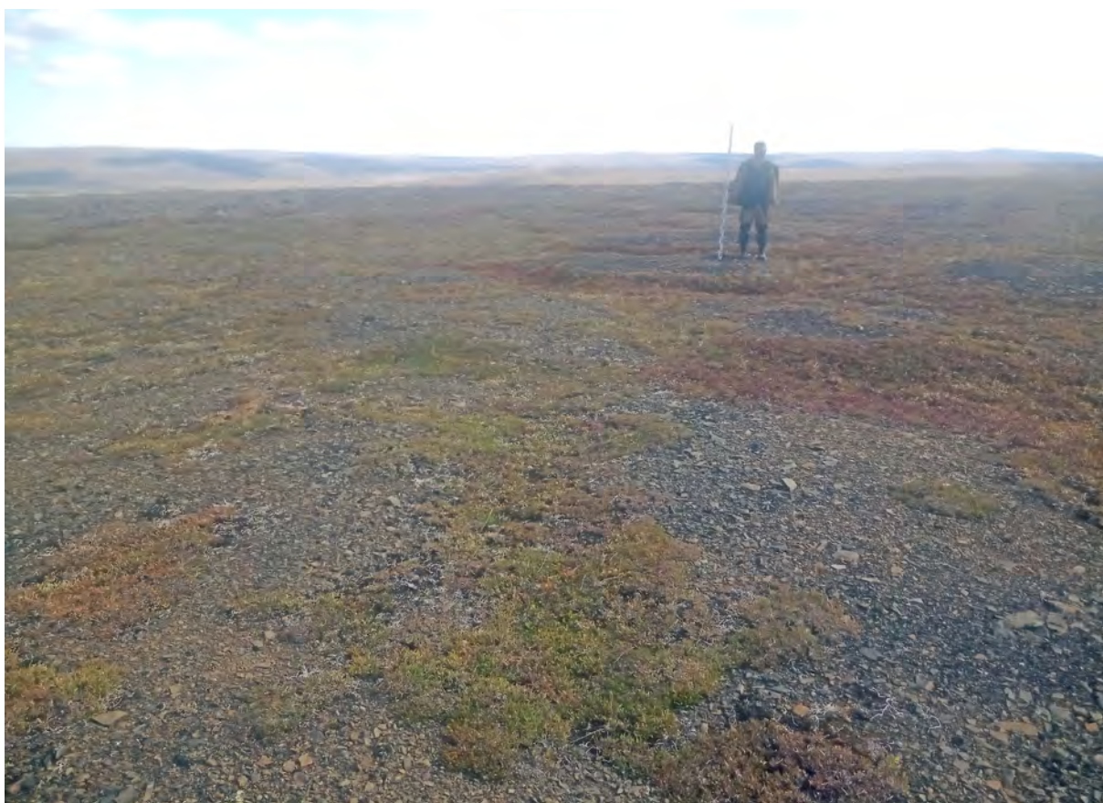
Рис. 348. СВАЭ-2022. Чукотский АО. Строительство автомобильной дороги от г. Билибино до мыса Наглёйнын. Карьеры ОПИ. Участок 62. ТФ 138. Раздернованные участки на плоской вершине сопки в центральной части площадки карьера. Вид с юго-запада.
