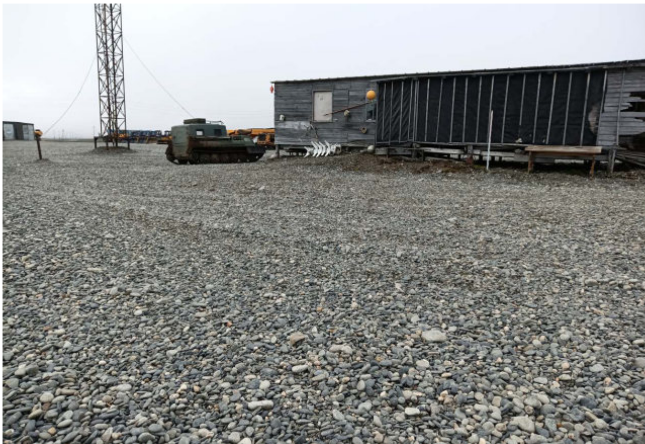
Рис. 46. Чукотский АО, городской округ Певек (Чаунский район), Месторождение “Ручей Факторийный”, 2023 год. Отсыпанная площадка под жилую зону. ТФ106.
