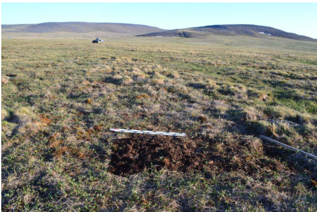
Рис. 112. Чукотский АО, городской округ Певек (Чаунский район), Месторождение “Ручей Факторийный”, 2023 год. Шурф 8. Рекультивация.
