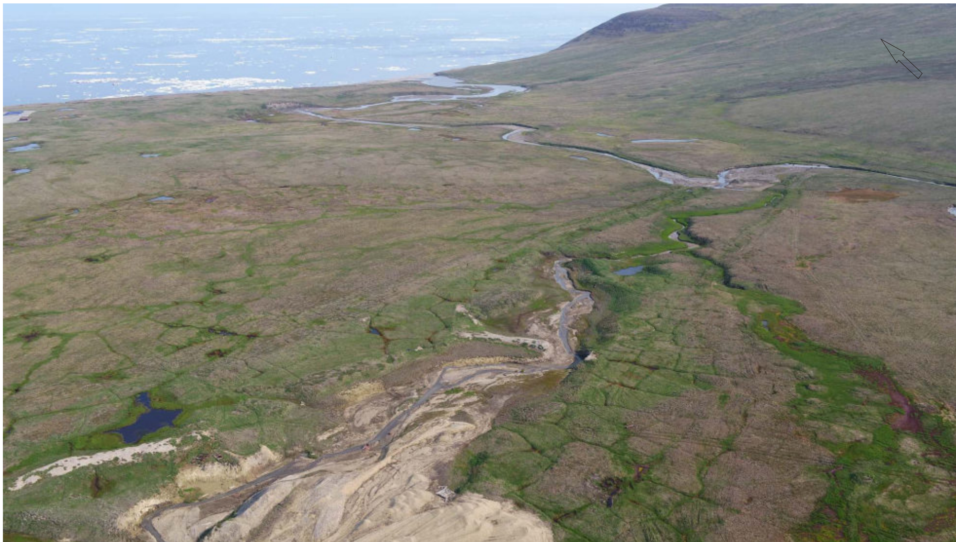
Рис. 30. Чукотский АО, городской округ Певек (Чаунский район), Месторождение "Ручей Факторийный", 2023 год. Общий вид на приустьевой участок долины руч. Факторийный и устье десятого ручья, - лев. притока руч. Факторийный с нарушенными землями в среднем течении. Точка фотофиксации К7 (высота 200 м)
