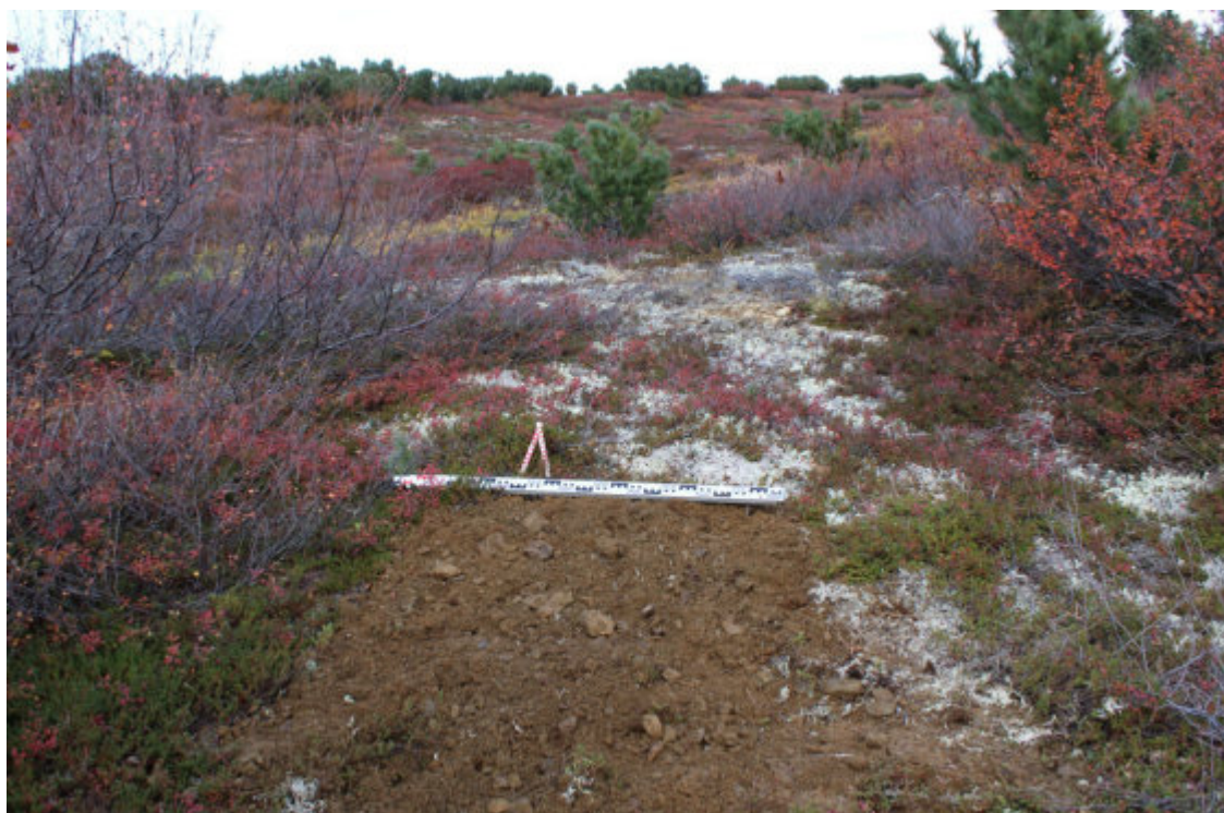
Рис. 155. Анадырский муниципальный район ЧАО. Земельный участок кадастровый номер 87:04:010005:337 (месторождение Нутэкингенкывеем). Южный сектор. Площадка возле юг-юго-восточных границ участка. Рекультивация шурфа №25. Вид с Ю.
