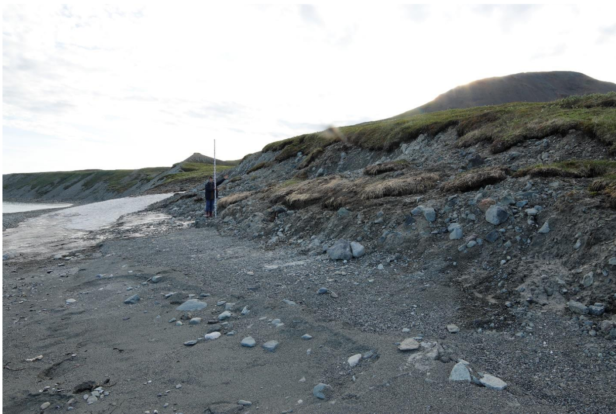
Рис. 19, ЧАЭ-2023, Мыс Опасный, обвал береговой террасы, вид юга, скальные выходы
