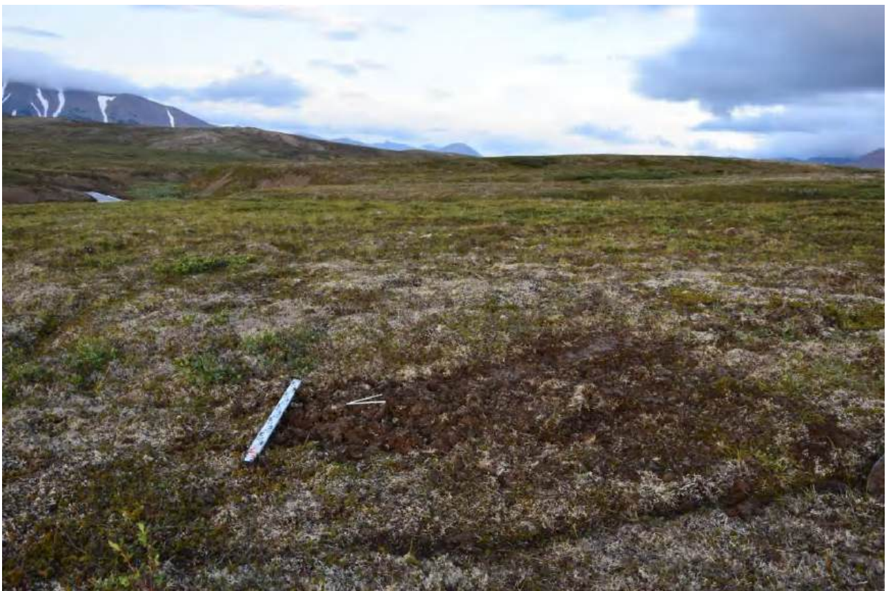
Рис. 342. Чукотский АО, Анадырский р-н, проект “Месторождение Амаамское (участок Западный)”, 2024 г. Шурф №60 после засыпки.
