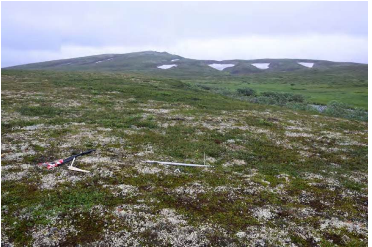
Рис. 209. Чукотский АО, Анадырский р-н, проект “Месторождение Амаамское (участок Западный)”, 2024 г. Шурф №35 (т.469). Закладка шурфа.
