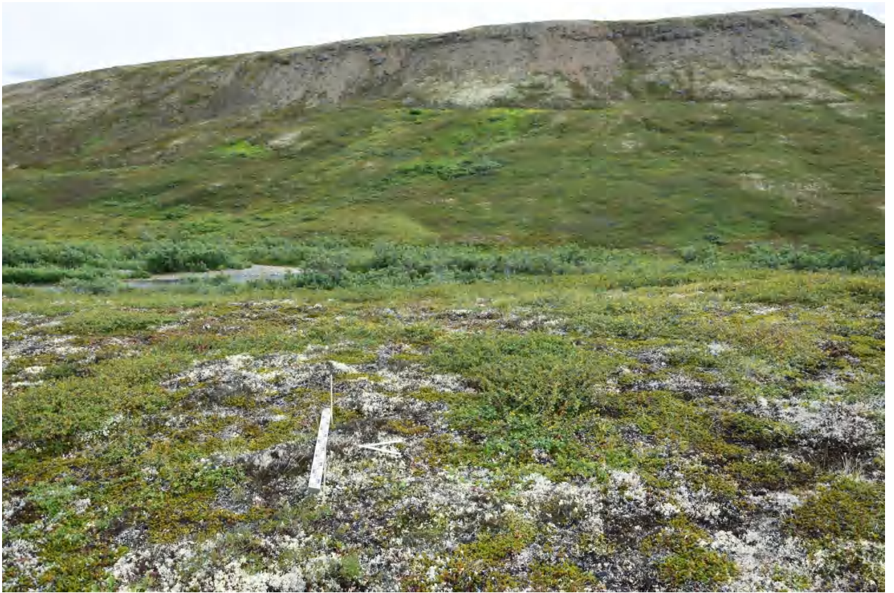
Рис. 287. Чукотский АО, Анадырский р-н, проект “Месторождение Амаамское (участок Западный)”, 2024 г. Шурф №50 (т. 413). Закладка шурфа. Направление
