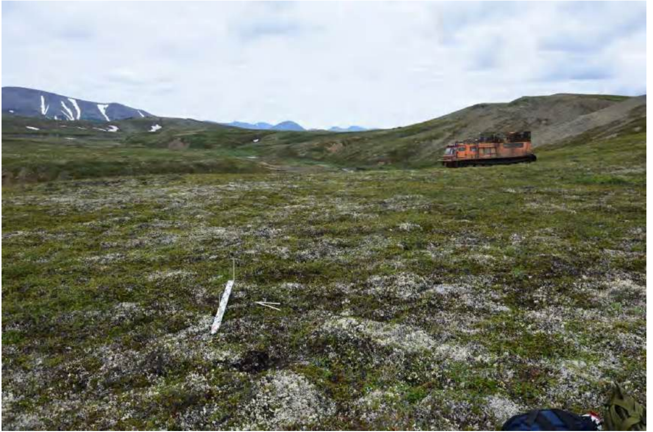
Рис. 429. Чукотский АО, Анадырский р-н, проект “Месторождение Амаамское (участок Западный)”, 2024 г. Шурф №78 (т. 286). Закладка шурфа.
