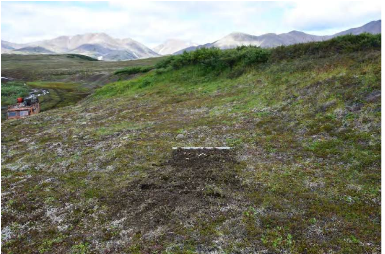
Рис. 471. Чукотский АО, Анадырский р-н, проект “Месторождение Амаамское (участок Западный)”, 2024 г. Шурф №86 после засыпки.
