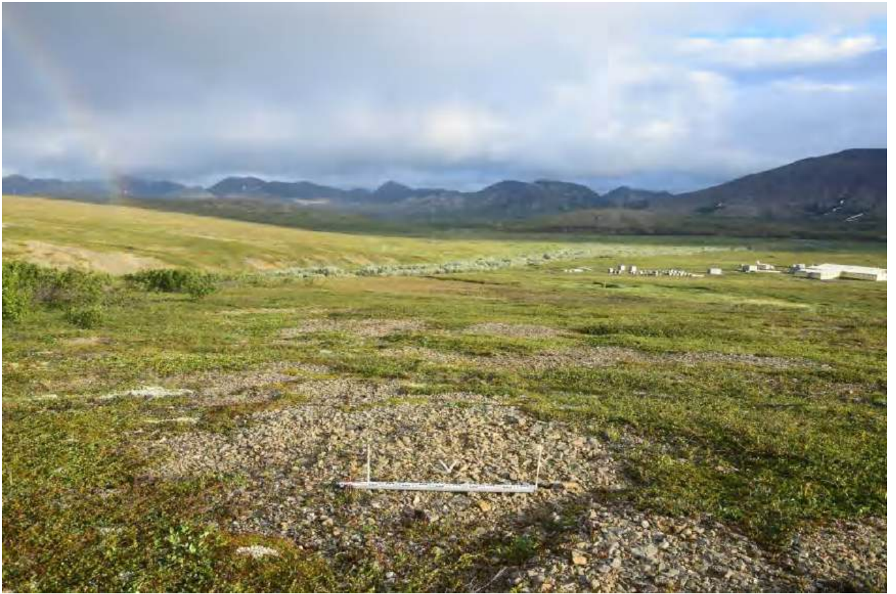
Рис. 50. Чукотский АО, Анадырский р-н, проект “Месторождение Амаамское (участок Западный)”, 2024 г. Шурф №9 (т.234). Закладка шурфа.
