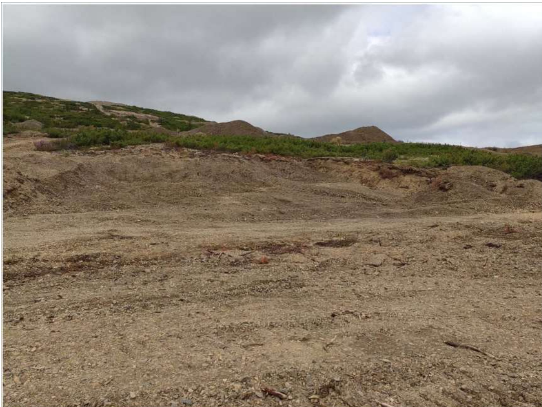
Рис. 12. «Баимский ГОК. Проект медного месторождения «Песчанка». Открытые горные работы». Западный участок. Характер техногенных изменений ландшафта. Вид с востока. ТФ 12.
