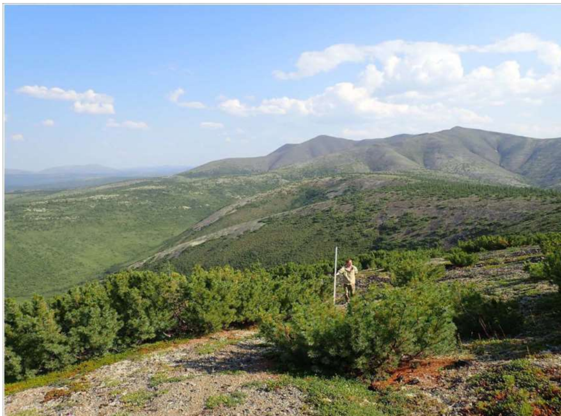
Рис. 28. «Баимский ГОК. Проект медного месторождения «Песчанка». Открытые горные работы». Восточный участок. Общий вид с севера. ТФ 28.
