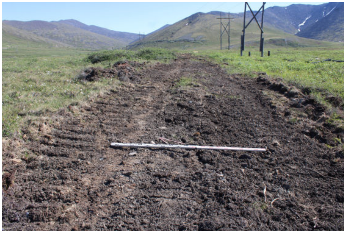
Рис. 52. Билибинский район ЧАО. Земельный участок объекта: «Склад АХОВ». Северный сектор землеотвода. Технологический проезд, линия электропередач. Вид с СЗ. тф. 13.
