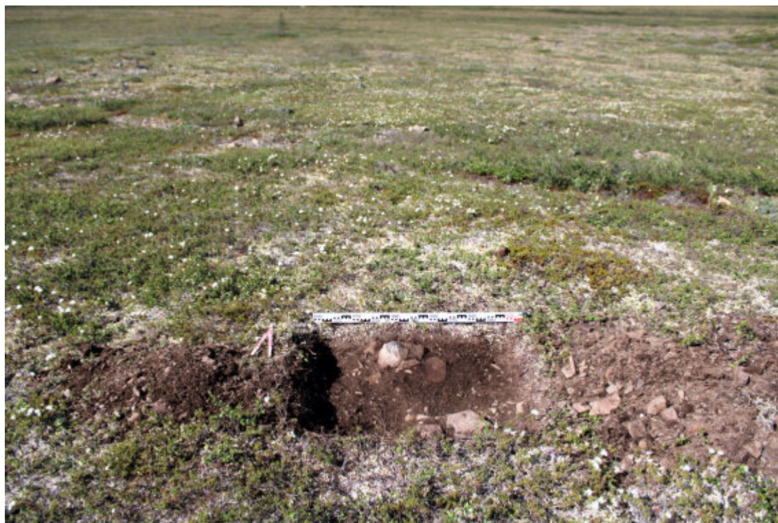
Рис. 126. Билибинский район ЧАО. Земельный участок объекта: «Склад АХОВ». Южный сектор землеотвода. Северная стенка шурфа №9. Вид с Ю.
