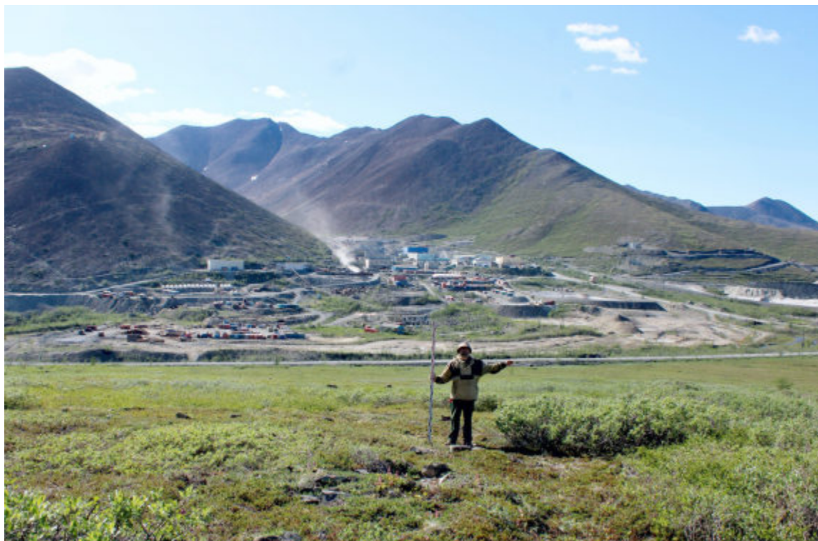
Рис. 132. Билибинский район ЧАО. Земельный участок объекта: «Склад АХОВ». Южный сектор землеотвода. Вид с В. тф. 49.
